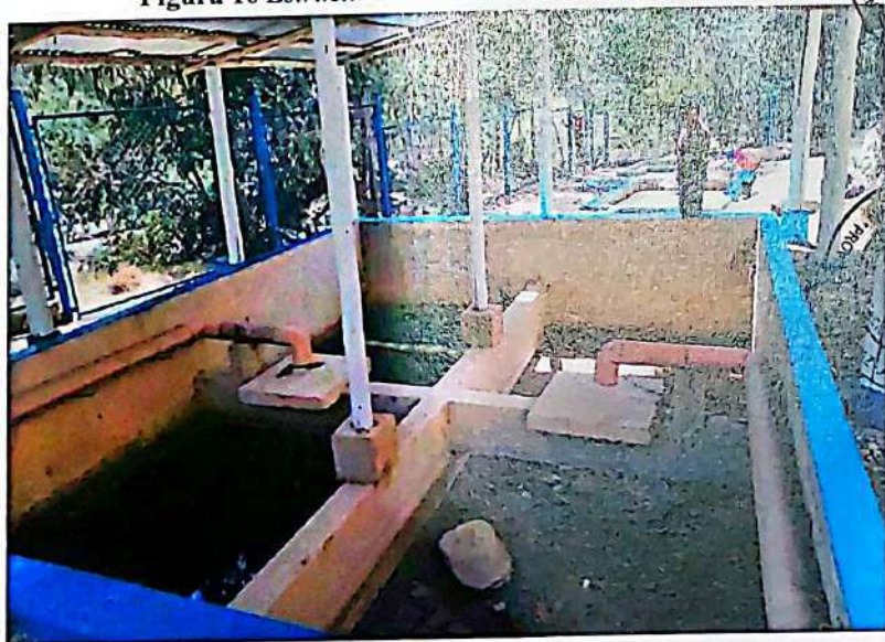
Figura 10 Estructura del PTAR del caserío de Paltay
