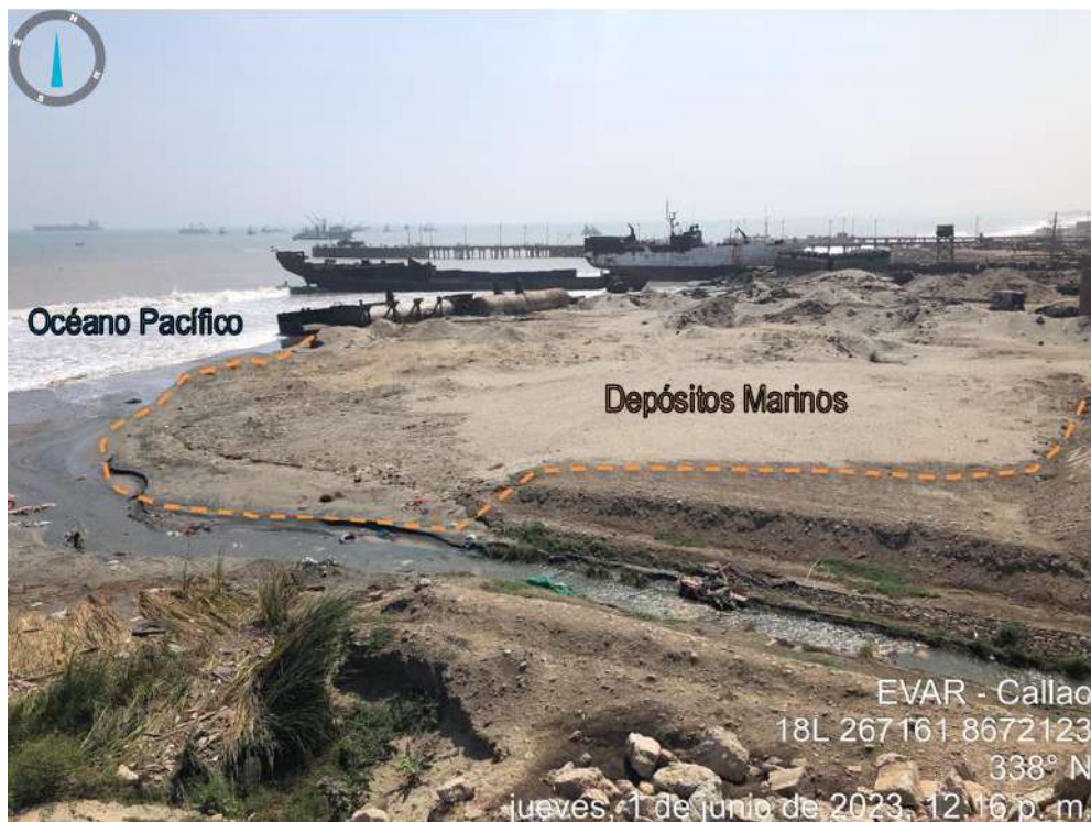
Figura N° 4. Depósitos Marinos (muelle centenario)
