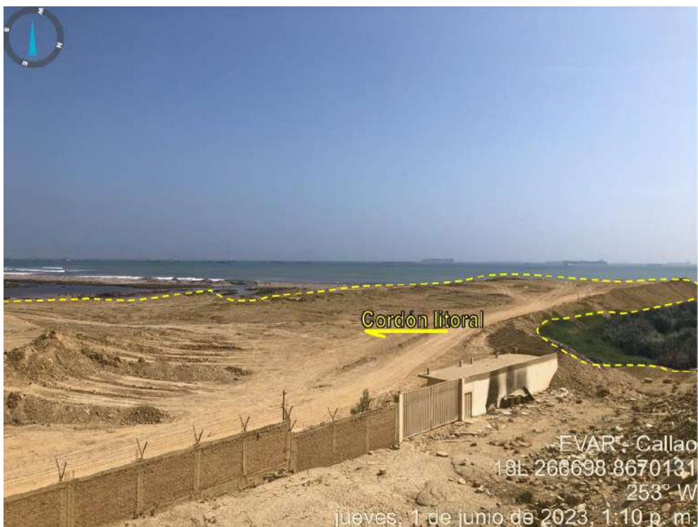
Figura N° 9. Se observa el cordón litoral.
