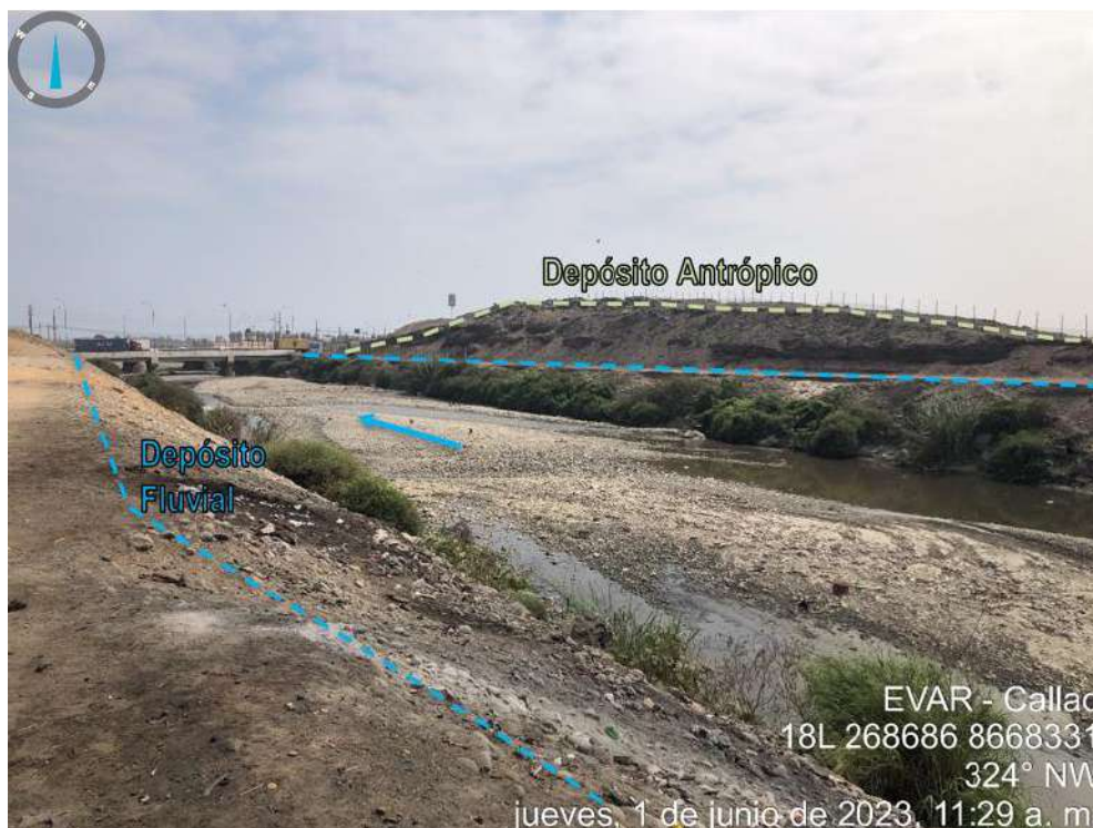
Figura N° 2. Depósitos fluviales (Puente Gambetta).
