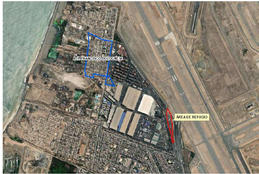
Área de refugio N° 2 – ubicada al lado izquierdo de la entrada al túnel de la Av. Néstor Gambetta.
