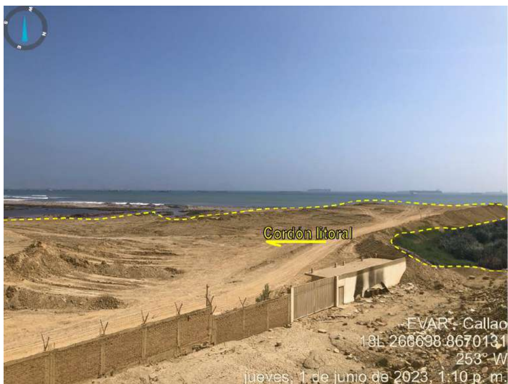
Figura N° 9. Se observa el cordón litoral.
