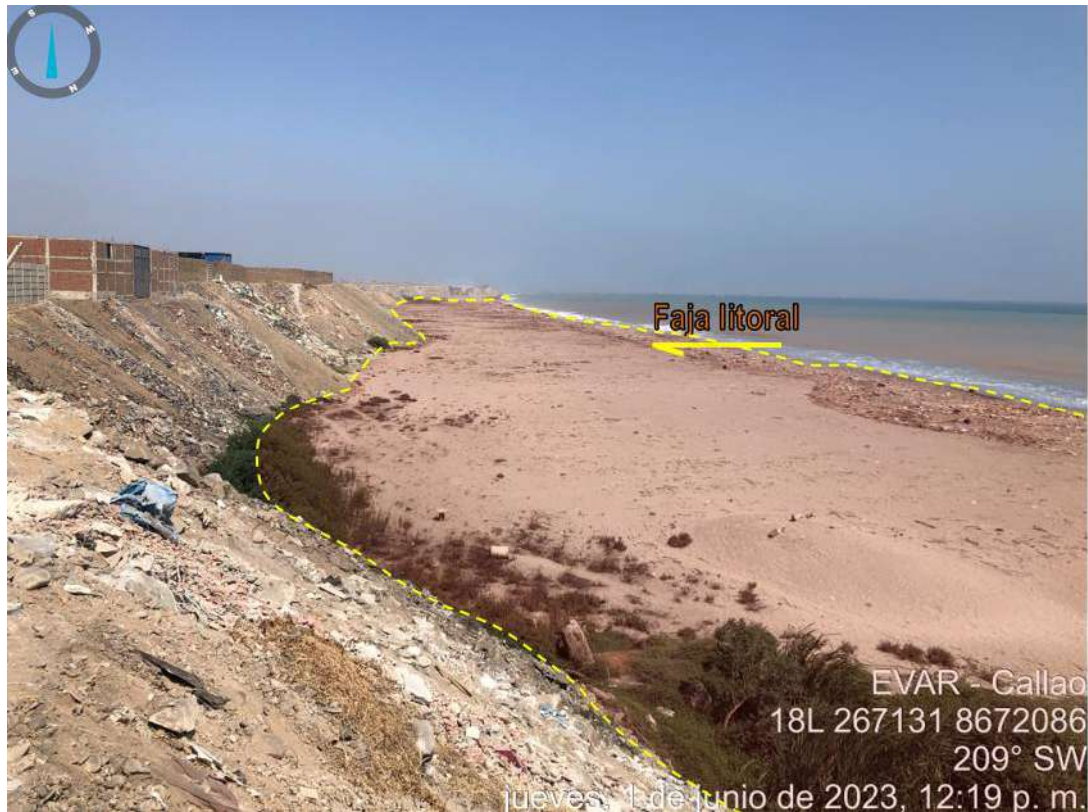
Figura N° 9. Se observa la faja litoral ubicada frente al cementerio de barcos Gambetta.
