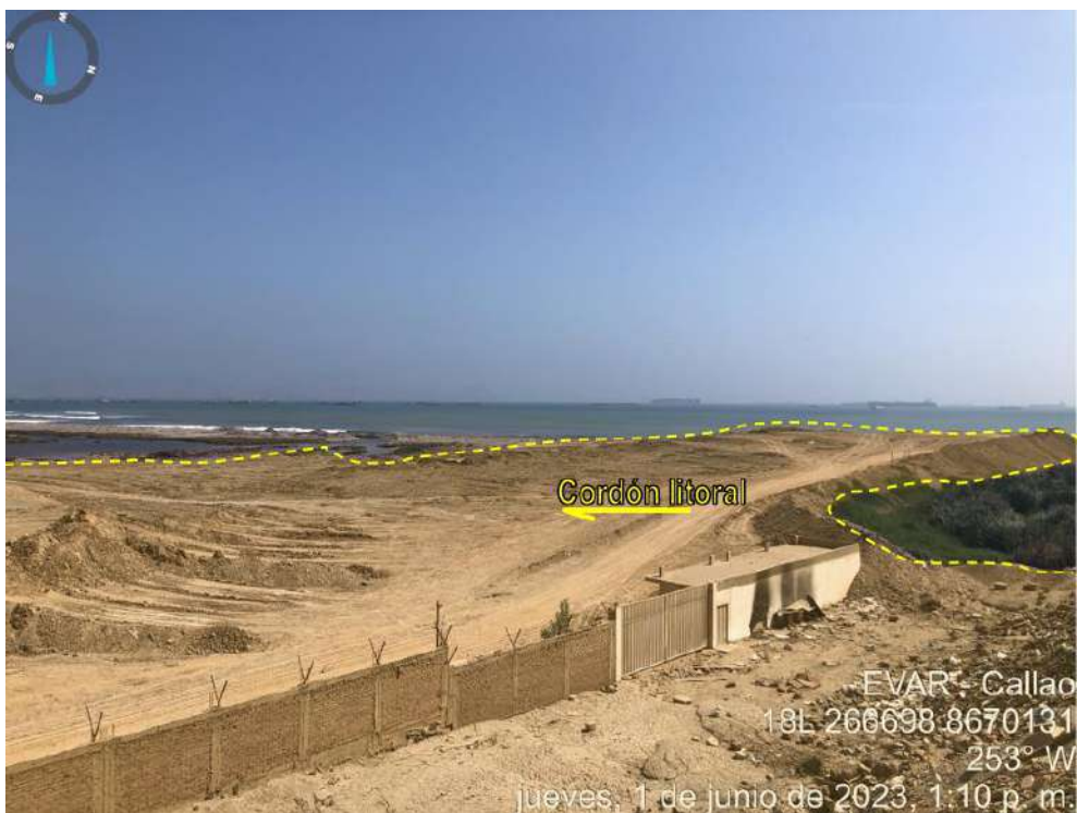
Figura N° 10. Se observa el cordón litoral.
