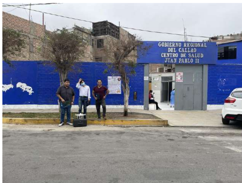
Equipo técnico realizando levantamiento fotogramétrico con Drone phantom 4. Punto ubicado al frontis del centro de salud Juan Pablo II.
