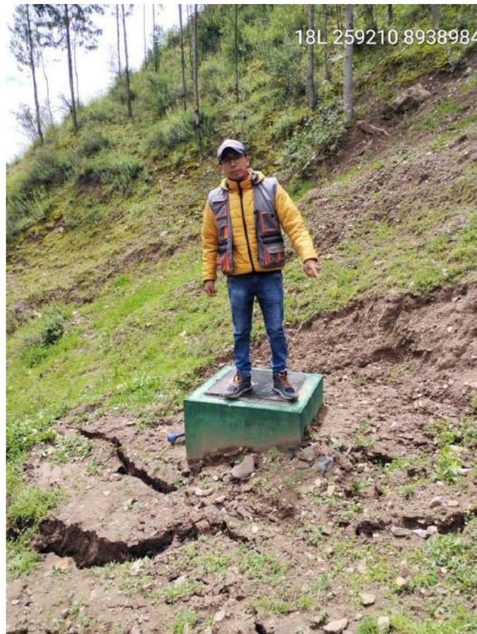
*Fotografía. 6. Se puede apreciar las grietas existentes en los sembríos y el sistema de riego del caserío de Nunupata.*
