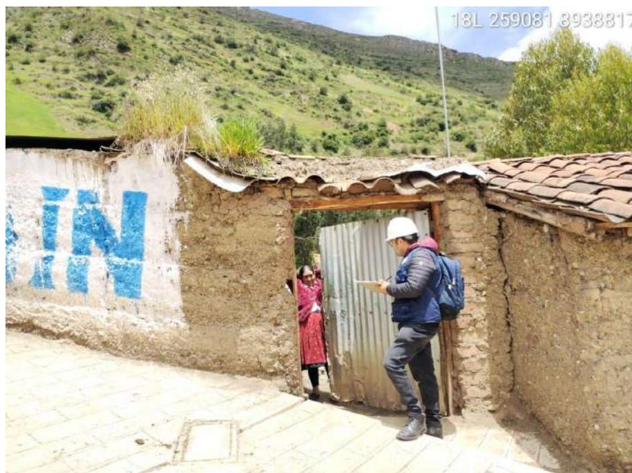
*Fotografía. 12. Se puede apreciar al equipo técnico realizando la toma de datos para poder evaluar la vulnerabilidad de las viviendas en el caserío de Nunupata.*
