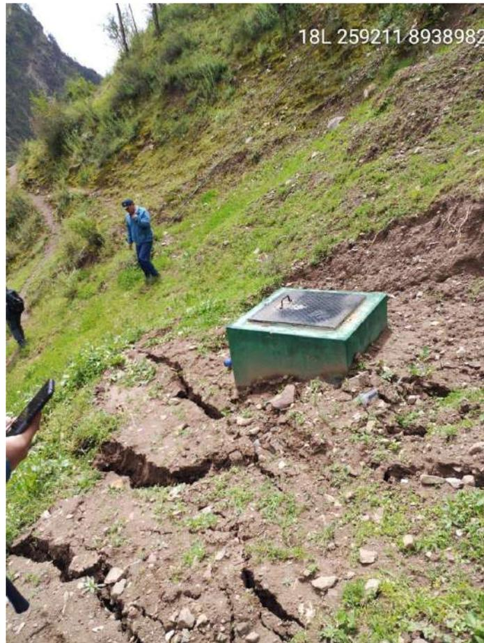
*Fotografía. 7 .Se puede apreciar las grietas existentes en los sembríos y el sistema de riego del caserío de Nunupata.*
