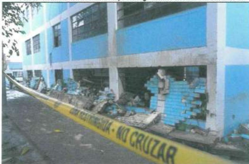
Foto N° 11. Pared colapsada y aulas inundadas
