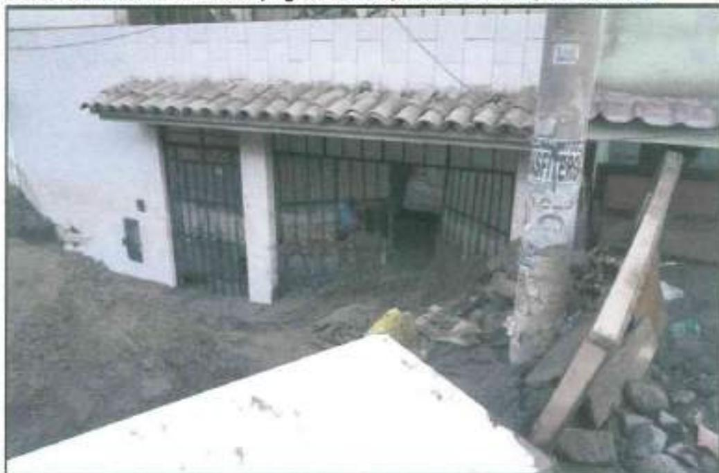
Foto N° 9. Acceso por puerta de primer piso inhabilitado por el flujo de detritos y lodo, 16 marzo 2023.
