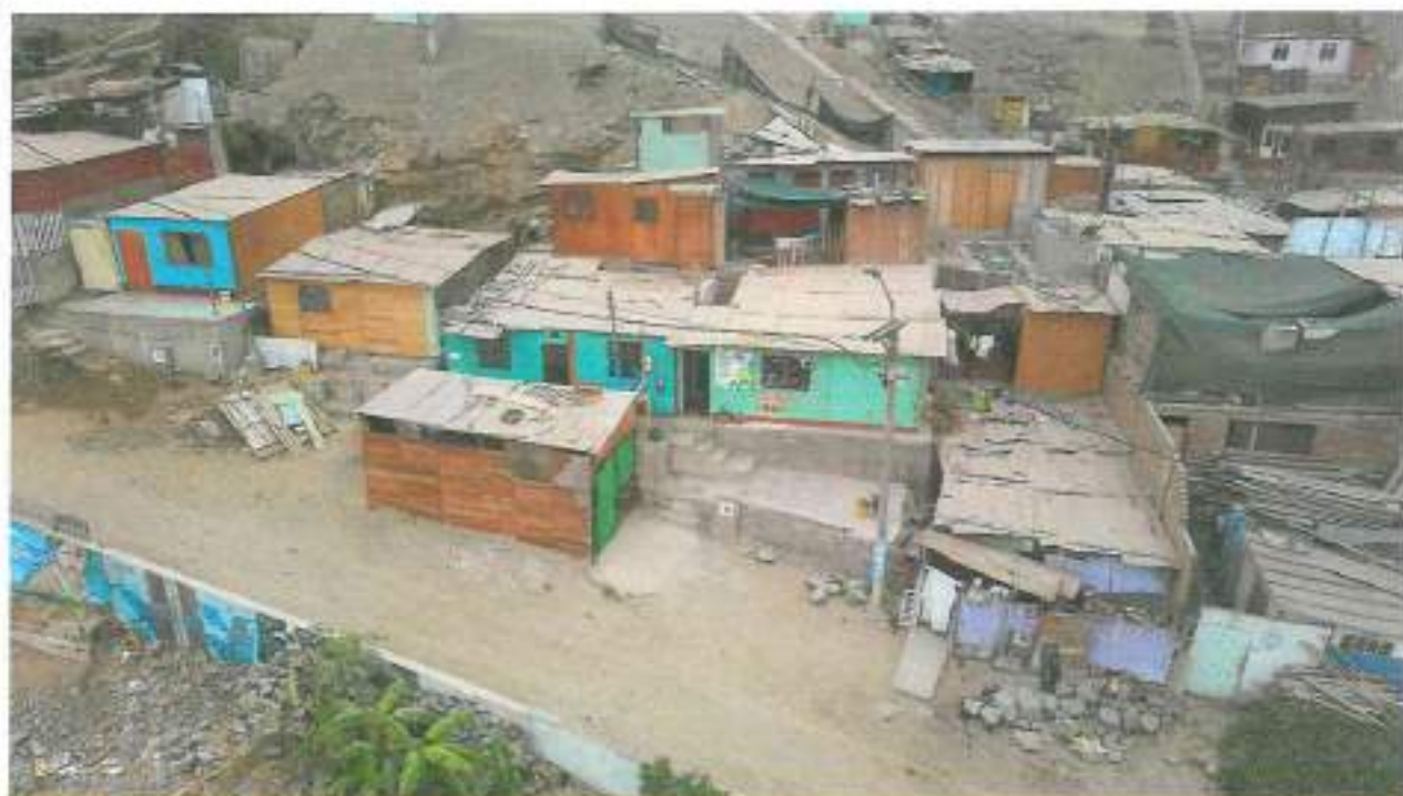
Fotografía N° 7.- Identificación de características de elementos expuestos y condiciones de fragilidad de las viviendas de la manzana 11
