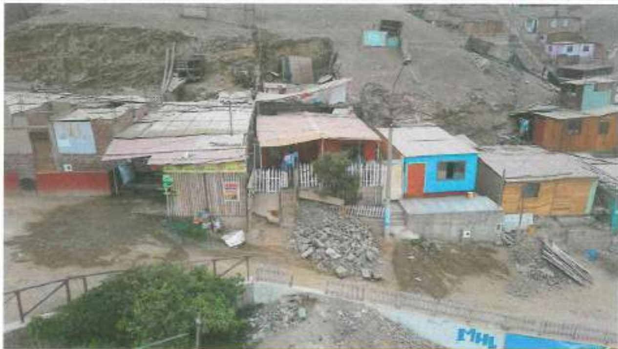
Fotografía N° 8.- Identificación de características físicas de lotes manzana 11
