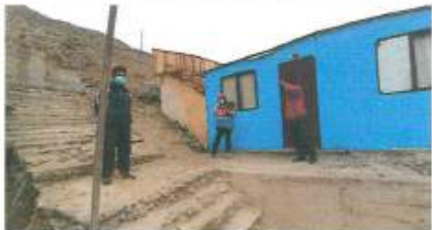
Fotografía N° 4.- verificación de las condiciones de seguridad física de escalera y viviendas
