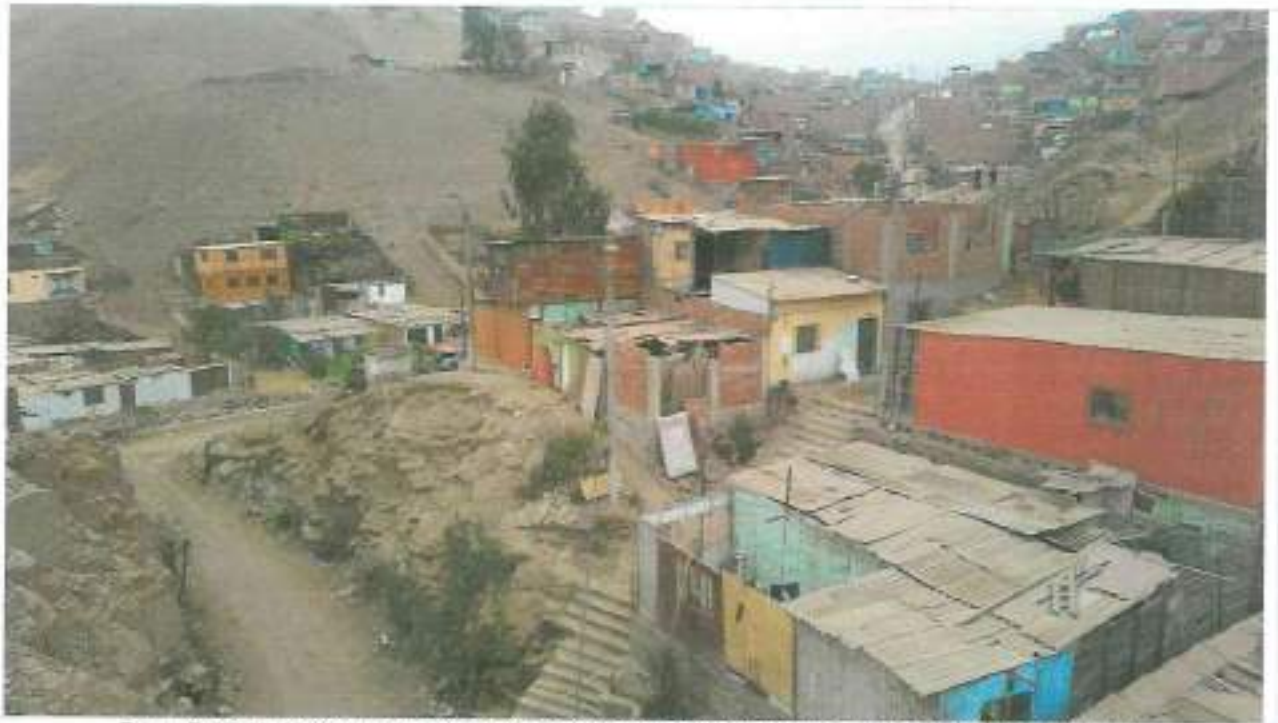
Fotografía N° 11.- Vista aérea de la escalera de acceso entre las manzanas 9 y 9', estado de escalera en mal estado
