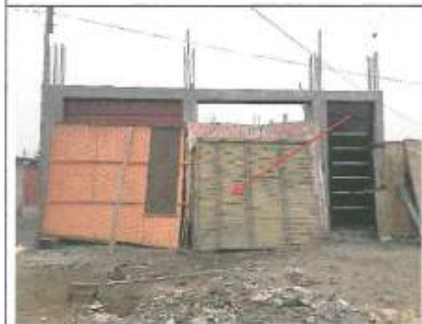
Fotografía N°3.- Lote en construcción
