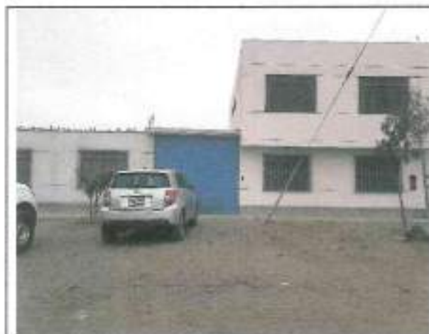
Fotografía N°1.- Lote de albañilería de dos pisos
