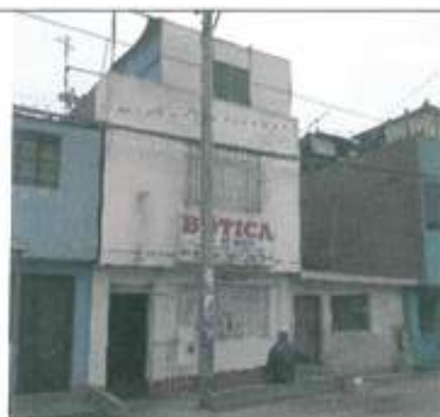
Viviendas con comercio en la Av. Del Trabajo
