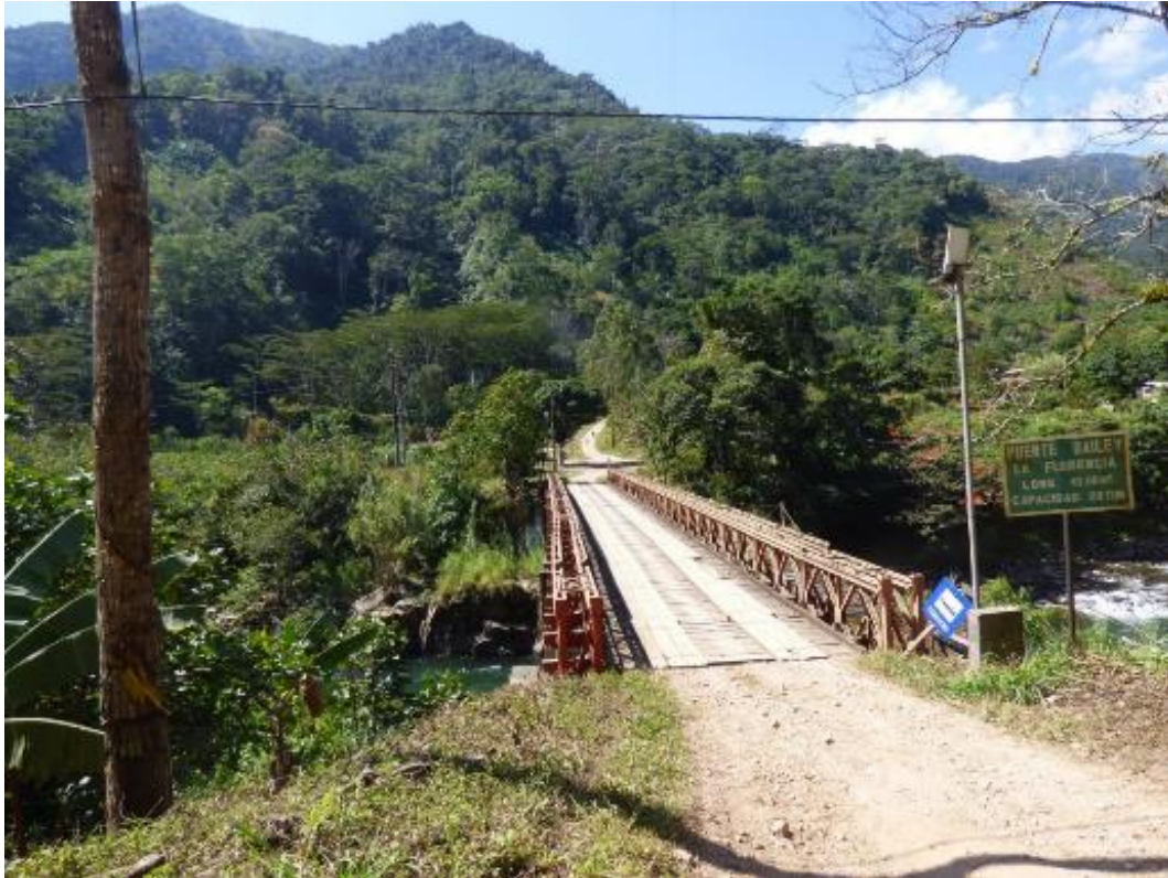
Fotografía 1. Puente Bailey, ingreso al Anexo La Florencia (E 464179.17, N 8757255.41).
