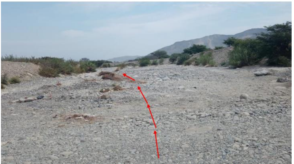
Ilustración 35. Identificación de punto crítico en el sector rinconada dentro del distrito de Buena Vista Alta
