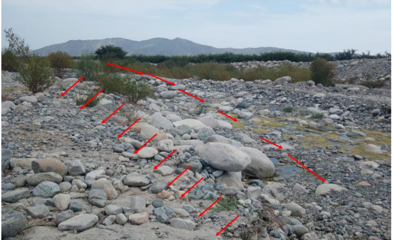
Ilustración 36. Identificación de punto crítico en el sector rinconada dentro del distrito de Buena Vista Alta
