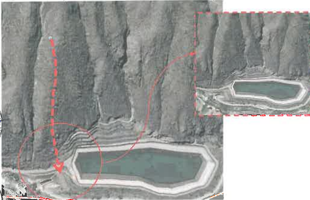
Ilustración 106: Exposición ante deslizamiento rotacional -represa N° 2 de Hidrandina
