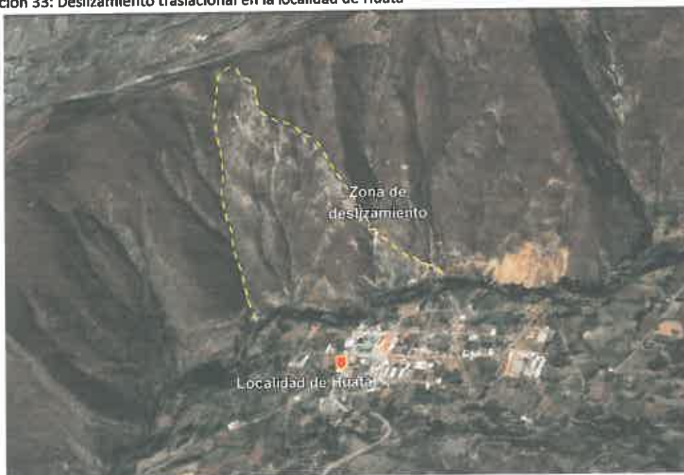
Ilustración 33: Deslizamiento traslacional en la localidad de Huata
