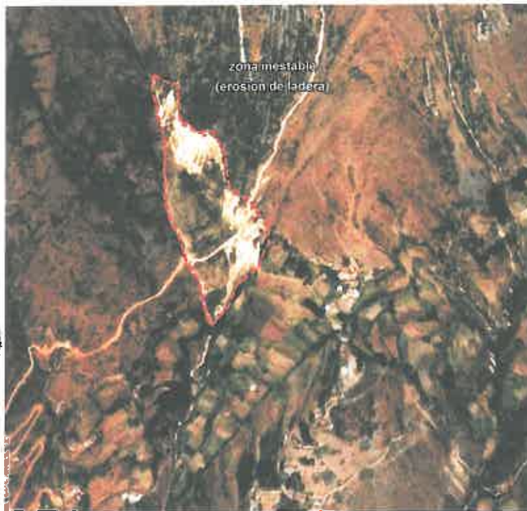
Ilustración 24: Erosión de ladera- Frente al C.P. Coto
