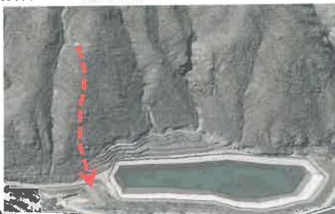
Ilustración 60: Deslizamiento rotacional en la represa N° 2 de Hidrandina
