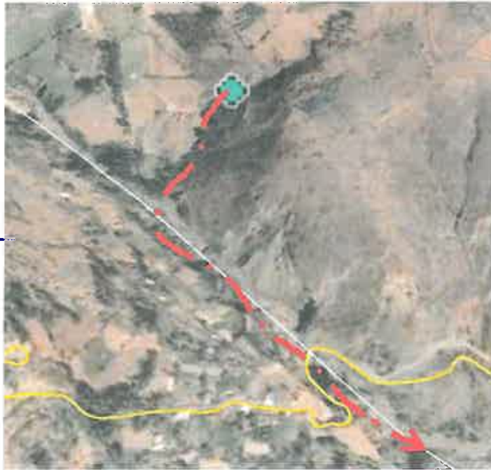
Ilustración 47: Deslizamiento rotacional en Chanahuas
