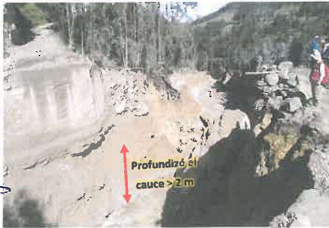
Ilustración 10: Río Lullán: Puente Gallupaccha – Totalmente Colapsado.
