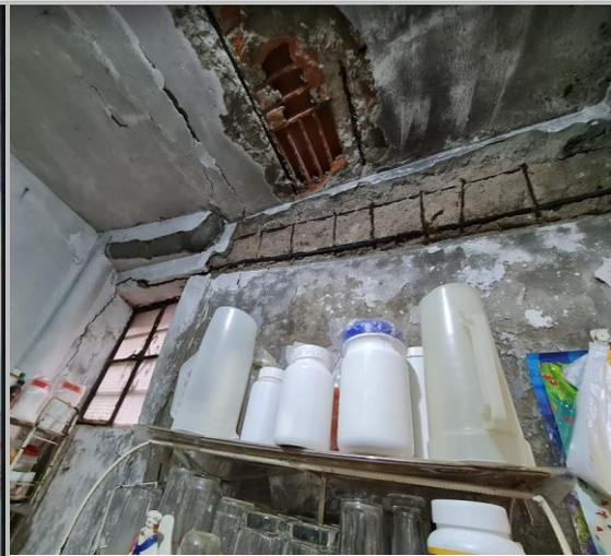
Foto 5.- Vista de losas aligeradas presenta desprendimiento del tarrajeo y rotura de ladrillos de techo por corrosión del acero de las viguetas y vigas.
