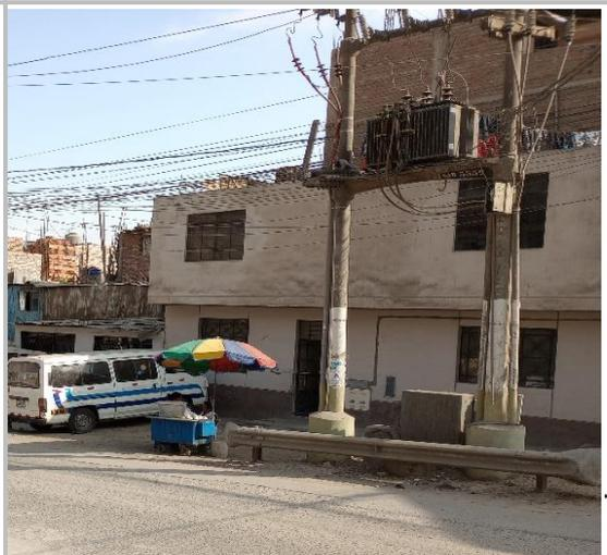
Foto 11.- Subestación eléctrica con deterioro en su base, sin mantenimiento, frente a la Mz 178 Lt 5
