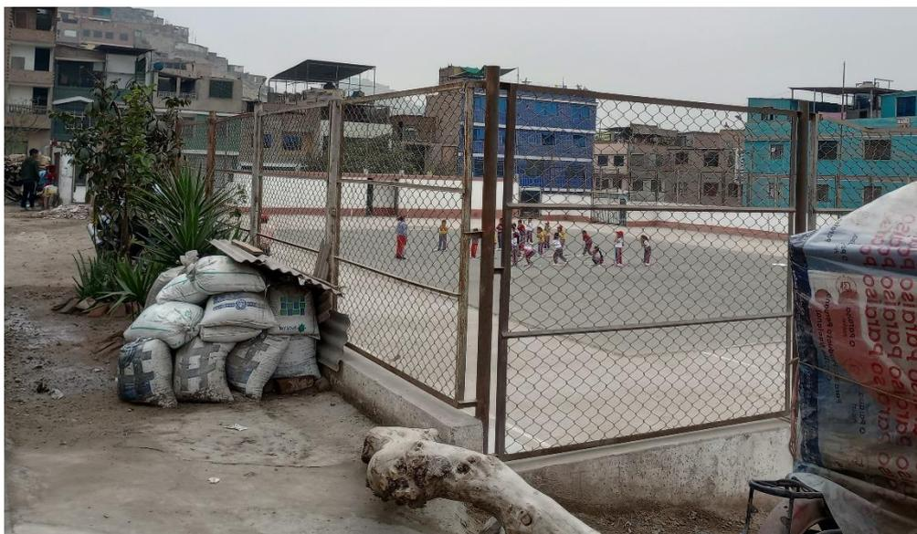
Losa deportiva con cerco metálico es estado de oxidación por falta de mantenimiento periódico
