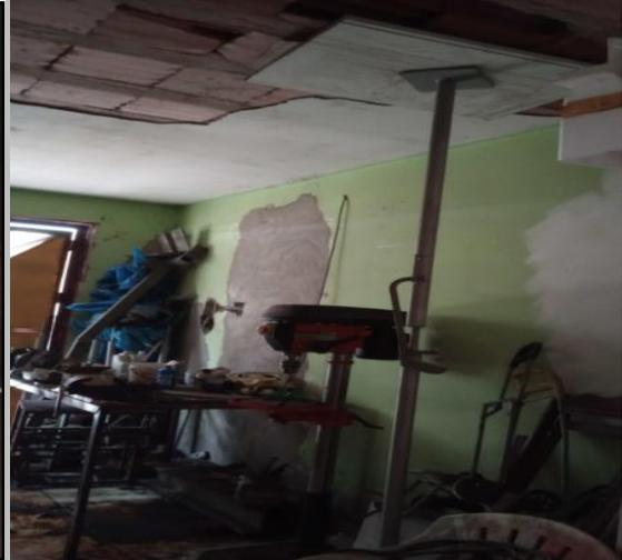
Foto 14 y 15.- Construcciones con deficiencias como corrosión del acero, deflexión de losa aligerada.
