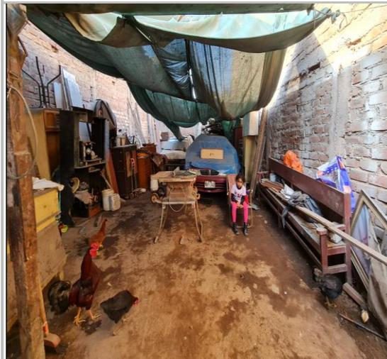
Foto 8 - Vivienda utilizada para taller de carpintería, presenta equipos eléctricos sin conexión a pozo a tierra, cables expuestos, no cuenta con tablero eléctrico.
