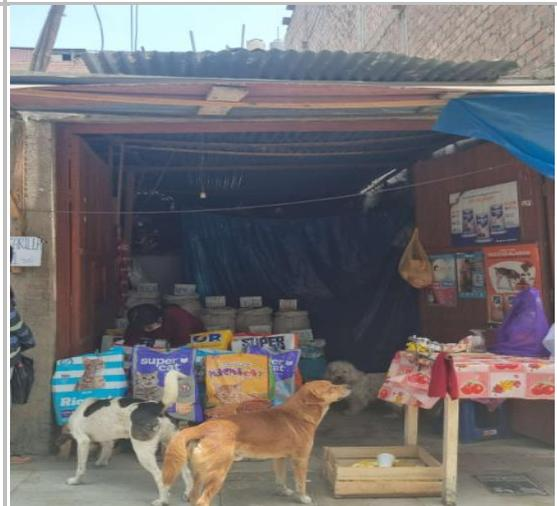
Foto 9.- Vivienda precaria utilizada como bodega, presenta cerramientos con material inflamable como plásticos, viguetas de madera del techo deflexionadas
