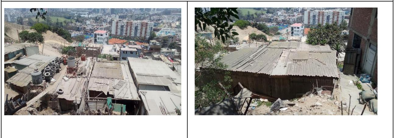
Foto N° 09 y N° 10: Vista de algunos techos de las viviendas, siendo en su mayor parte de calamina de polipropileno con presencia de polvillo común en la zona.
