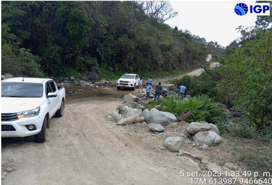
Figura 25.- Quebrada Naranjo o también llamada Masías que se activa y genera flujos que afecta a badén en la vía de acceso
