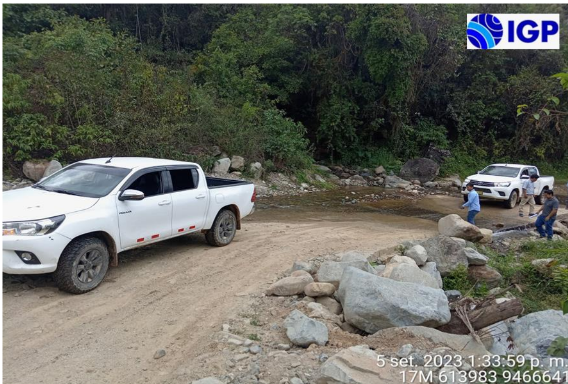
Figura 4.- Cauce aluvial de la quebrada Naranjo donde se ha implementado un badén para vía de accesibilidad
