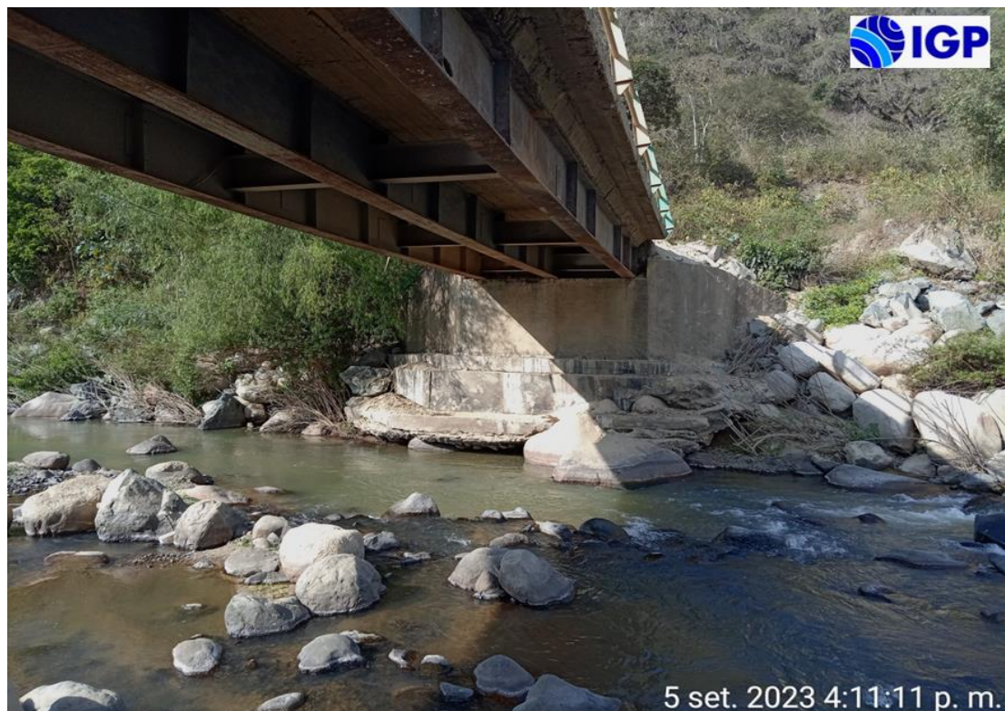
Figura 20.- Bloques de roca transportados por el cauce del río Timbes
