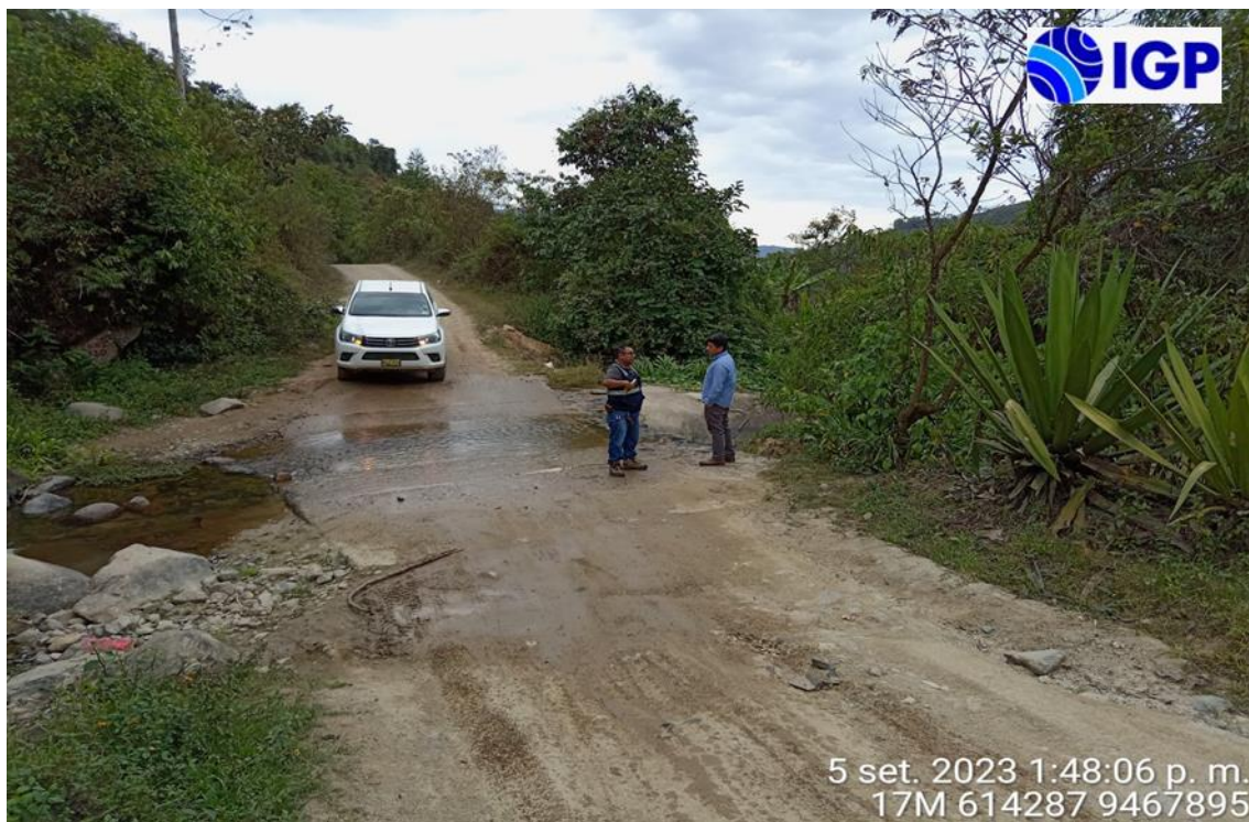
Figura 26.- Quebrada Naranjo o también llamada Masías que se activa y genera flujos e inundaciones que afecta badén de acceso
