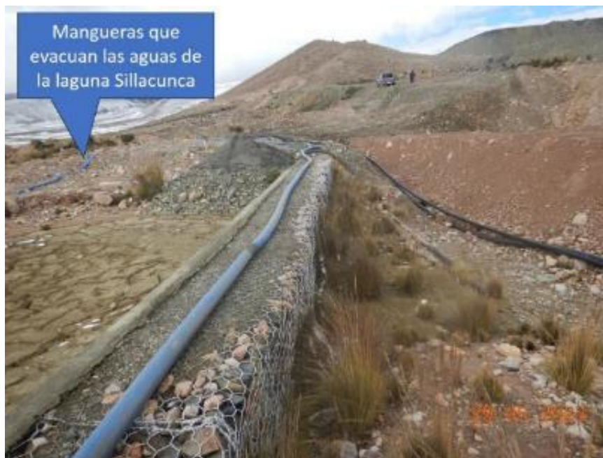
Figura 9. Vista tomada el día de la inspección, se aprecia la laguna Sillacunca con sus aliviaderas obstruidos por los depósitos de materiales de relaves y mangueras por dónde sacan las aguas para sus trabajos.
