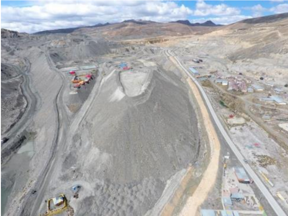
Fotografía 2. Depósitos de relaves mineros generando taludes de hasta 40 m de altura.
