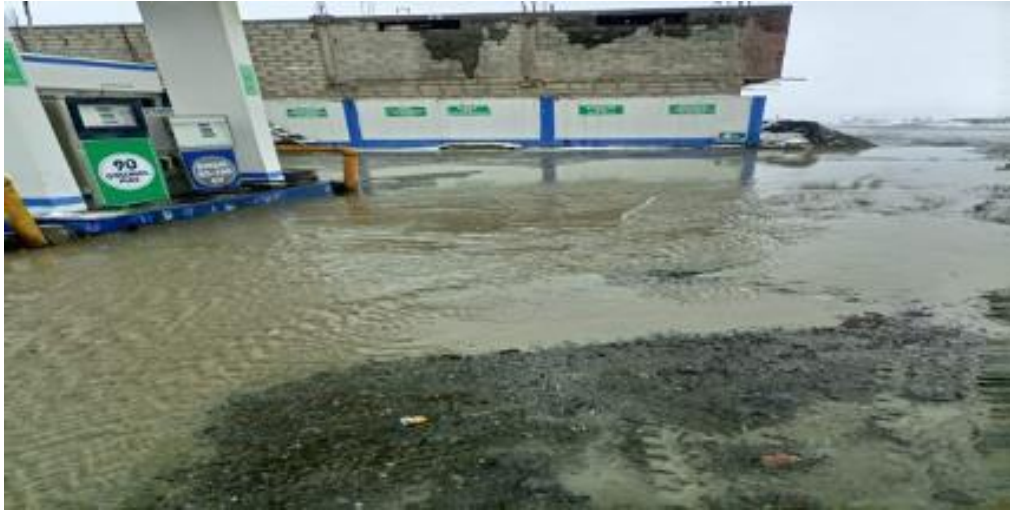
Figura 10. Se aprecia las afectaciones que dejó en un grifo afectado por el flujo que llegó al centro poblado de Ananea (foto tomada del informe técnico N°019-2021-GR PUNO-ORGRDS).
