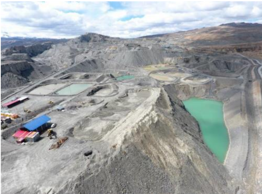
Fotografía 4. Vista hacia el este, se aprecian todos los rellenos artificiales que alcanza una altura de hasta 40 m.
