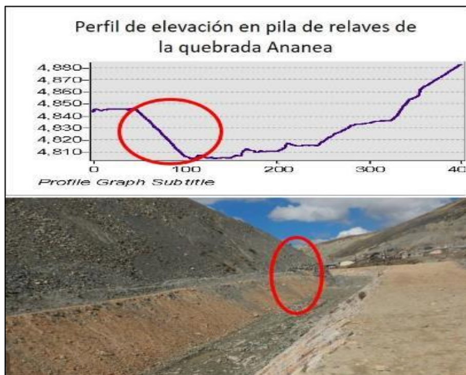
Figura 3. Aledaño al poblado se aprecia el talud, compuesto por rellenos de materiales de relaves depositados junto al canal de la quebrada Ananea, con una altura de 40 m.
