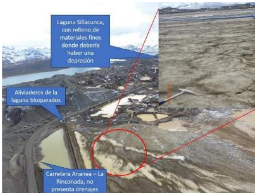
Figura 8. Vista tomada el día de la inspección, se aprecia la laguna Sillacunca con rellenos de materiales finos, además, se aprecian sus aliviaderos obstruidos y la falta de drenajes entre la vía y la quebrada.
