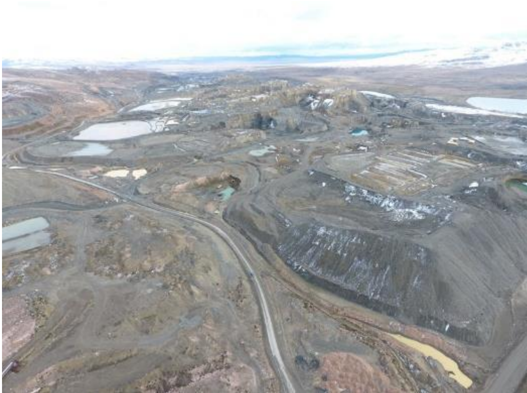
Fotografía 5. Se aprecia que toda el agua de la quebrada viene siendo transportada a las partes altas de sus relaves.
