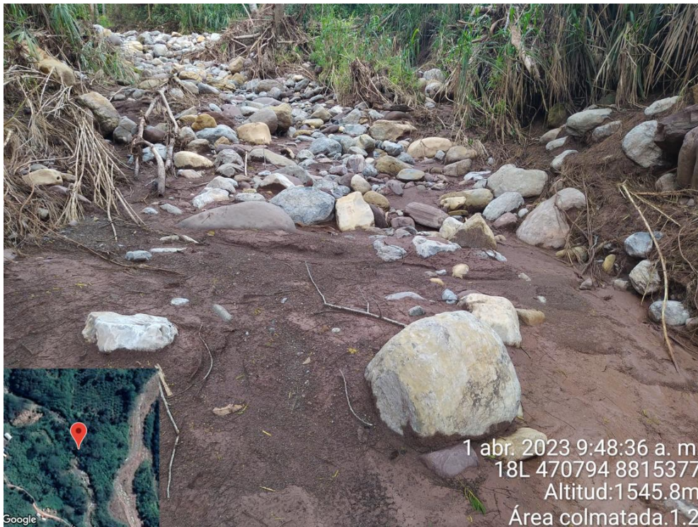
Fotografía 6. Colmatación del río en el Área 1.2, lado 1
