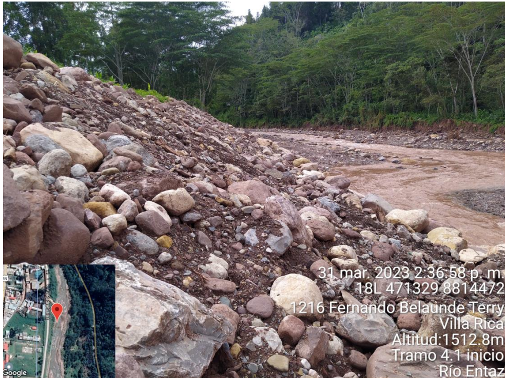
Fotografía 5. Colmatación del río en el Área 1.1, lado 1
