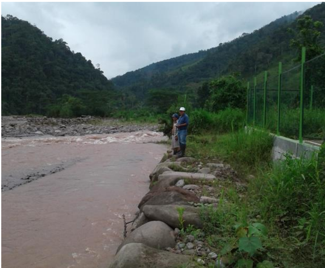
Fotografía 4. Crecida en el río Entaz Barrio Industrial – Villa Rica. Muestra el funcionamiento de enrocado.
