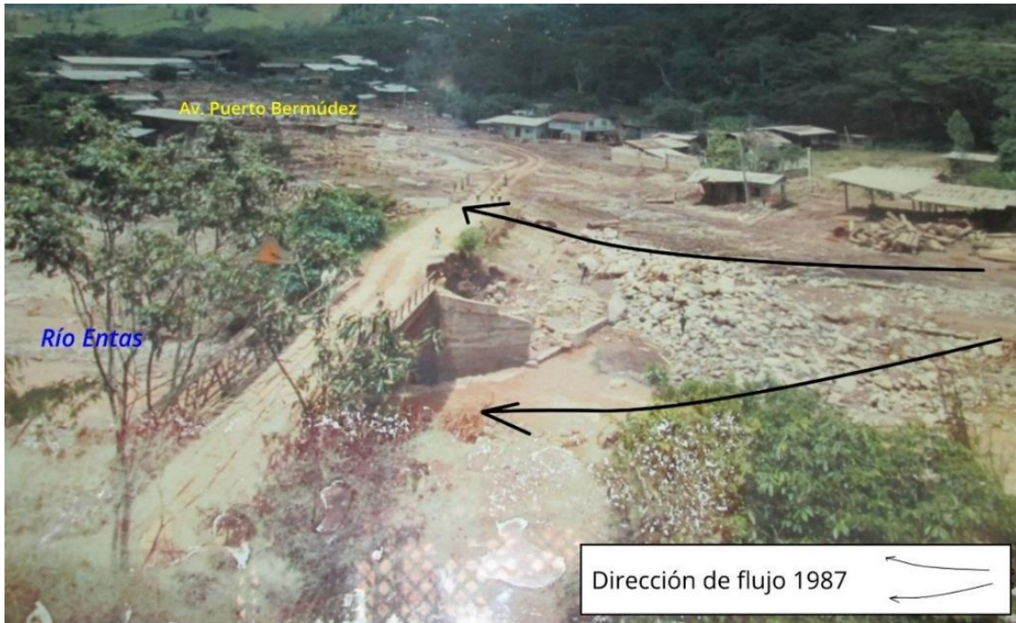
Figura 5. Zona urbana del Barrio Industrial destruida por el flujo de detritos de 1987. Fotografía INDECI - Villa Rica.
