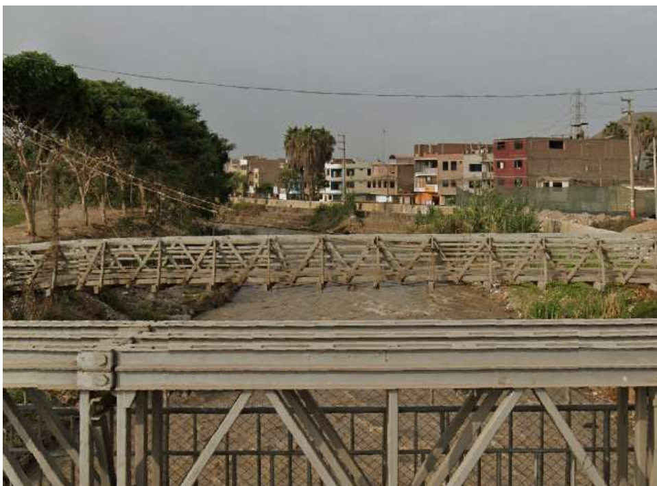
Imagen 3. Botadero informal de residuos sólidos cerca de la ribera del Río Chillón, altura de Puente Ensenada, distrito Los Olivos.
