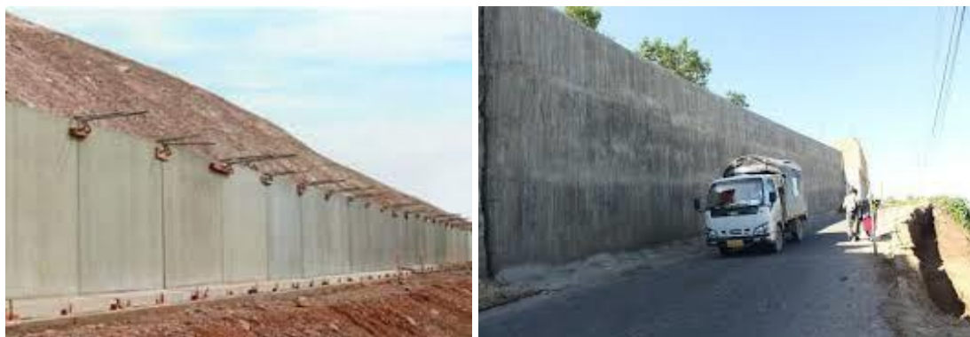
Figura 21. Ejemplo de muros de contención para los derrumbes y sujeción de la avalancha de detritos.
