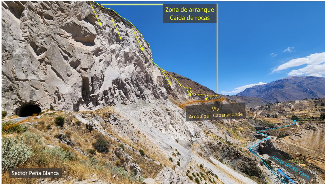
Figura 14. Se observa la zona de caída de rocas en el sector Peña Blanca. Margen izquierda del río Colca.
