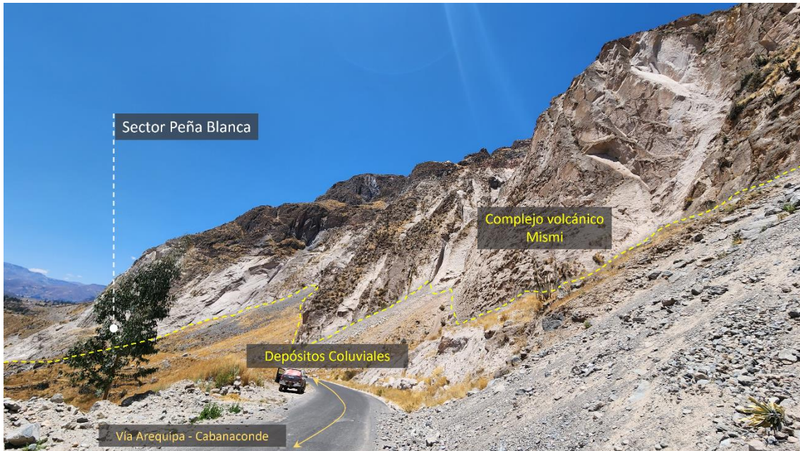
Figura 8. Depósitos coluviales en el sector Peña Blanca originados por avalancha de detritos, caída de rocas y derrumbes.
