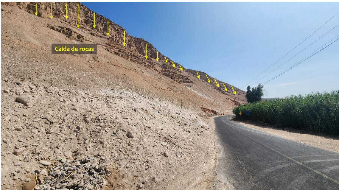
**Figura 15.** Se observa la zona de arranque de caída de rocas.
