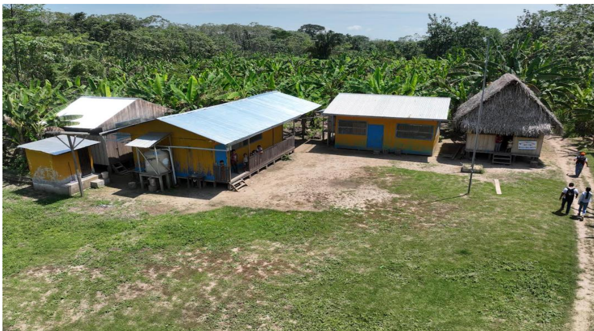
Foto N° 03: Viviendas del Caserío San Pedro de Bello Horizonte
