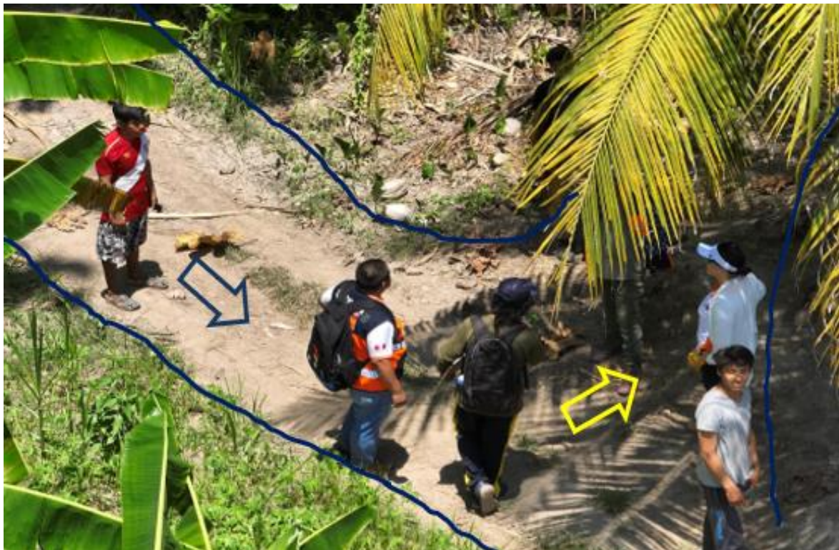
Foto N° 06: Parte de socavación por donde pasa el flujo de agua del Caserío San Pedro de Bello Horizonte
