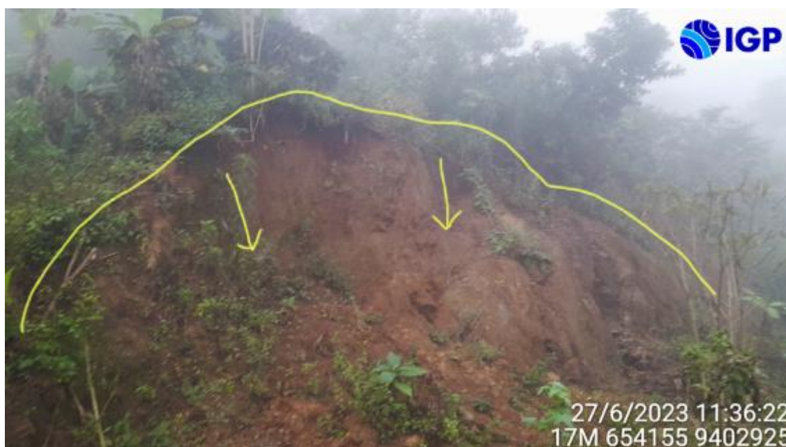
Figura 13.- Deslizamiento de tierras identificado en la parte baja del grifo Hermanos Peña, debido a la infiltración del agua en los suelos y rocas de la ladera
