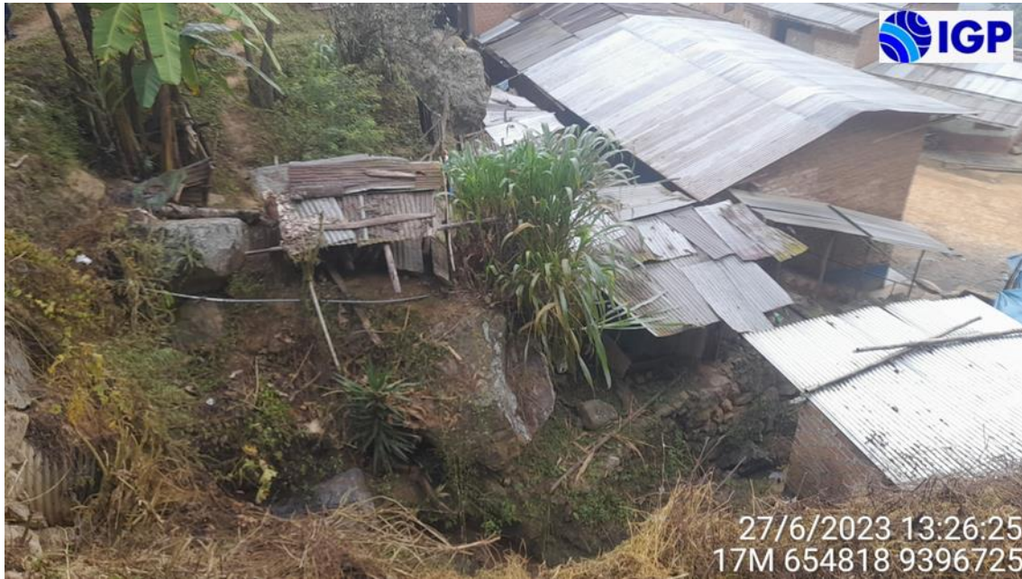
Figura 22.- Cauce de la quebrada Limón ubicada en las inmediaciones del poblado La Capilla que podría activarse y generar flujos de detritos
