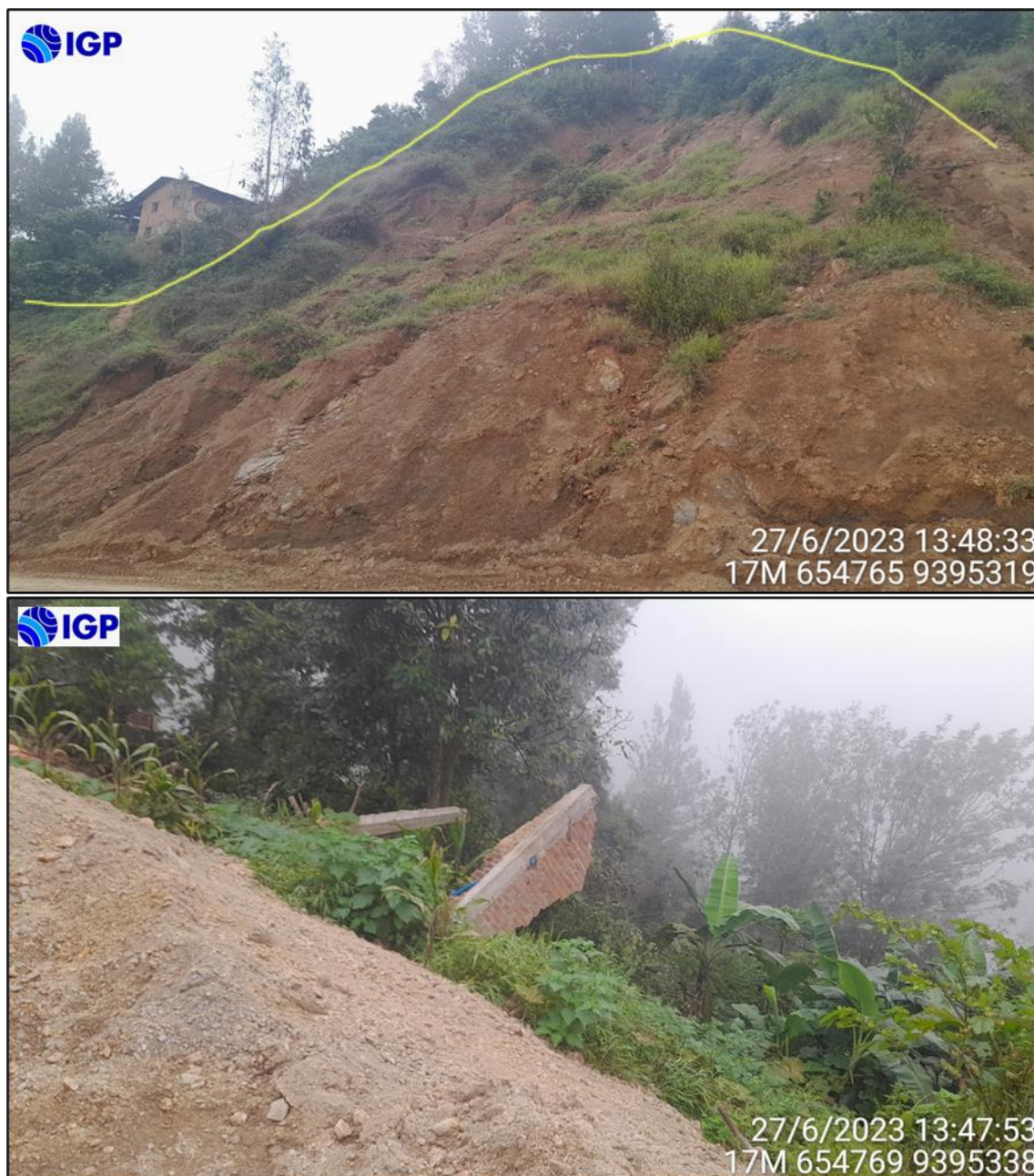
Figura 20.- Deslizamiento en el sector Chamelico que presenta un área de influencia de 2.8 Has y se ubica contigua a vía de acceso, durante marzo del año 2023 se activó, generando el colapso de 4 viviendas situadas en el pie de la ladera y el fallecimiento de dos personas
