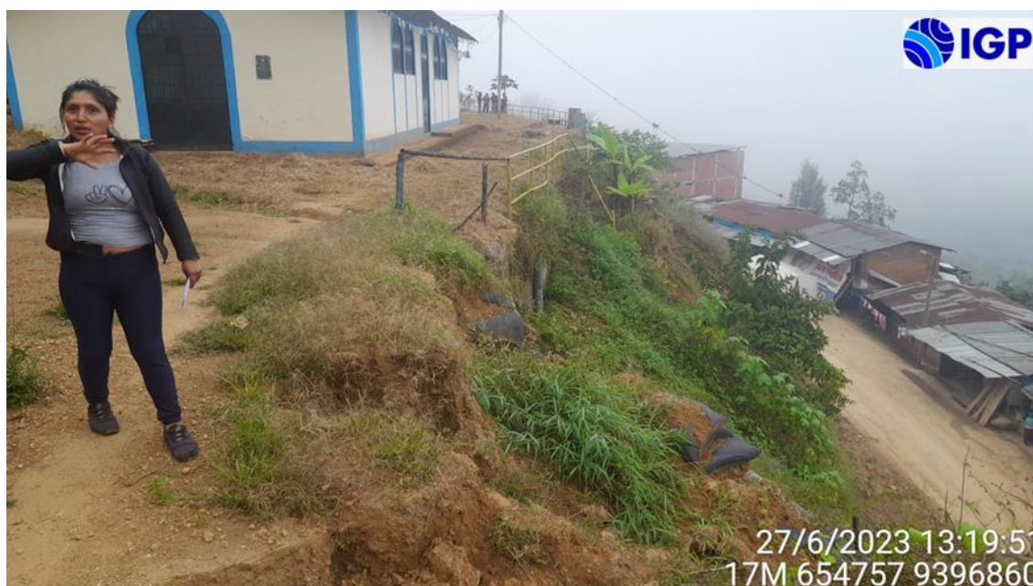
Figura 21.- Derrumbes generados en las inmediaciones del sector La Capilla que han ocasionado el colapso parcial de las barandas dispuestas frente a la iglesia del poblado
