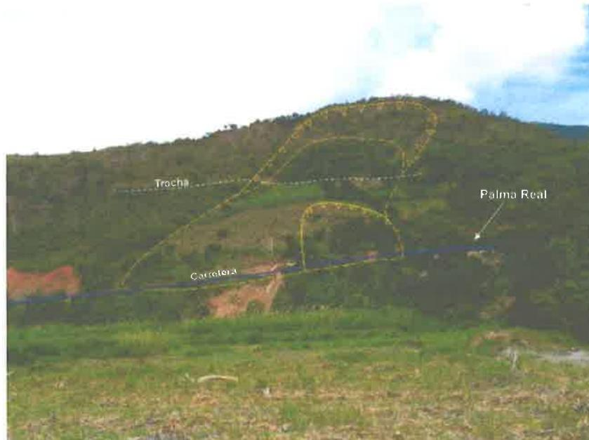
Descripción: donde se señala con líneas entrecortadas amarillas los límites del deslizamiento antiguo, y línea amarilla continua el deslizamiento reactivado en el cuerpo.
