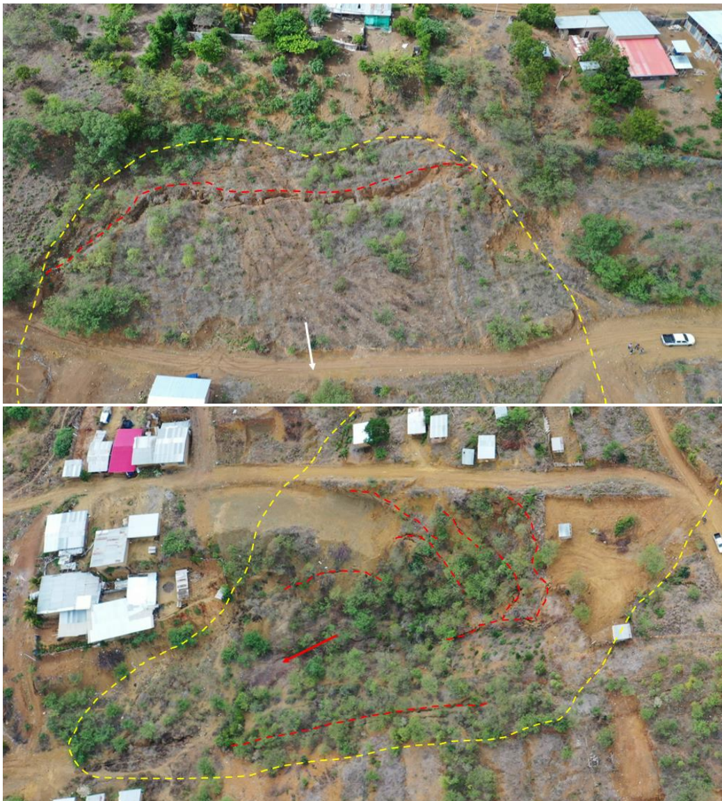
Figura 9. Vista de la parte alta (arriba) y baja (abajo) del deslizamiento de San Luis Alto, el cuerpo del deslizamiento está delimitada en línea amarilla y los agrietamientos secundarios en línea roja.
