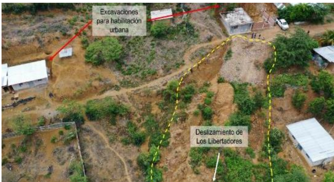
Figura 12. Vista del cuerpo del deslizamiento Los Libertadores (delimitado en línea amarilla), donde se muestran cortes para habilitación urbana y viviendas cercanas en peligro.
