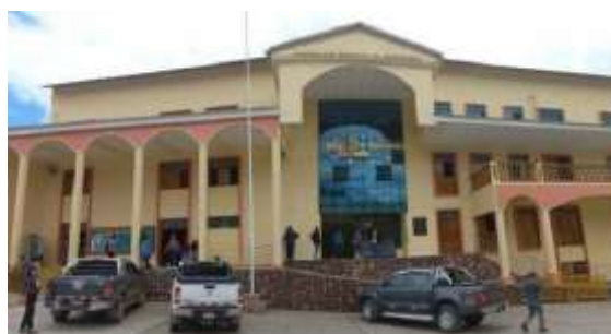
Foto N.º 04. En la fotografía se muestra la Municipalidad de la Provincia de Huancabamba.
