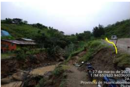
En la margen izquierda de la quebrada Pusmalca, la erosión generada por el flujo podría afectar la vía principal hacia Canchaque – Huancabamba
