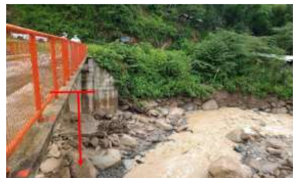
En las inmediaciones del sector Huabal la altura del flujo disminuye hasta 1.20 m. con respecto al cauce de la quebrada
