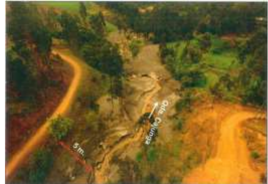
Vista del curso medio de la quebrada Cajunga. Obsérvese que en este sector la quebrada ha alcanzado alturas de hasta 5 metros y es visible la zona inundada.
