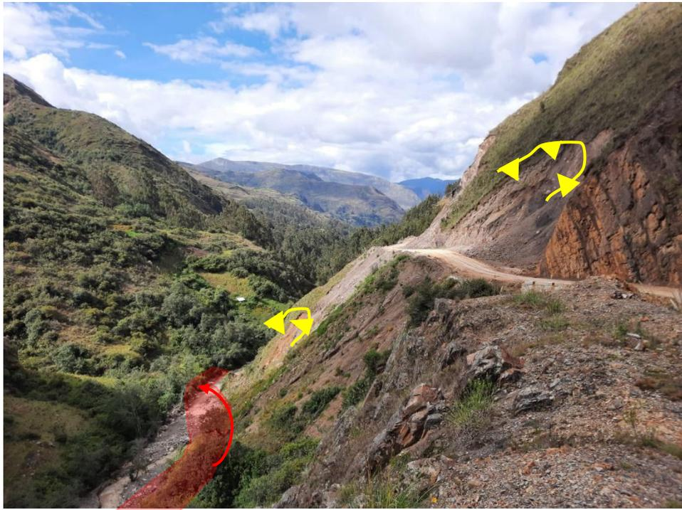
**Imagen N° 13.** Deslizamiento sobre la vía vecinal y socavación del río al margen derecho de la quebrada Chogo.
