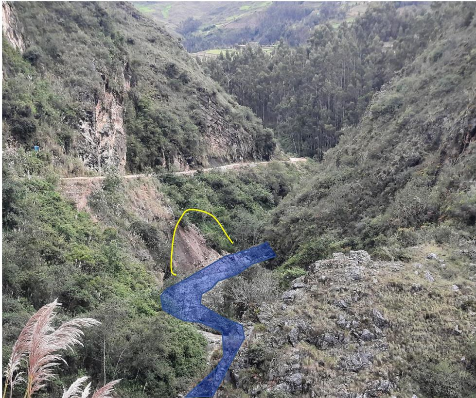
**Imagen N° 10.** Socavación en el margen derecho de la Quebrada Chogo
