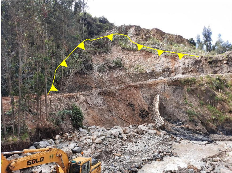
**Imagen N° 9.** *Socavación hídrica producto de las crecidas del río.*
