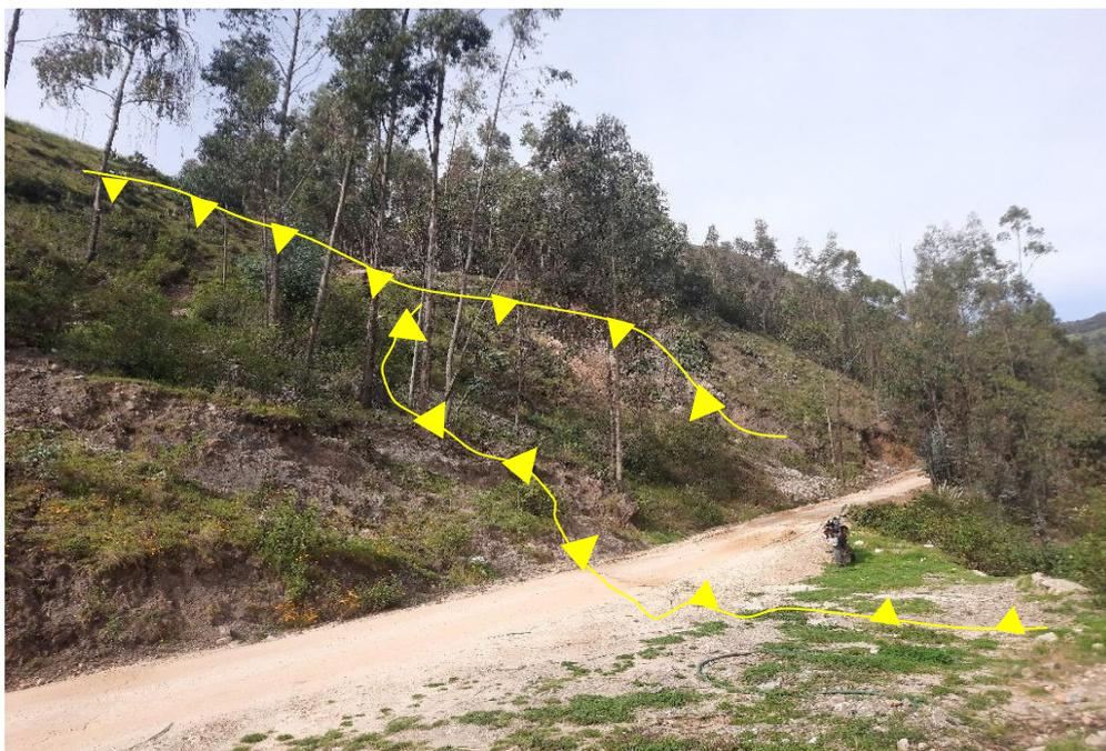
**Imagen N° 6.** Escarpes de deslizamiento muestran el proceso de reactivación del deslizamiento.
