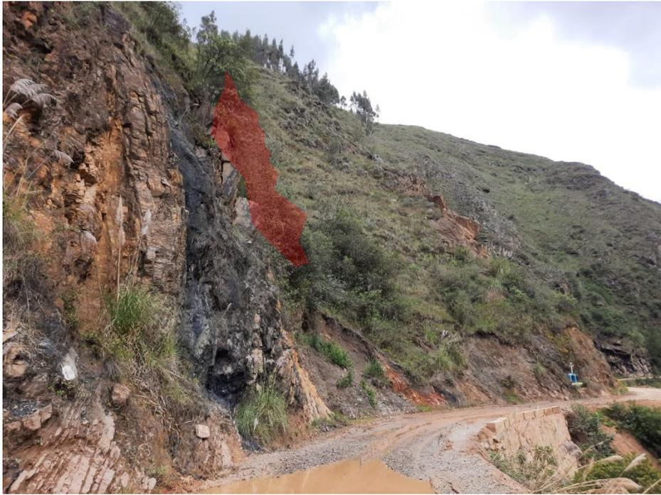
**Imagen N° 11.** *Susceptibilidad alta de Caída de rocas en el margen derecho de la Quebrada Chogo*
