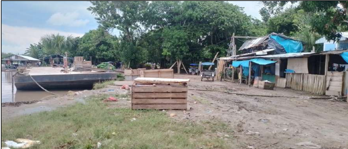
Foto 2. Sector Muelle Alto Bretaña erosionado, barcaza de protección
