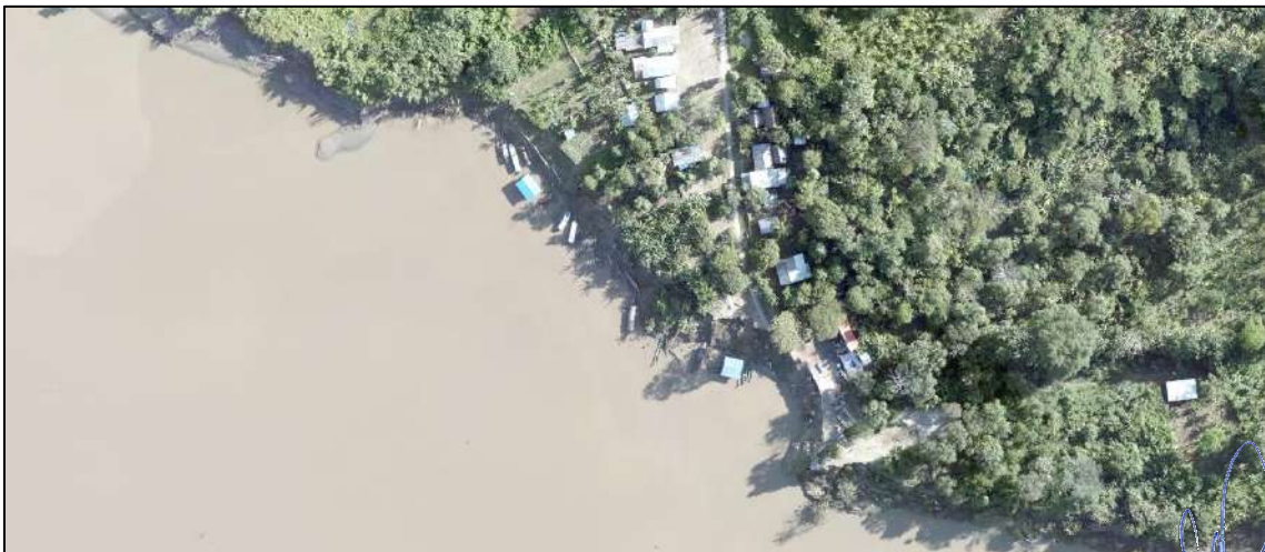
Foto 10. Sector Muelle Alto Bretaña erosionado – Vista Lidar
