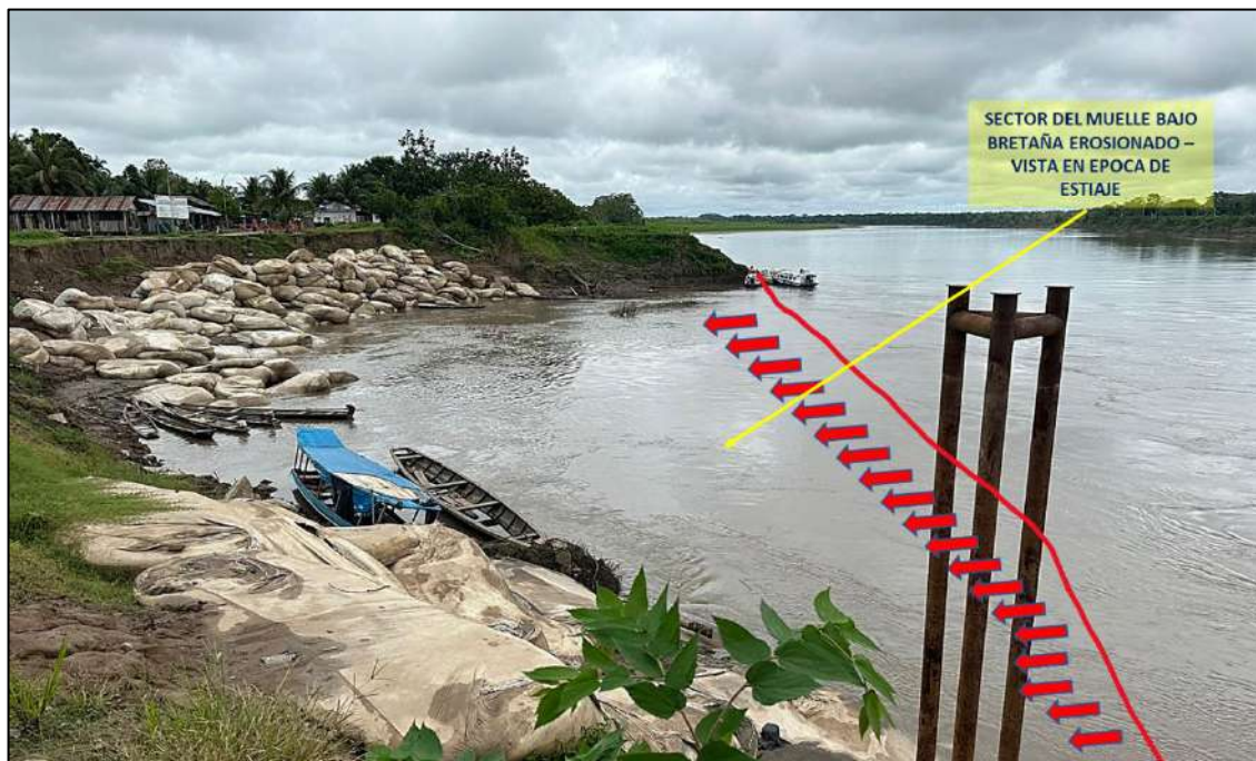
Foto 1. Sector Muelle Bajo Bretaña erosionado
