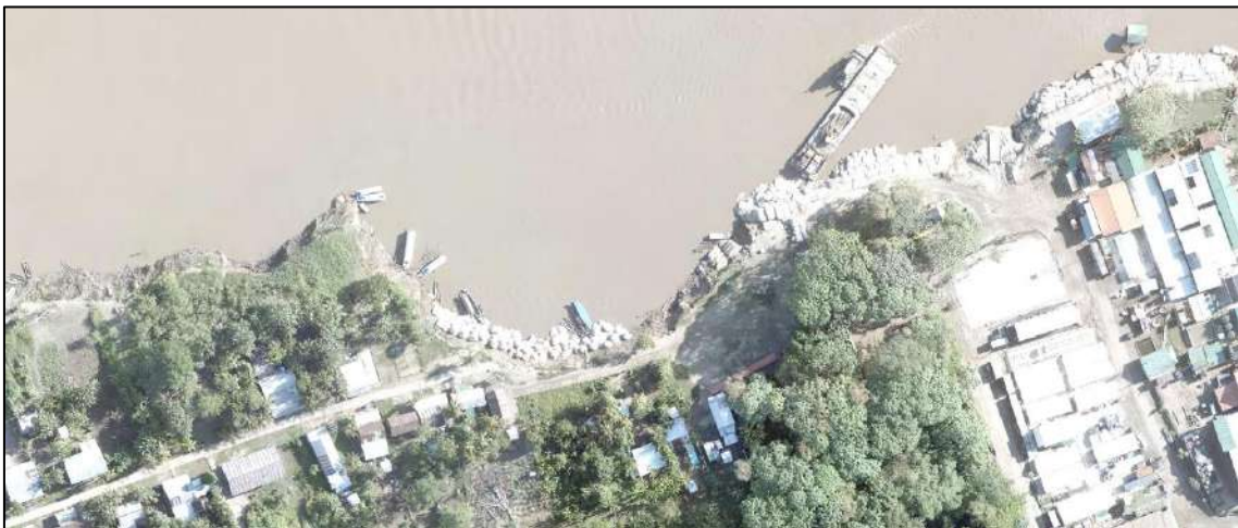
Foto 9. Sector Muelle Bajo Bretaña erosionado – Vista vuelo Lidar
