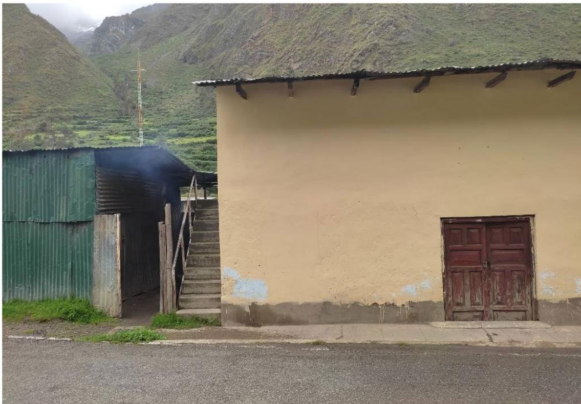
**Fotografía 5.** Comedor del centro poblado Racrachaca. Se observa una construcción de paredes de tapia y techo de calamina. Su estado conservación es malo y presenta pérdida y desprendimiento del yeso por la humedad capilar.
