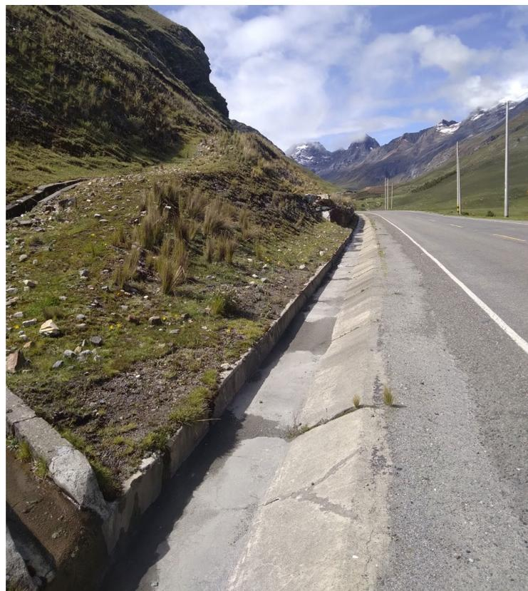
**Foto 7.** Cuneta de concreto al costado de la vía asfaltada –repartición La Oroya (PE-22)-Huánuco (carretera a Huánuco) del centro poblado menor de Pachapaqui.
