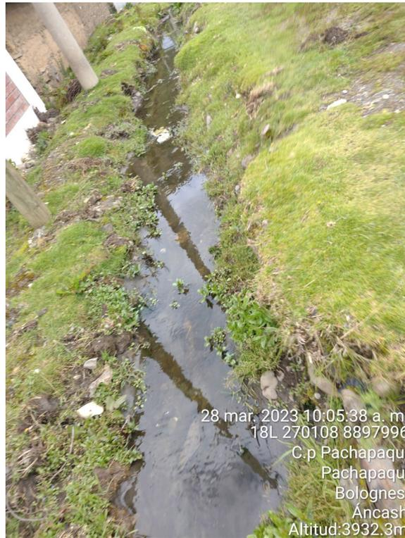
**Foto 6.** Canal que cruza por la zona posterior de la I.E. N° 86220 Sagrado Corazón de Jesús-Nivel Secundaria es una, zanja de tierra que no cuenta con algún tipo de revestimiento.
