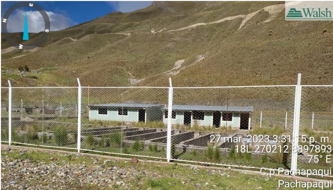
Foto 3. Módulo de piscicultura, estructura de tapial con techo de calamina, actualmente se encuentra en desuso.
