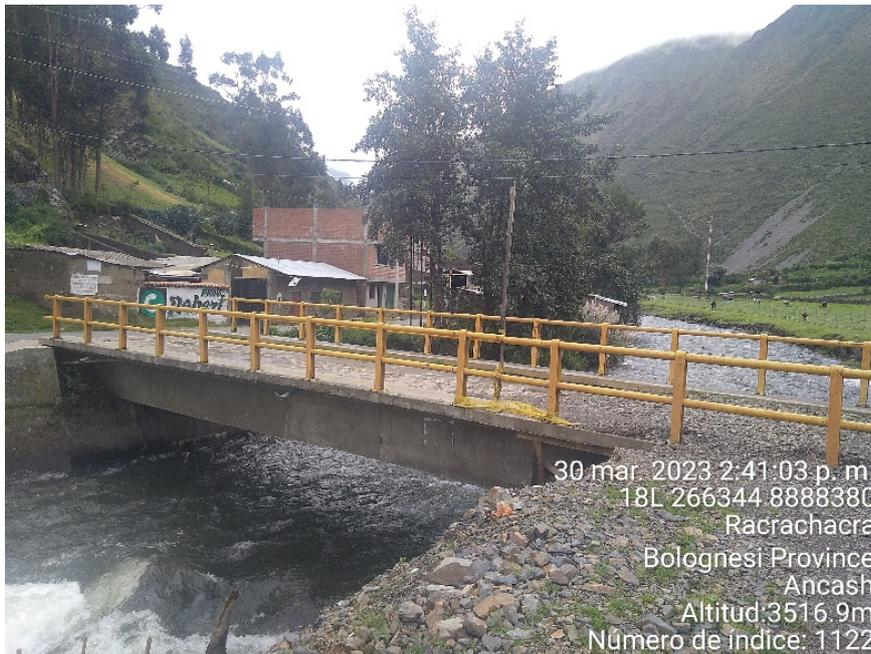
**Foto 28.** Puente 2. La estructura se califica en estado de conservación regular. Presenta deterioro en la base de la estructura debido a la erosión fluvial del río Pativilca. Las barandas metálicas del puente se están oxidando. Coordenadas E 266525, N 8888916.
