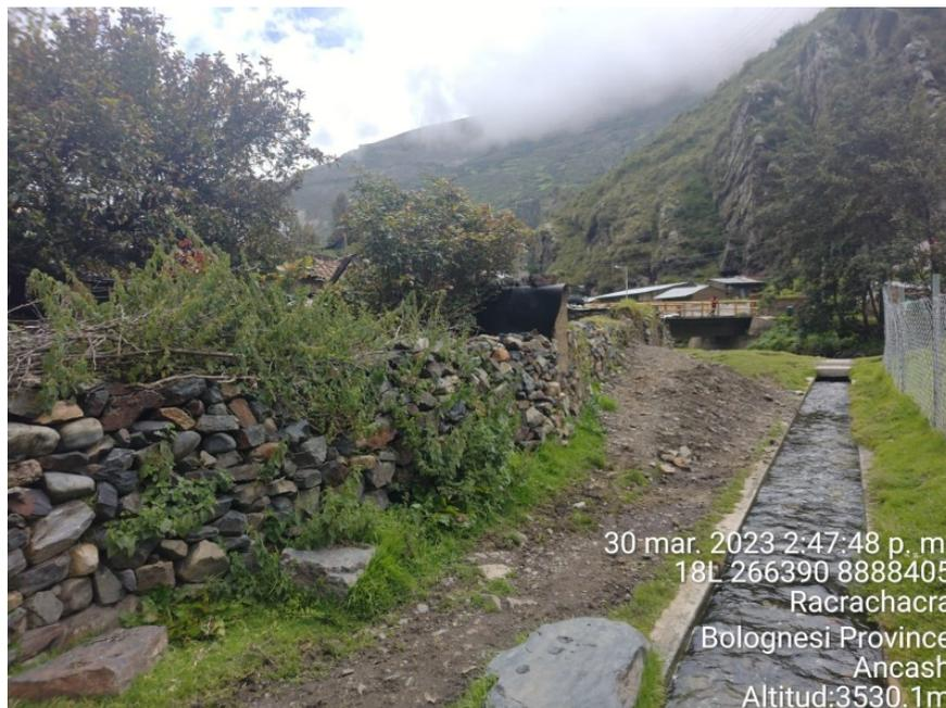
**Foto 22.** El canal de riego es una construcción reciente en buen estado conservación, material predominante concreto. Coordenadas: E 266362, N 8888402.
