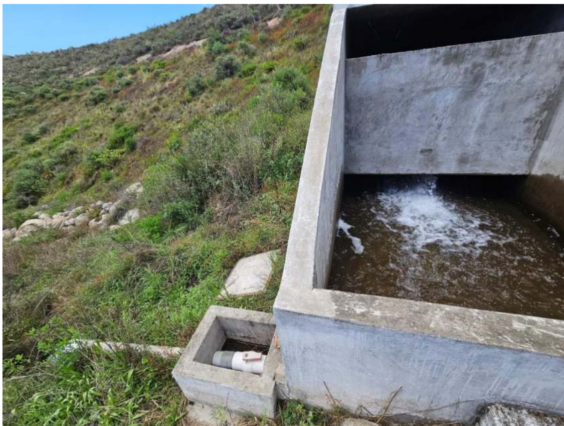
Figura N° 18: Salida a la quebrada de la tubería de descarga de la presa Ullancay.
