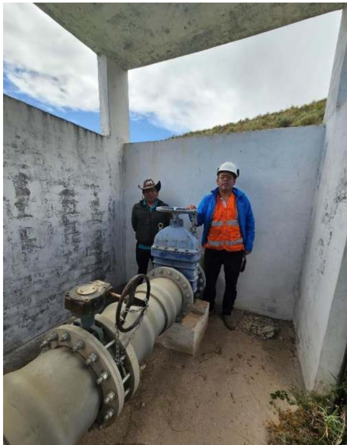
Figura N° 12: Dos válvulas de descarga de la presa Ullancay.
