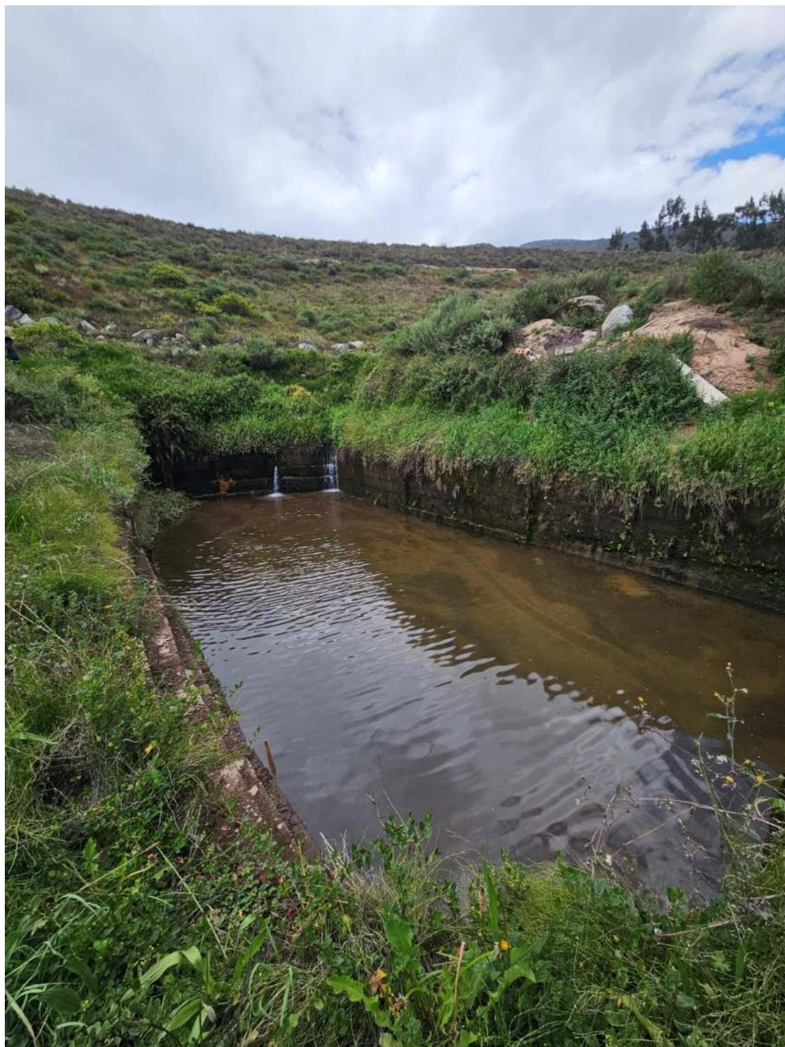
Figura N° 21: Paramento aguas abajo y reservorio de la presa Ullancay.
