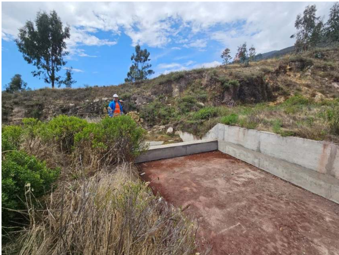
Figura N° 10: Aliviadero sin amarre a un estribo rocoso, presa Ullancay.
