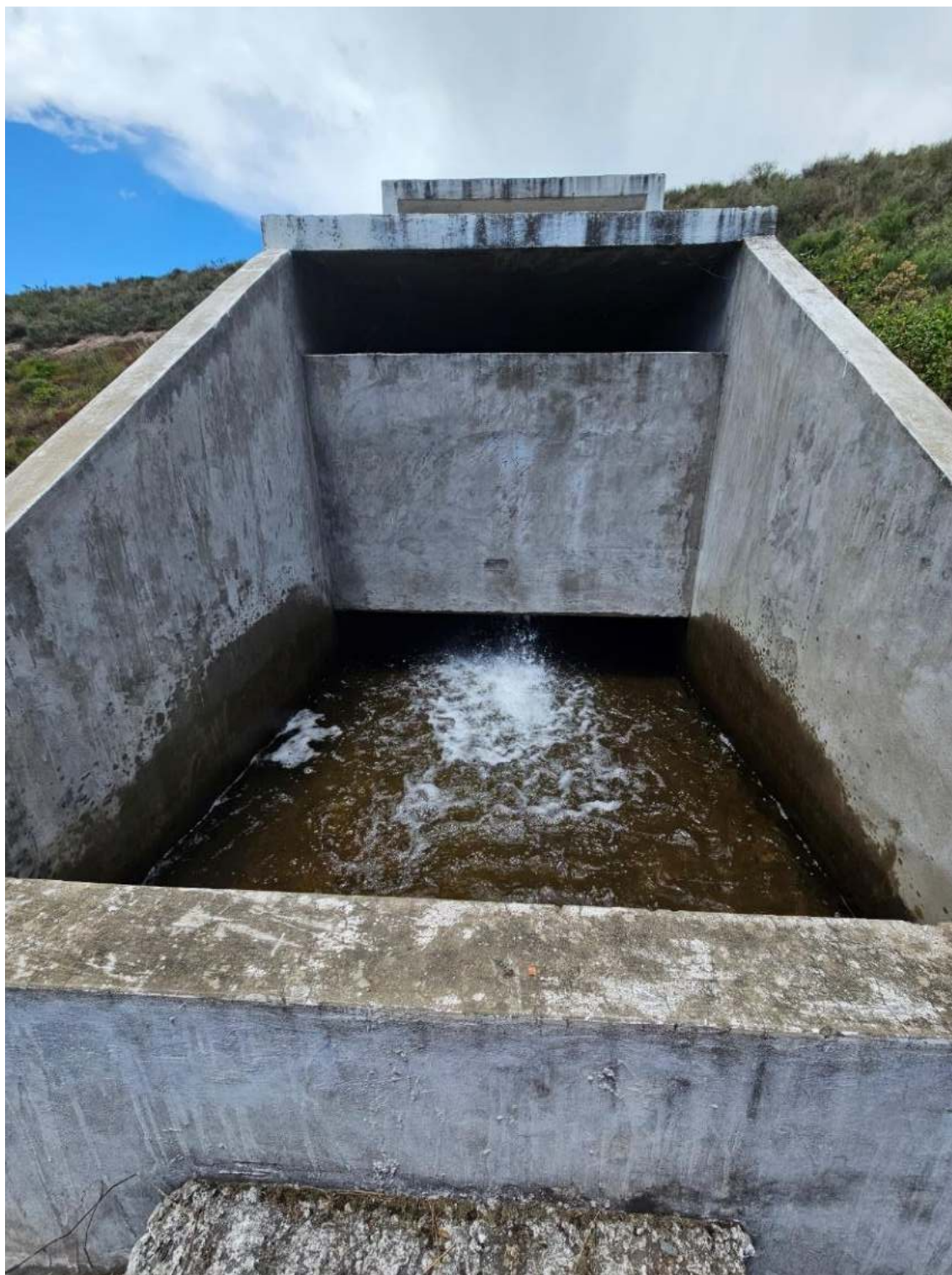
Figura N° 16: Salida de la descarga de la presa Ullancay.
