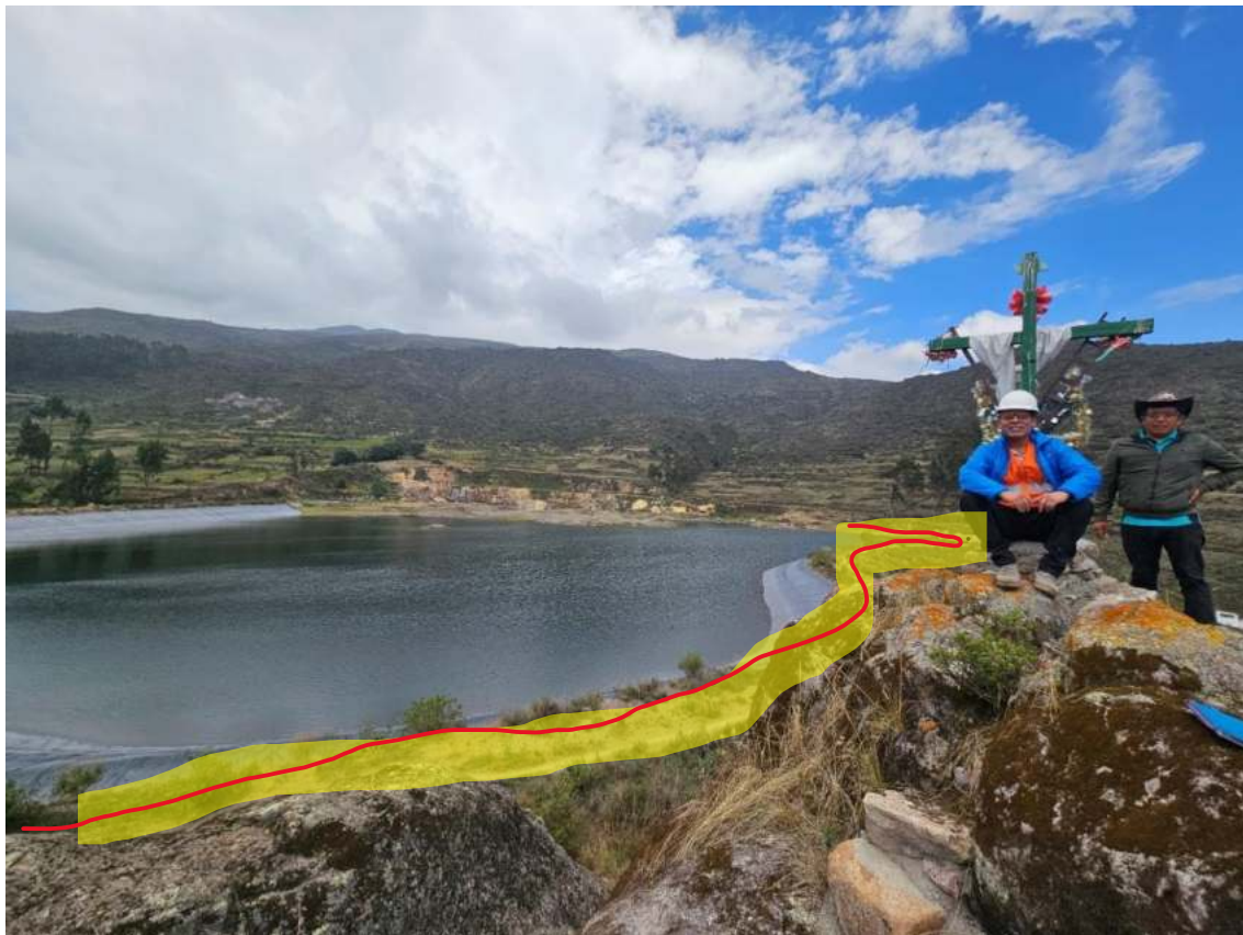
Figura N° 4: Corona con vegetación de la presa Ullancay.
