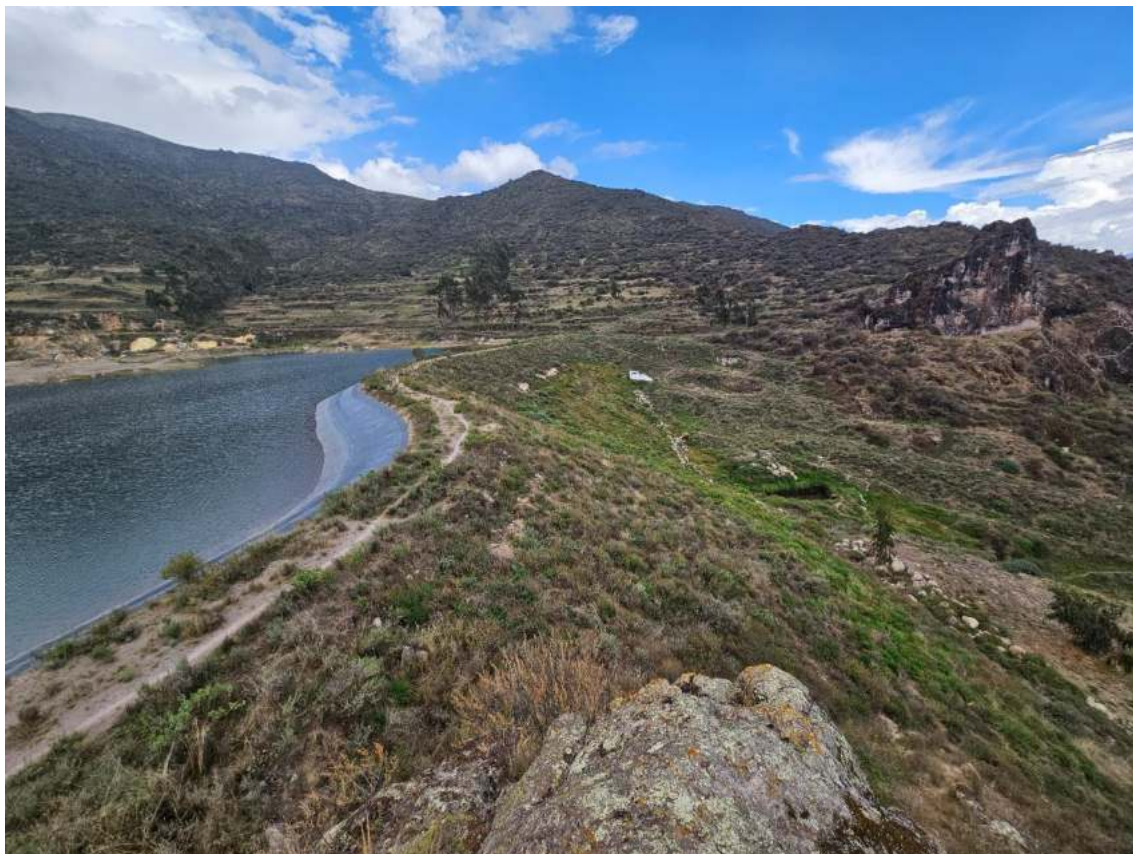
Figura N° 4: Corona con vegetación de la presa Ullancay.
