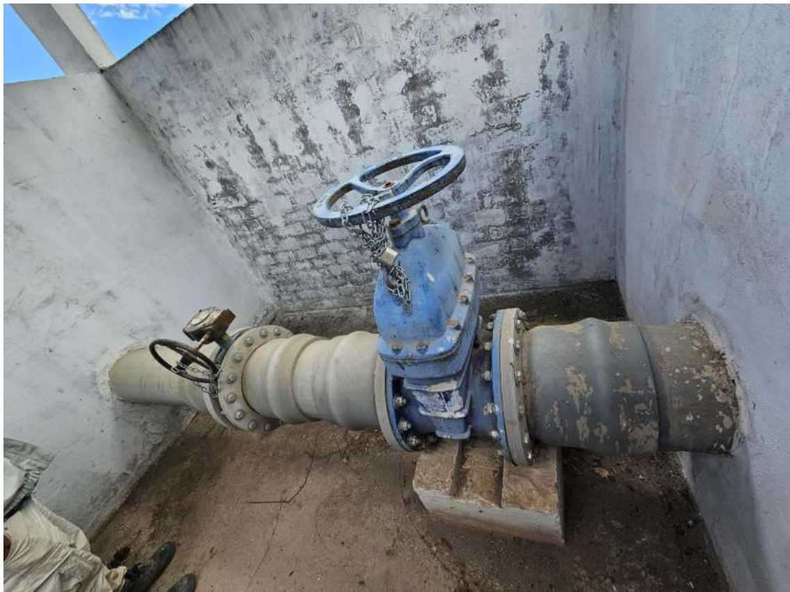
Figura N° 20: Dos válvulas de descarga de la presa Ullancay.
