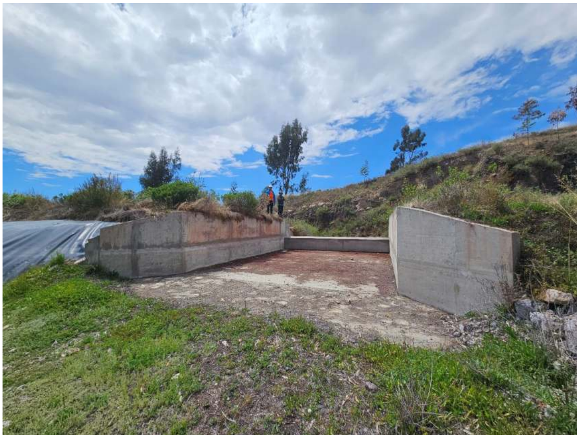
Figura N° 10: Aliviadero sin amarre a un estribo rocoso, presa Ullancay.
