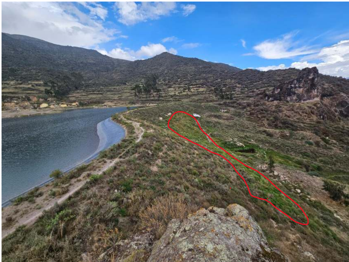
Figura N° 8: Presencia de vegetación producto de filtraciones de la presa Ullancay.
