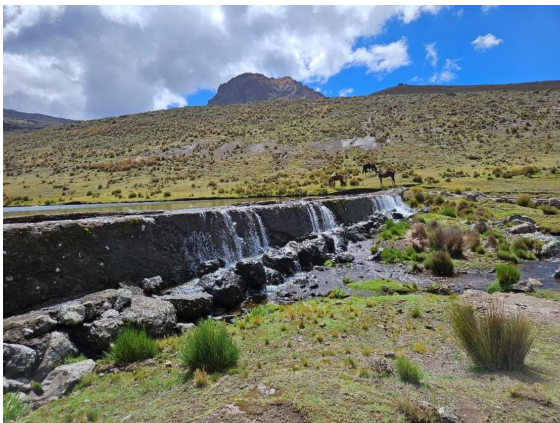
Figura N° 26: Sobrevertimiento de la presa Yanacocha.
