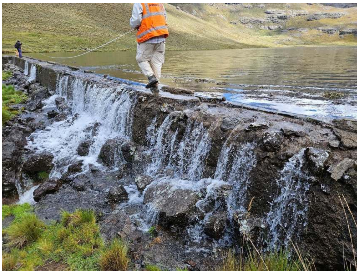
Figura N° 10: Aliviadero de demasías de la presa Yanacochoa.
