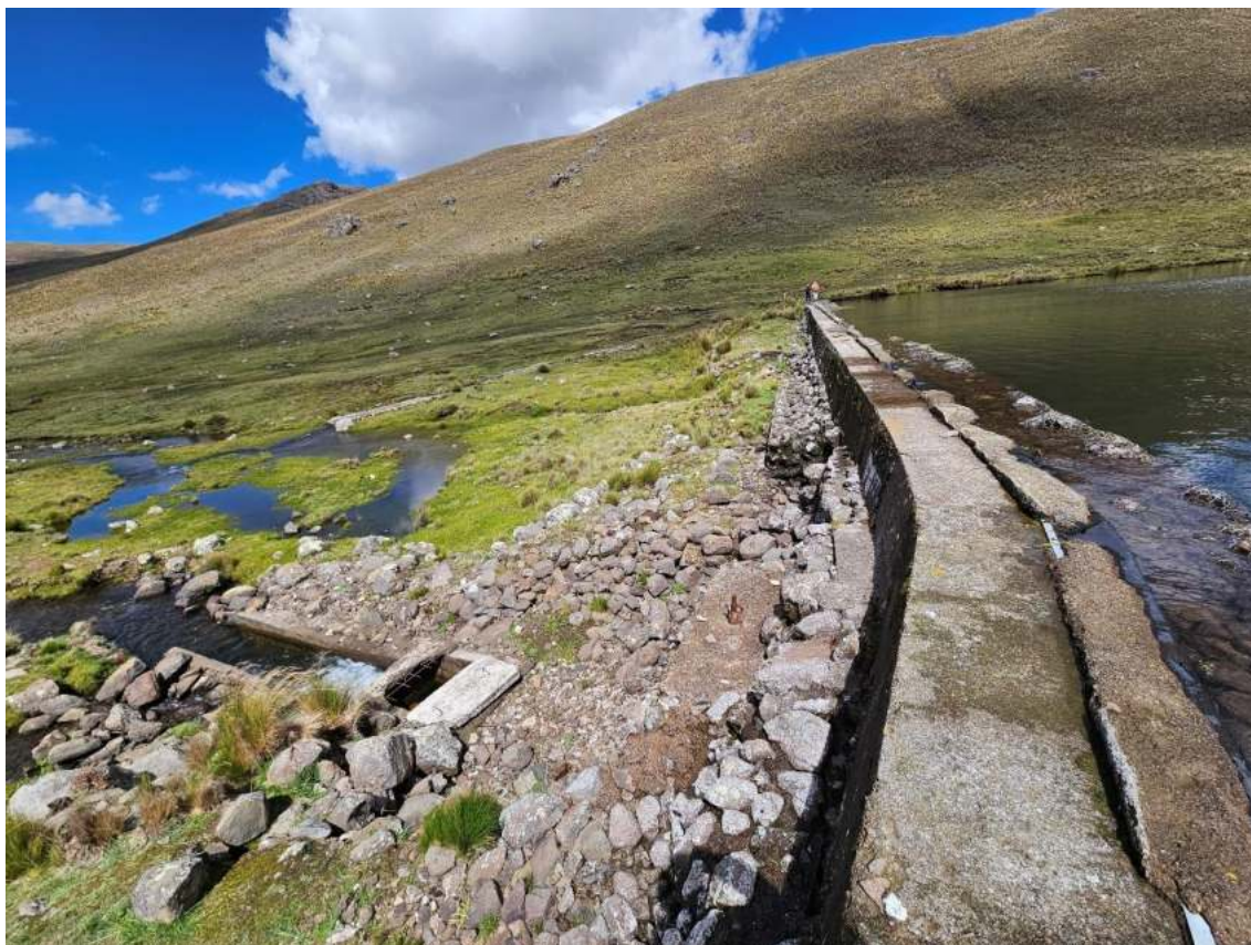
Figura N° 8: Paramento aguas abajo de la presa Yanacocha.
