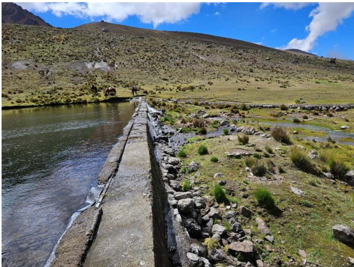
Figura N° 6: Vista del sobrevertido de la corona de la presa Yanacocha.
