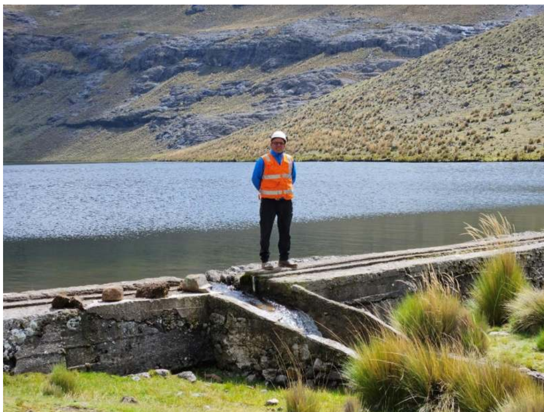
Figura N° 17: Vaso de la presa Yanacocha.
