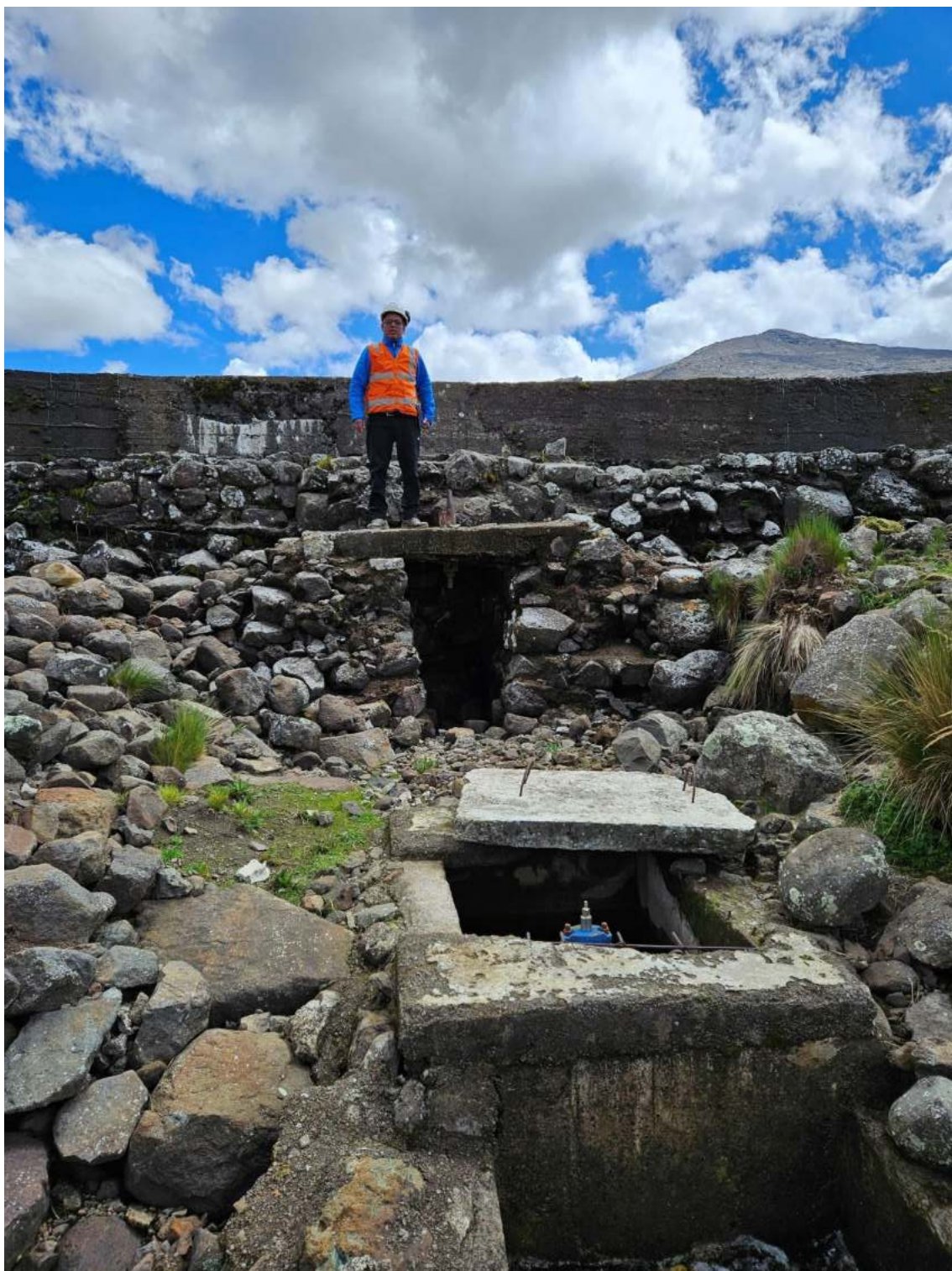
Figura N° 11: Cámara de descarga de la presa Yanacocha.
