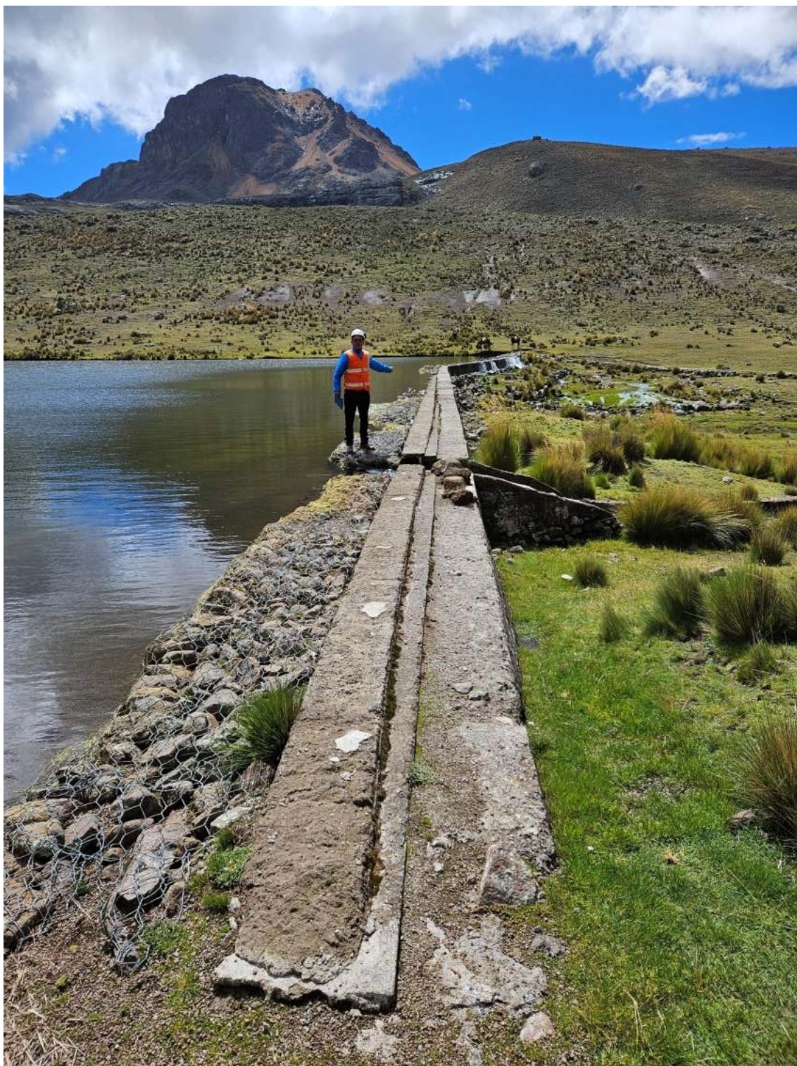
Figura N° 4: Vista general de la corona de la presa Yanacocha.
