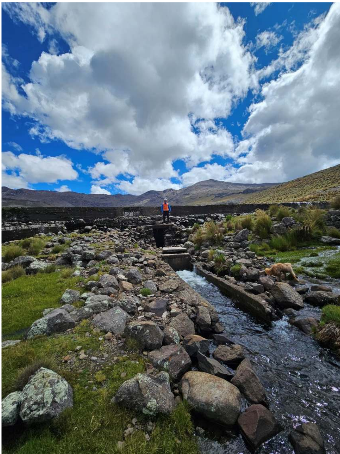
Figura N° 12: Cámara de descarga de la presa Yanacocha.
