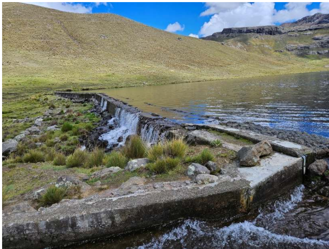
Figura N° 6: Vista del sobrevertido de la corona de la presa Yanacocha.
