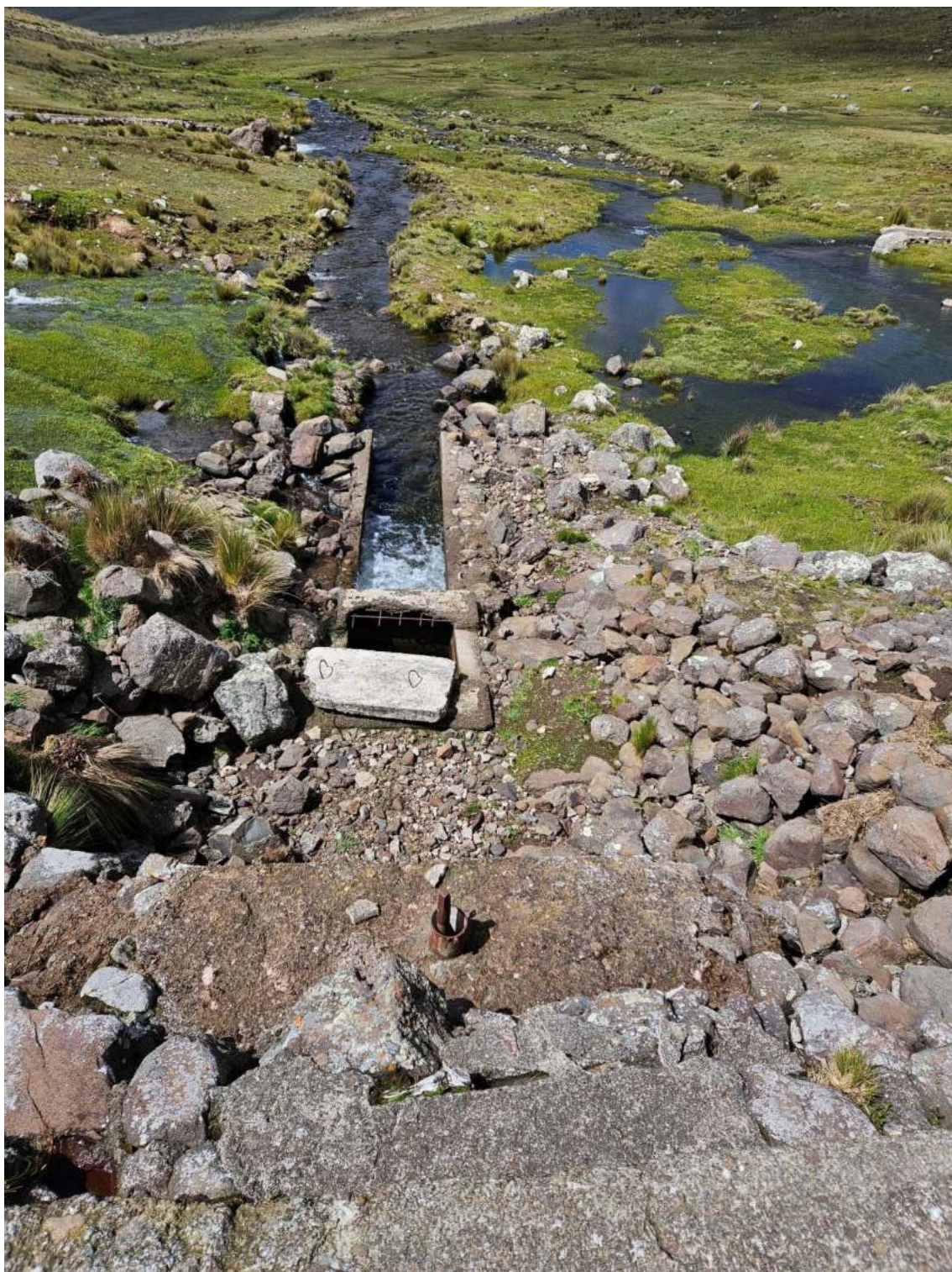
Figura N° 13: Cámara de descarga de la presa Yanacocha.
