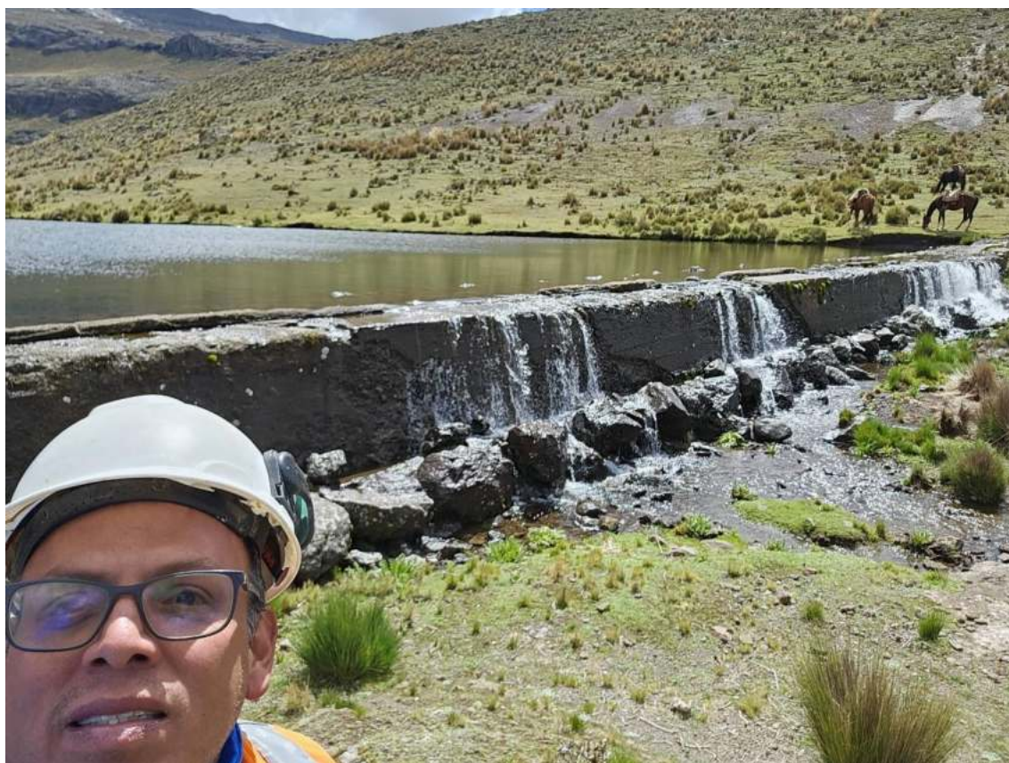
Figura N° 26: Sobrevertimiento de la presa Yanacocha.
