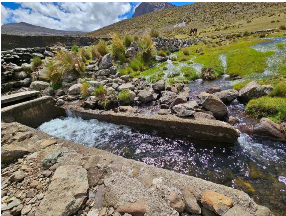
Figura N° 28: Cámara de descarga y canal de descarga de la presa Yanacocha.
