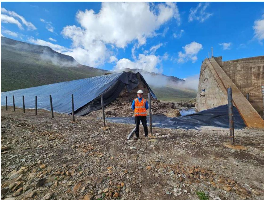
Figura N° 13: Rotura del cuerpo de la presa Yarcán desde la base hasta la corona.
