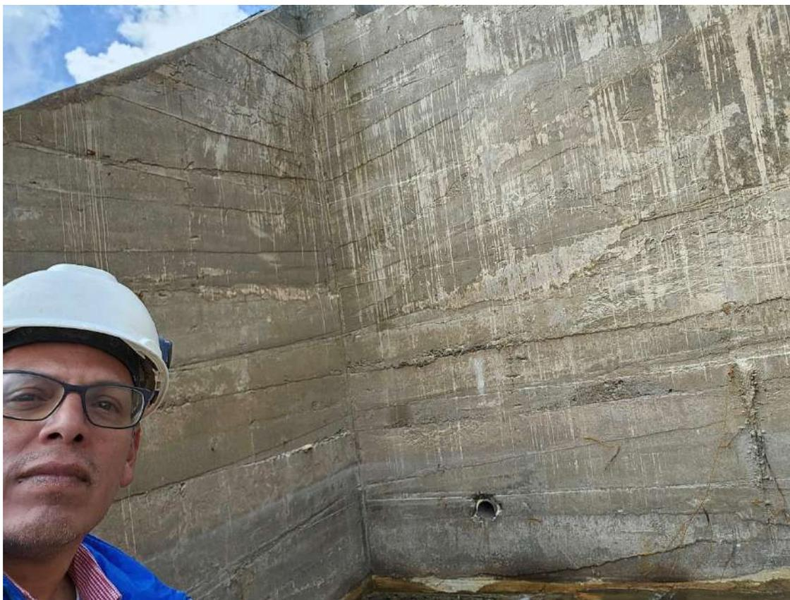
Figura N° 23: Filtraciones en la cimentación del dique de concreto de la presa Yarcán.
