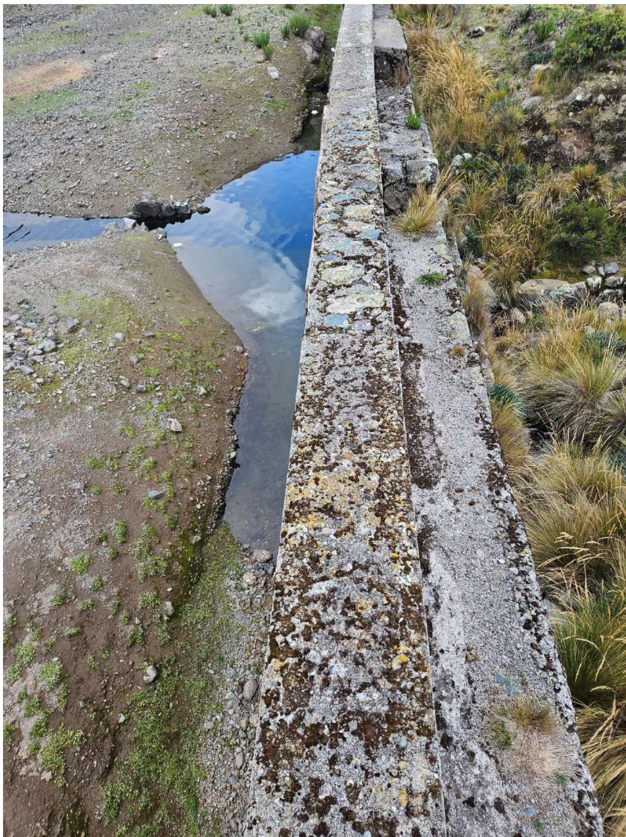
Figura N° 7: Corona de la presa Tambillo.
