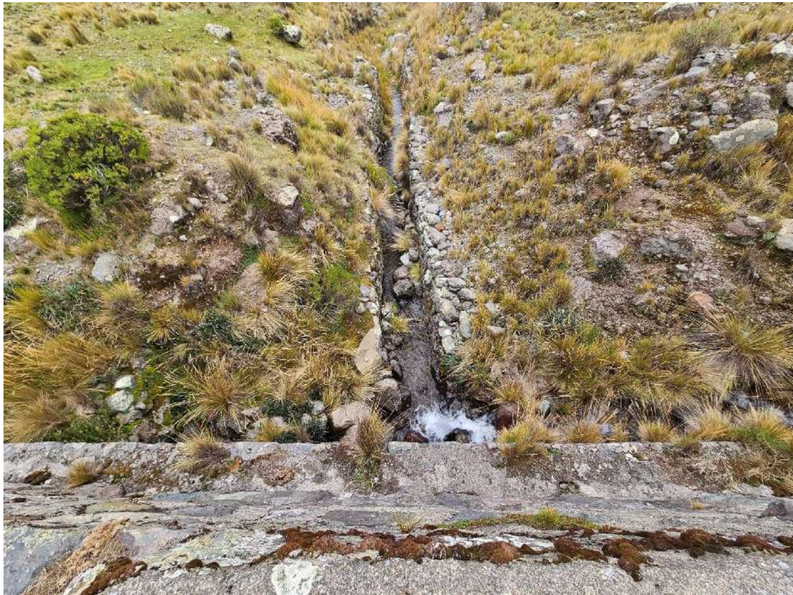
Figura N° 16: Aliviadero ubicado en el estribo derecho de la presa Tambillo.
