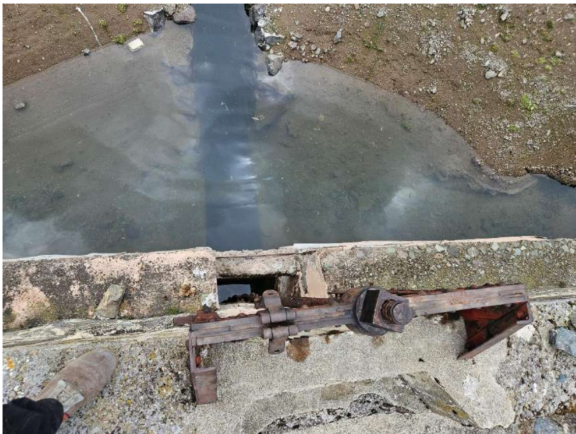
Figura N° 18: Compuerta metálica sin volante de descarga de la presa Tambillo.
