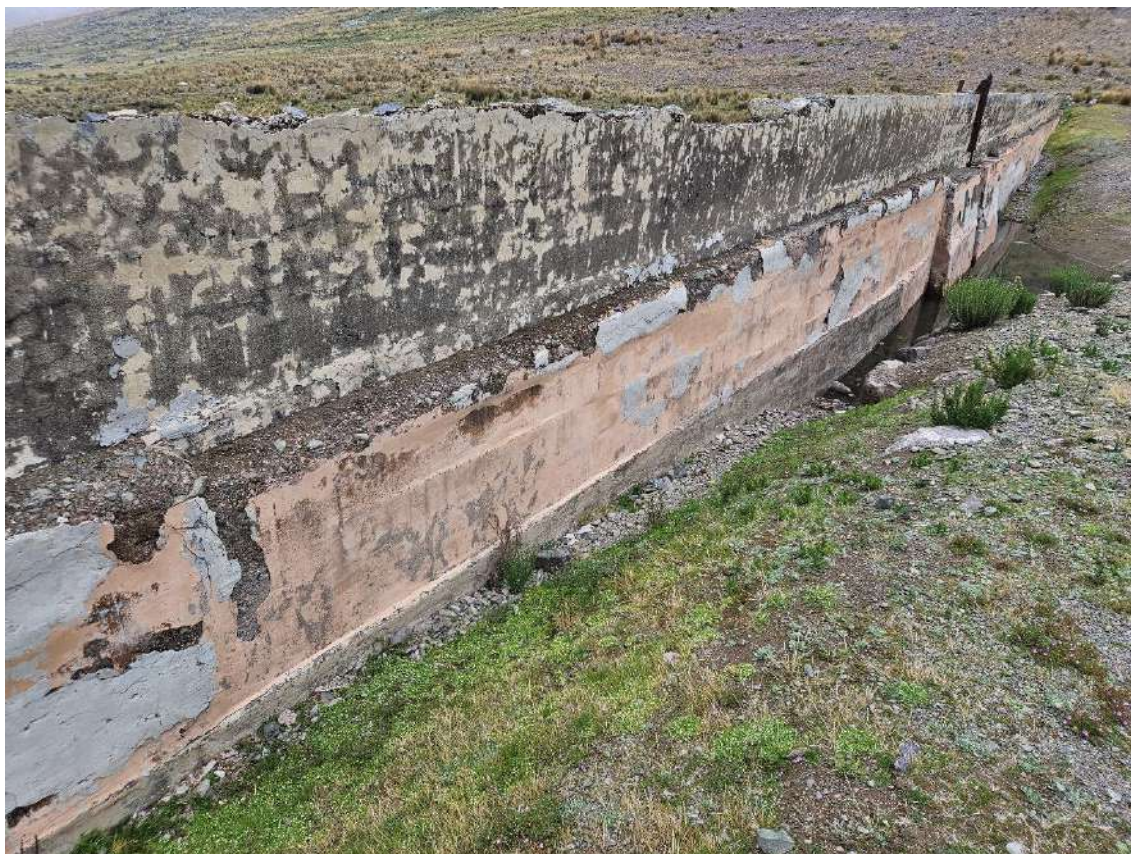
Figura N° 9: Paramento aguas arriba de la presa Tambillo.
