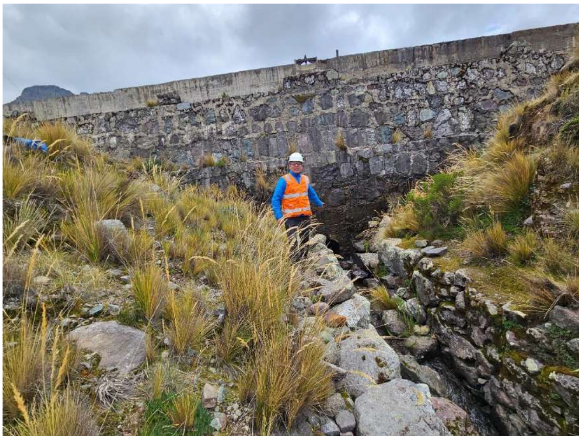
Figura N° 21: Paramento agua abajo de la presa Tambillo.
