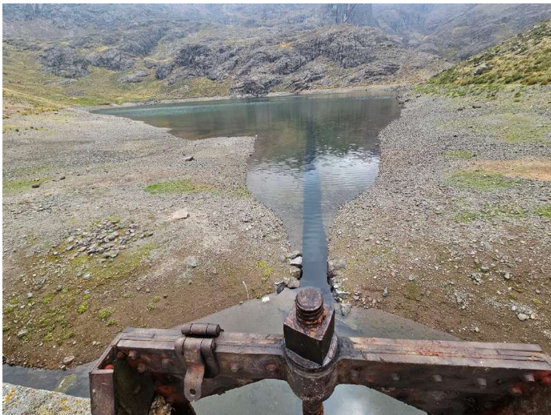
Figura N° 18: Compuerta metálica sin volante de descarga de la presa Tambillo.
