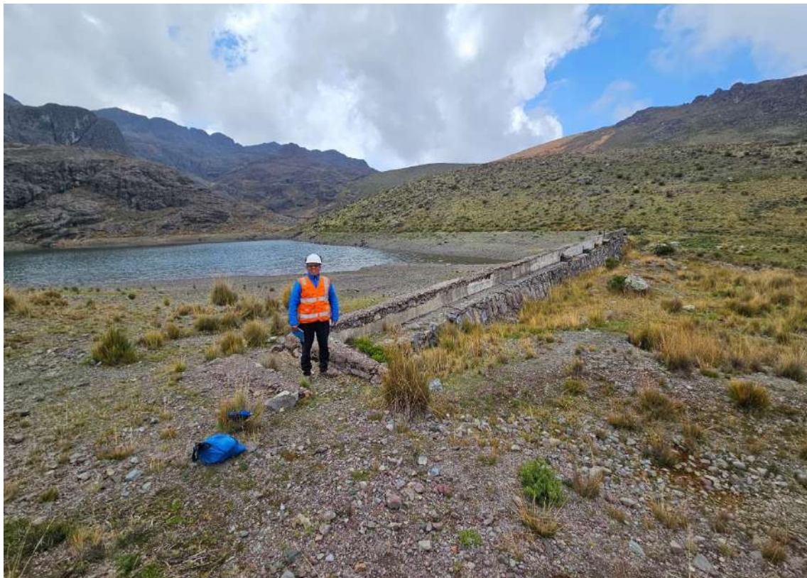
Figura N° 16: Aliviadero ubicado en el estribo derecho de la presa Tambillo.
