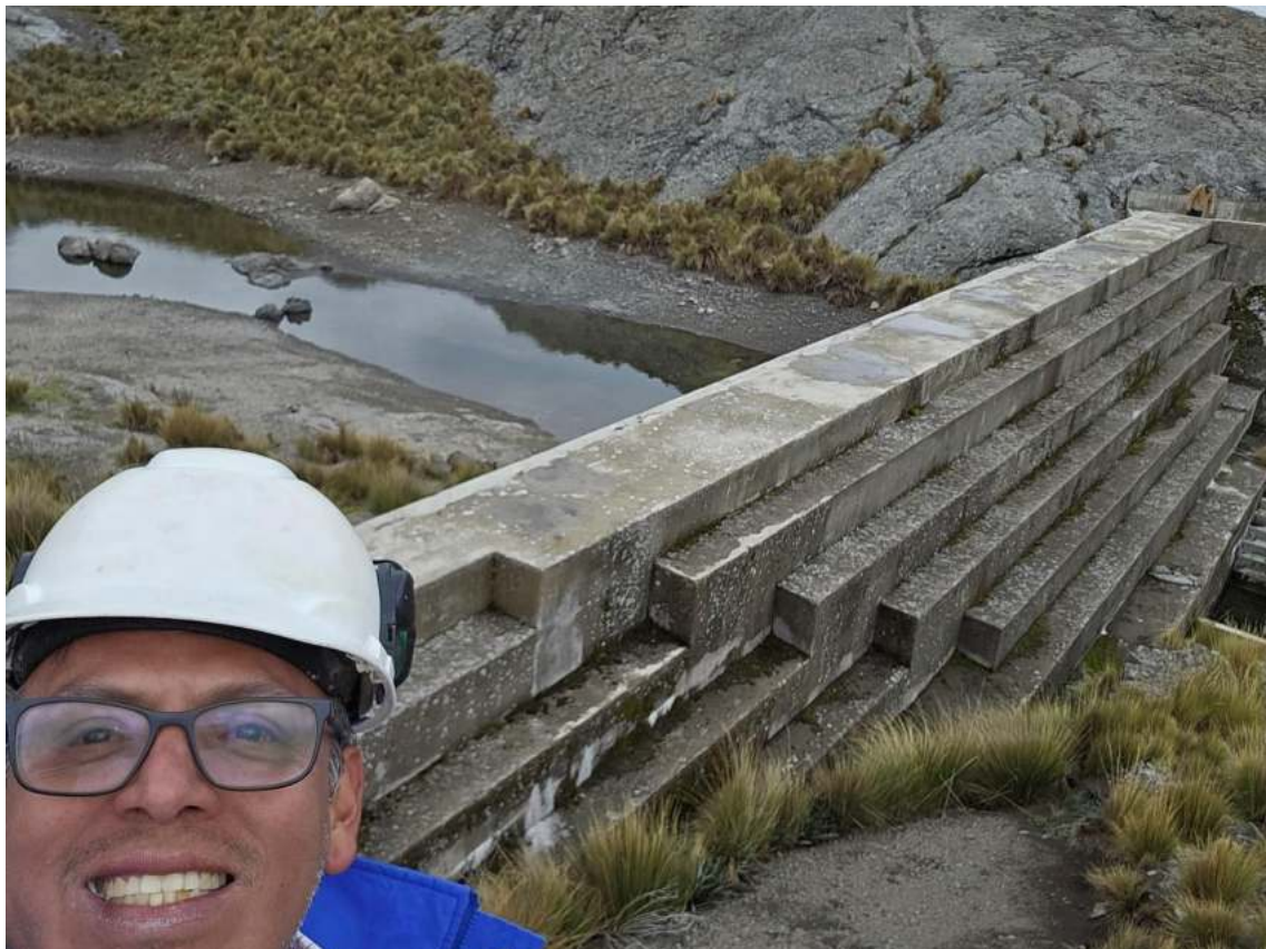
Figura N° 17: Corona y paramento aguas abajo de la presa Acomachay.
