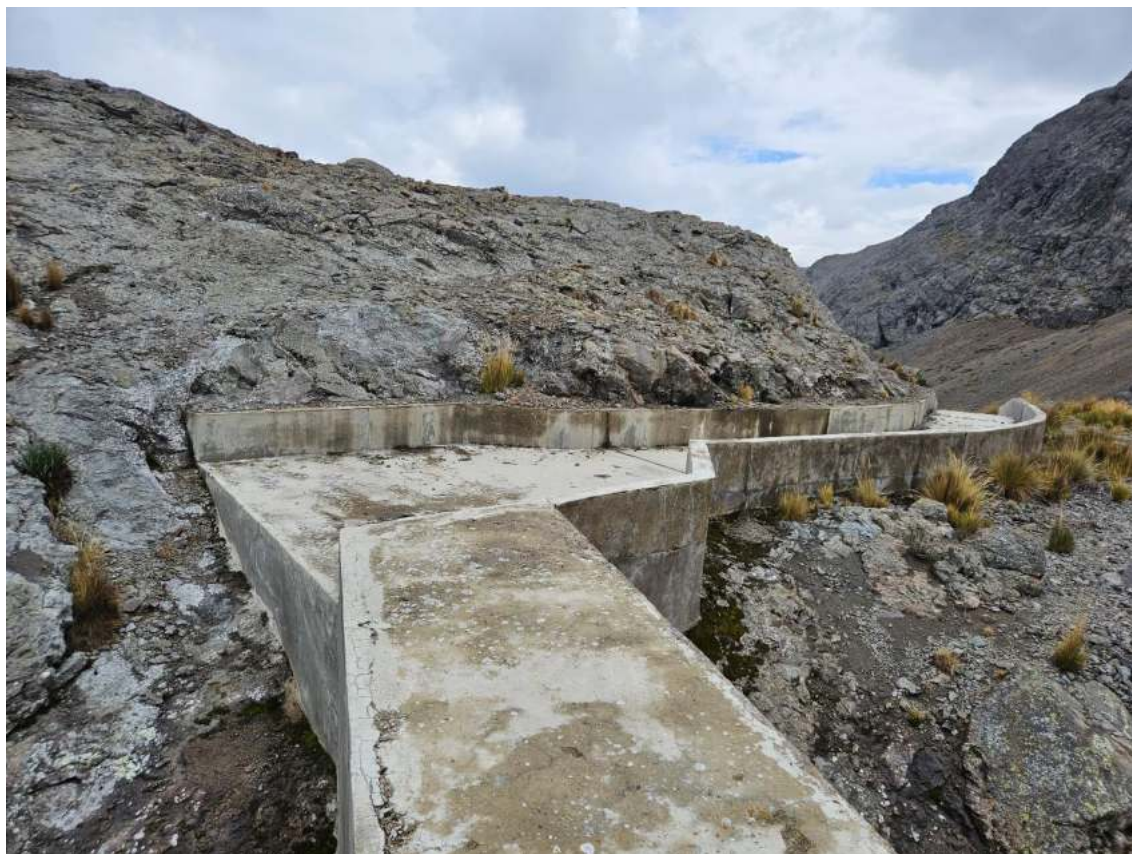
Figura N° 12: Vista general del aliviadero de demasías de la presa Acomachay.
