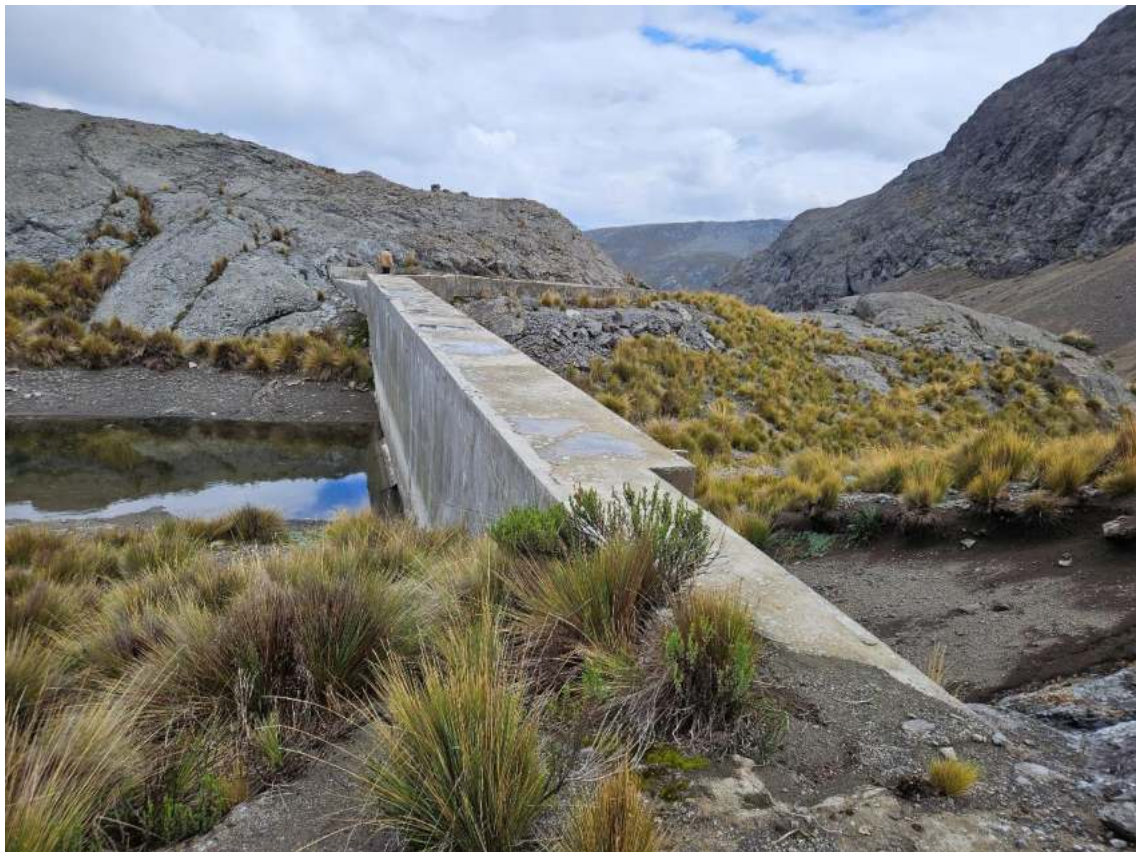
Figura N° 4: Corona del dique de la presa Acomachay.
