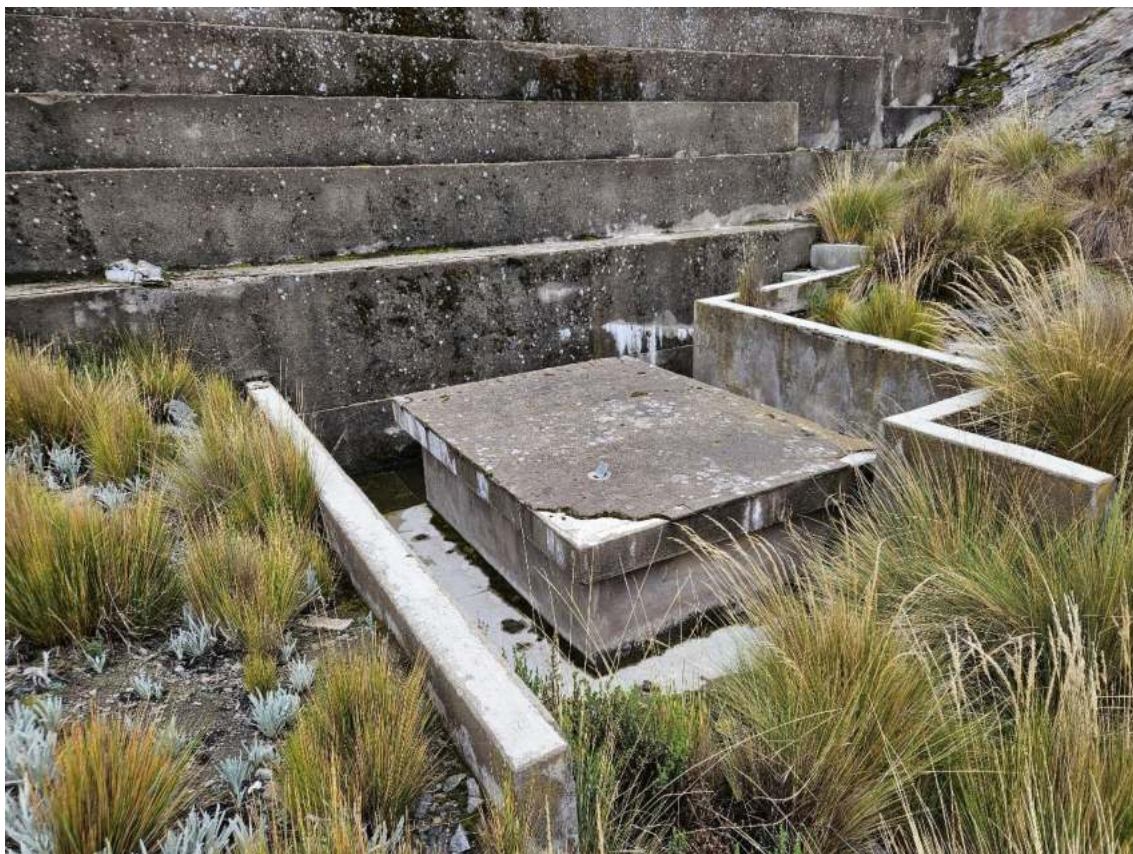
Figura N° 18: Cámara de descarga de la presa Acomachay.
