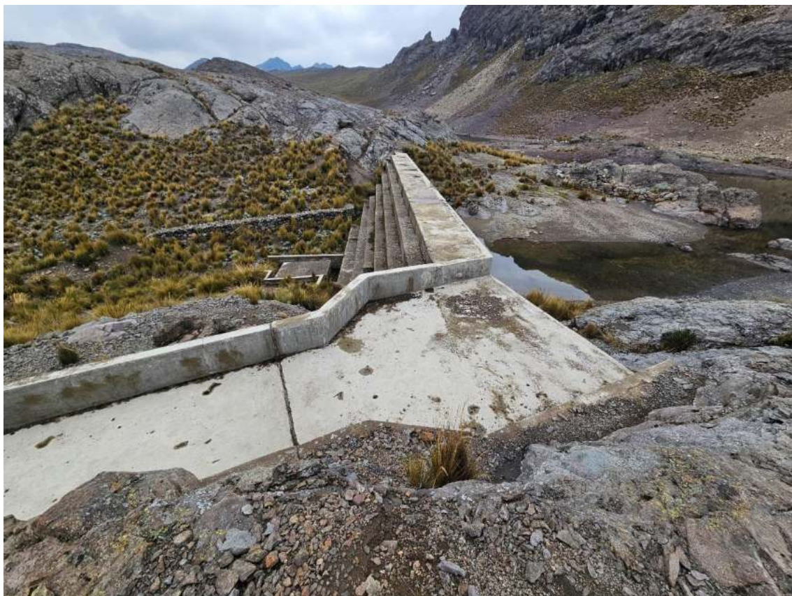
Figura N° 14: Vista general del aliviadero de demasías de la presa Acomachay.
