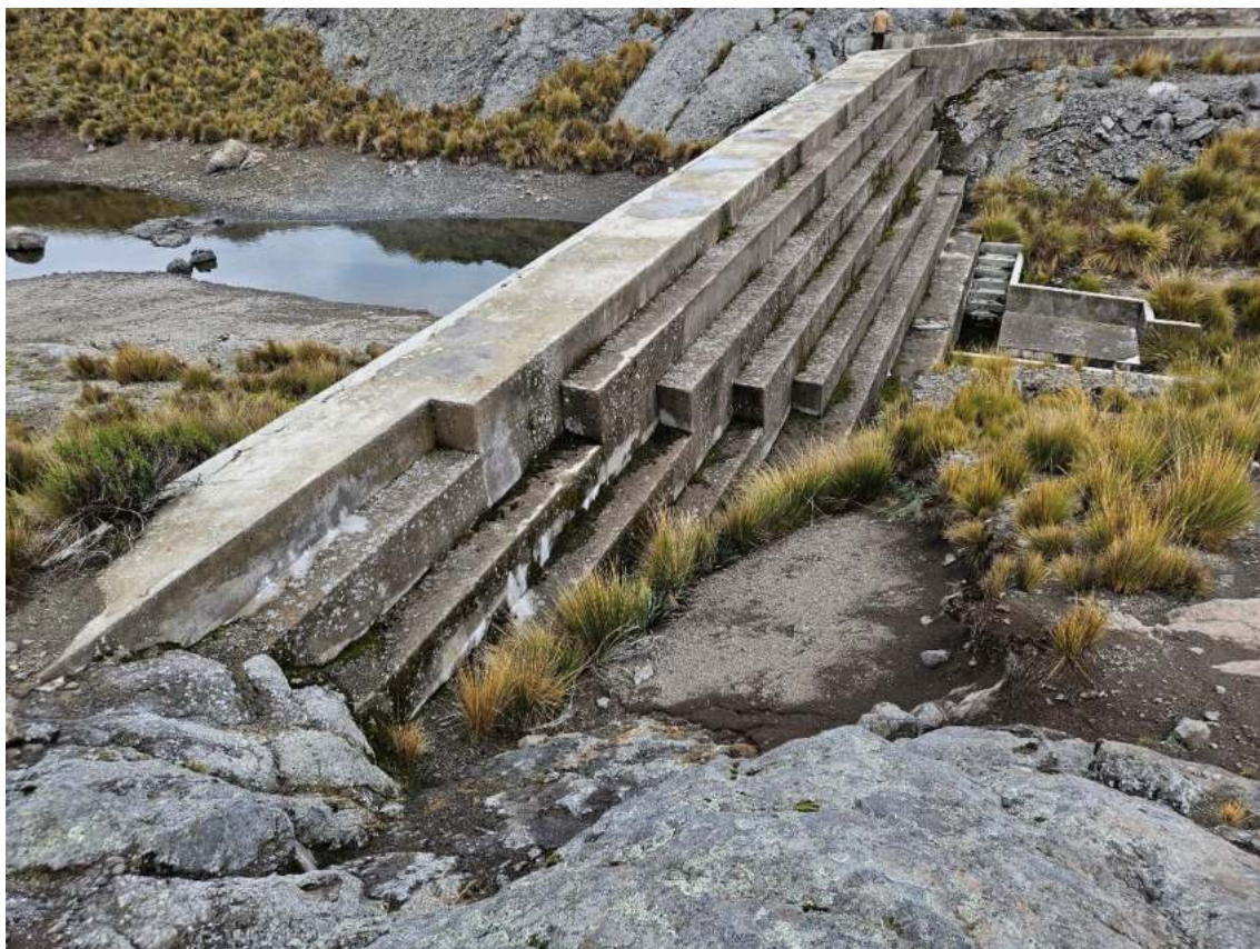
Figura N° 6: Paramento aguas arriba de la presa Acomachay.
