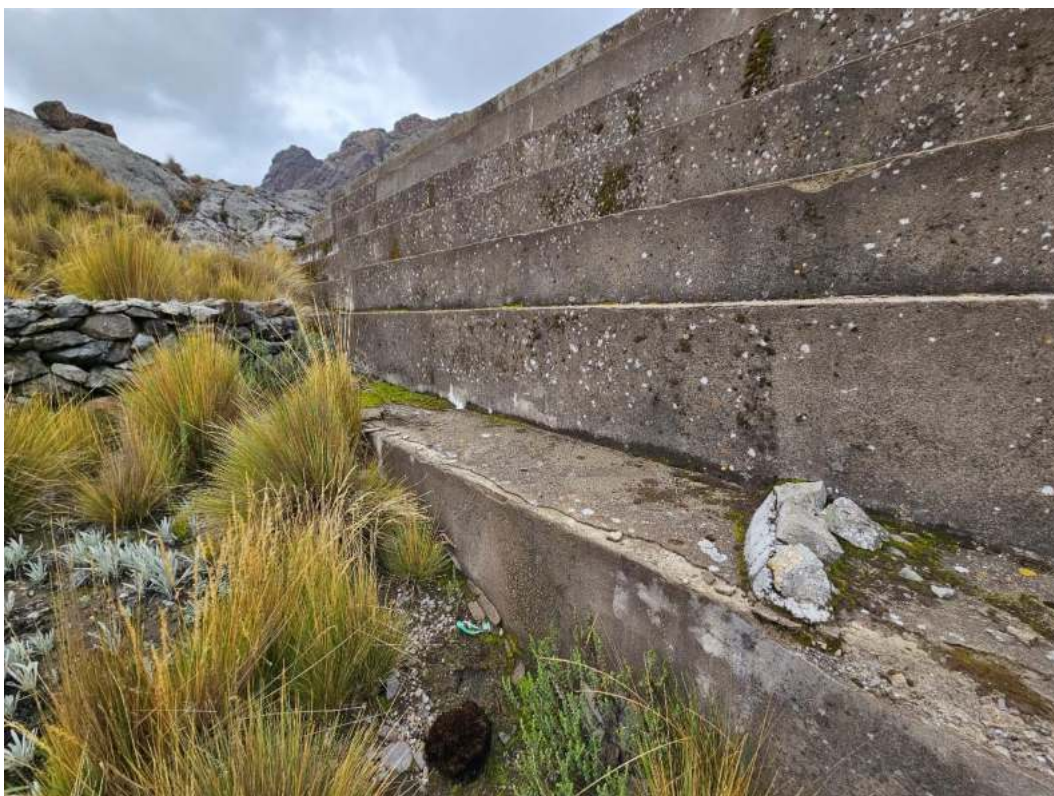
Figura N° 16: Erosión externa del paramento aguas abajo de la presa Acomachay.
