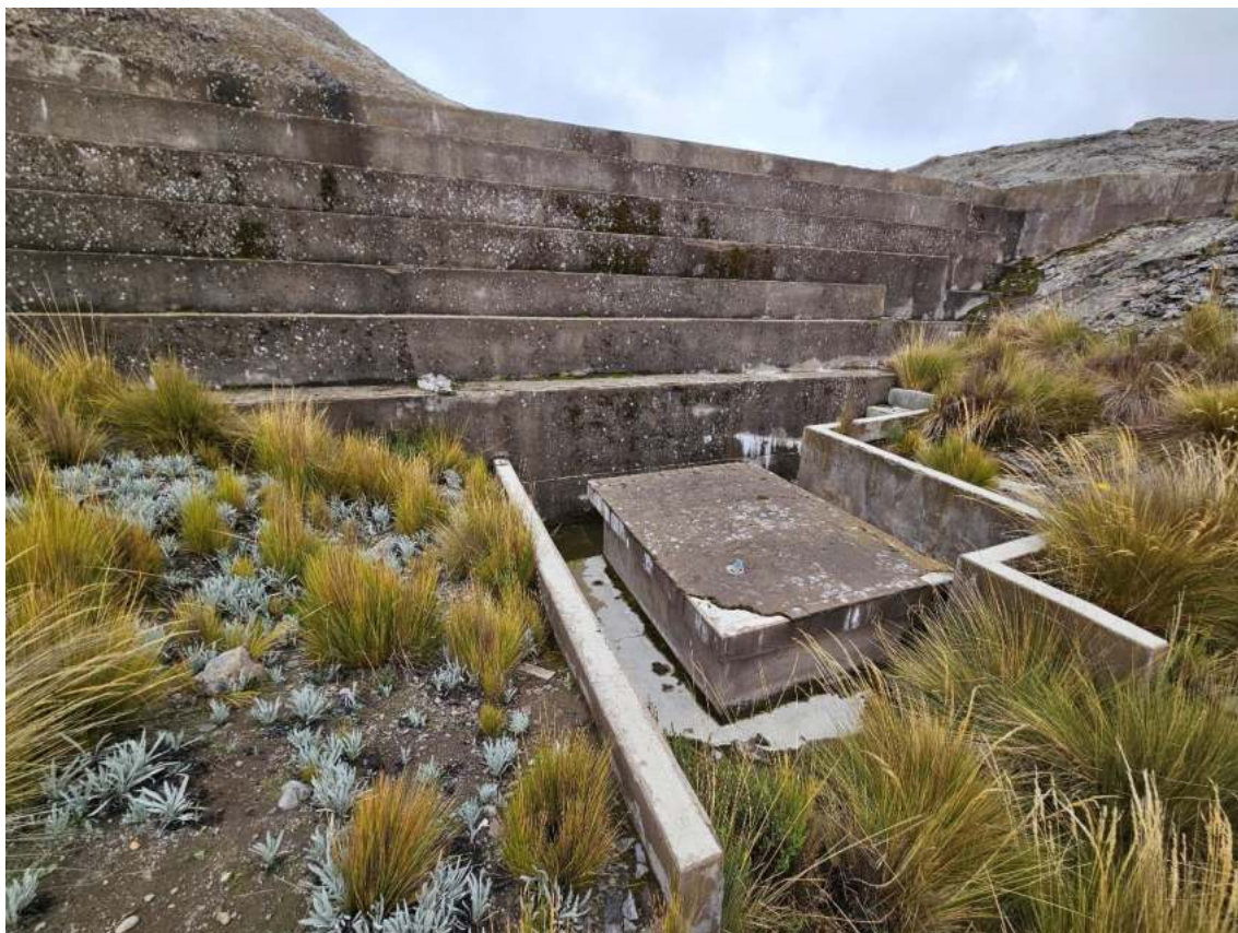
Figura N° 18: Cámara de descarga de la presa Acomachay.
