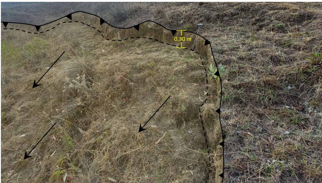
Figura 9. Escape de deslizamiento con un desplazamiento vertical de 0.30 m.
