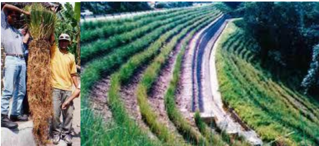
Fotografía 4. Ejemplo de bioingeniería con arbusto (vetiver) en taludes de materiales sueltos.
