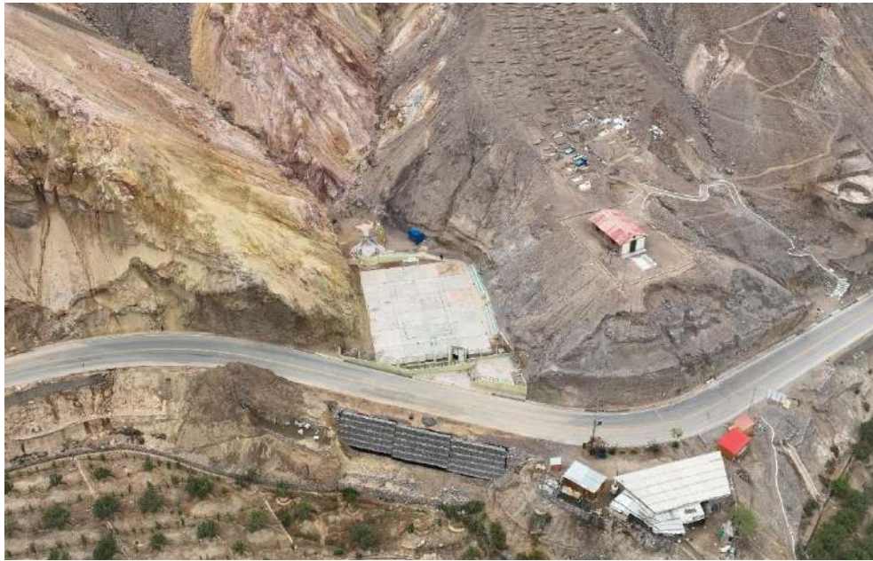
Fotografía 55 Punto crítico 02 Losa deportiva
