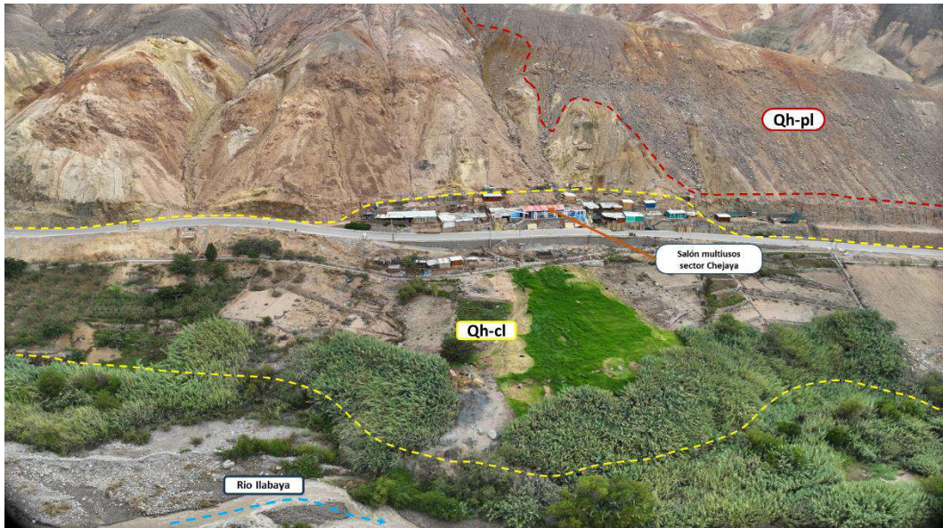
Fotografía 33 Vista aérea de depósitos proluviales (Qh-pl) por encima del corte de talud de la carreta del sector de Chejaya
