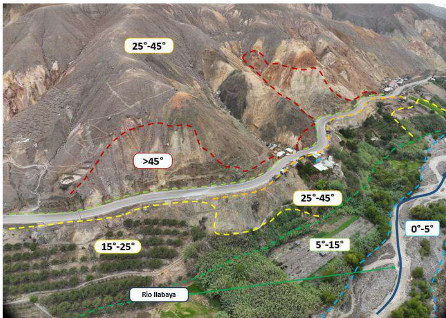
Fotografía 46 Fotografía aérea de las pendientes presentes en la margen derecha del rio Ilabaya
