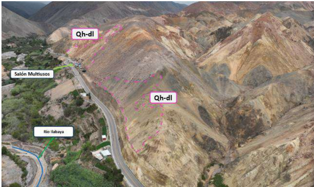
Fotografía 35 Identificación de depósitos deluviales (Qh-dl) en la parte superior de la carreta de Chejaya
