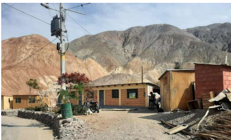
Fotografía 15 Red pública de alumbrado
