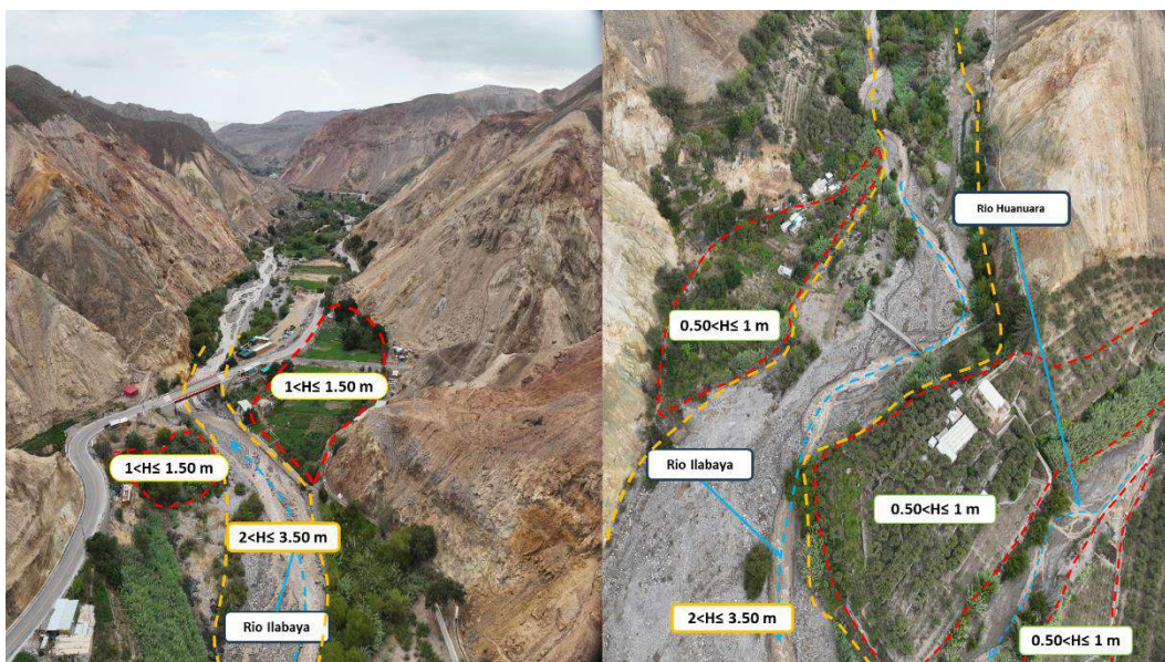
Fotografía 52 Identificación de la altura de sedimentación en los alrededores del puente Chejaya
