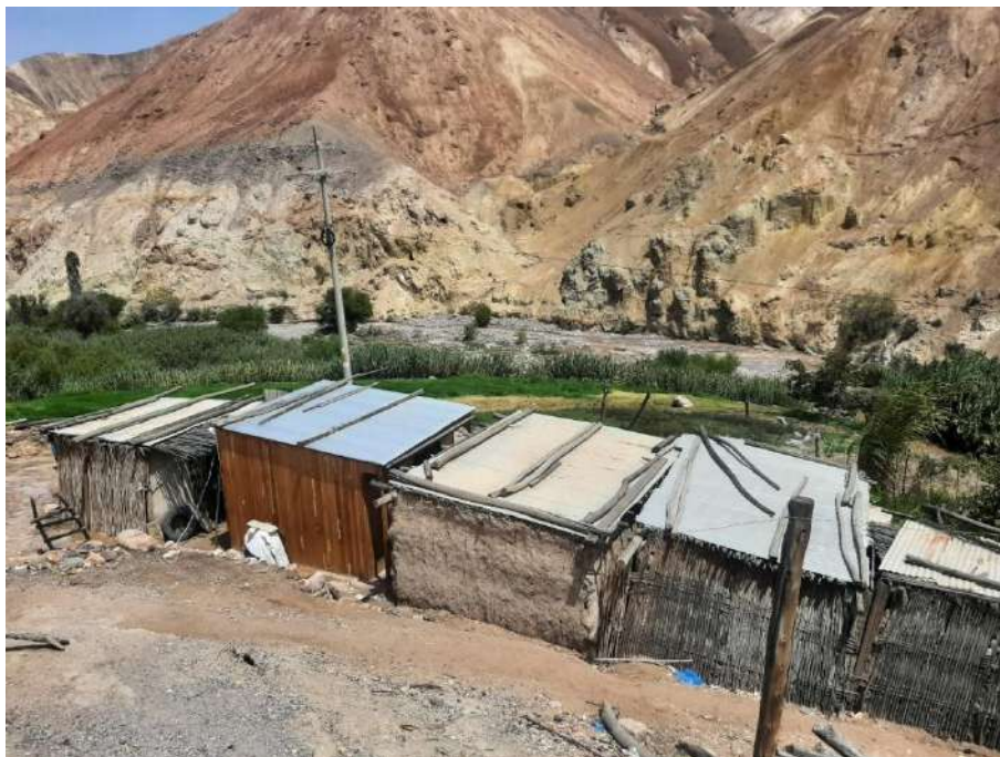
Fotografía 5 Trabajo de Campo Vivienda de Techo de Calamina
