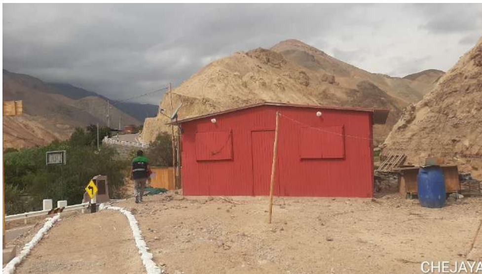
Fotografía 10 Trabajo de campo vivienda de módulo de madera estado de conservación regular
