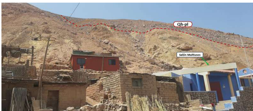
Fotografía 32 Identificación de depósitos Proluviales (Qh-pl) en la parte superior del salón multi usos.
