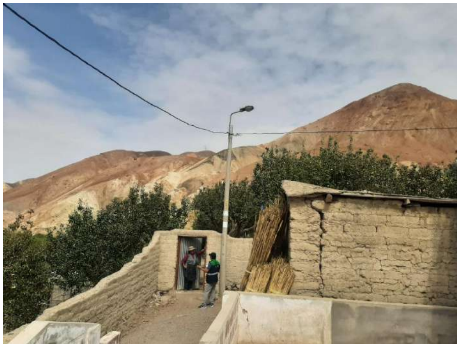
Fotografía 6 Trabajo de Campo Vivienda de Adobe
