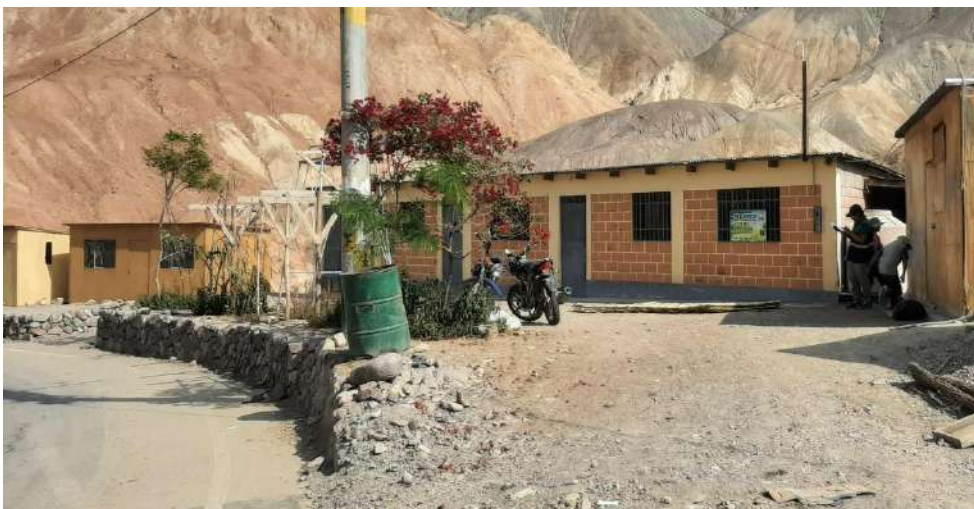
Fotografía 20 Depósito de Residuos Solidos
