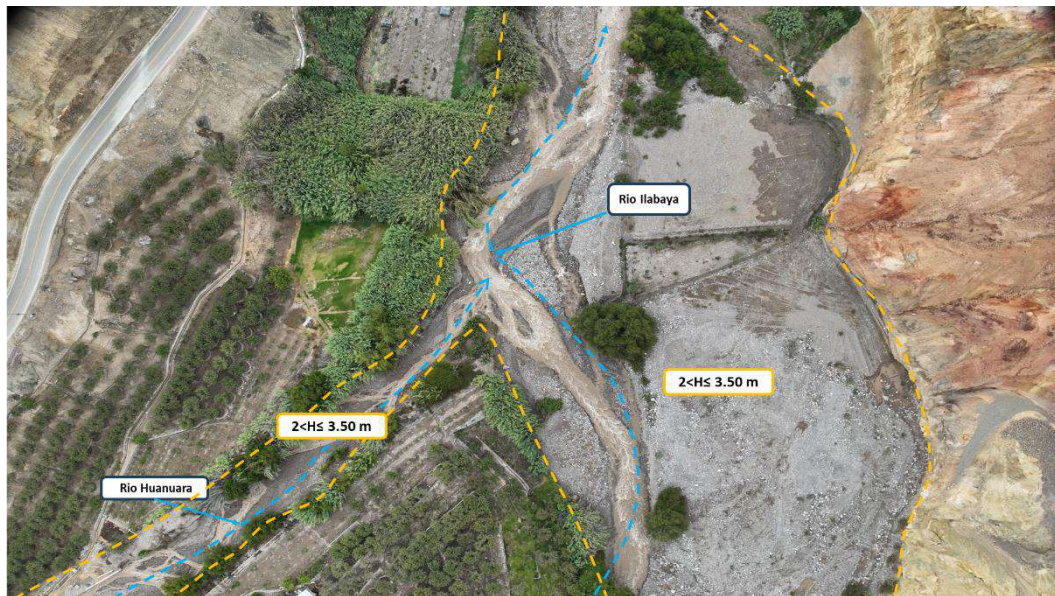
Fotografía 48 Identificación de la altura de sedimentación en el canal del rio Ilabaya y Rio Huanuara
