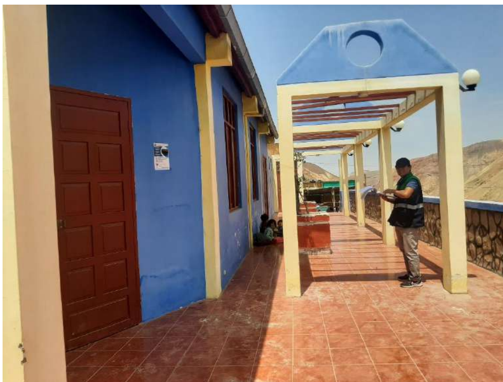
Fotografía 11 Trabajo de campo local multiusos de concreto armado
