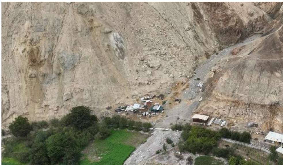
Fotografía 58 Punto crítico 05, lote 33
