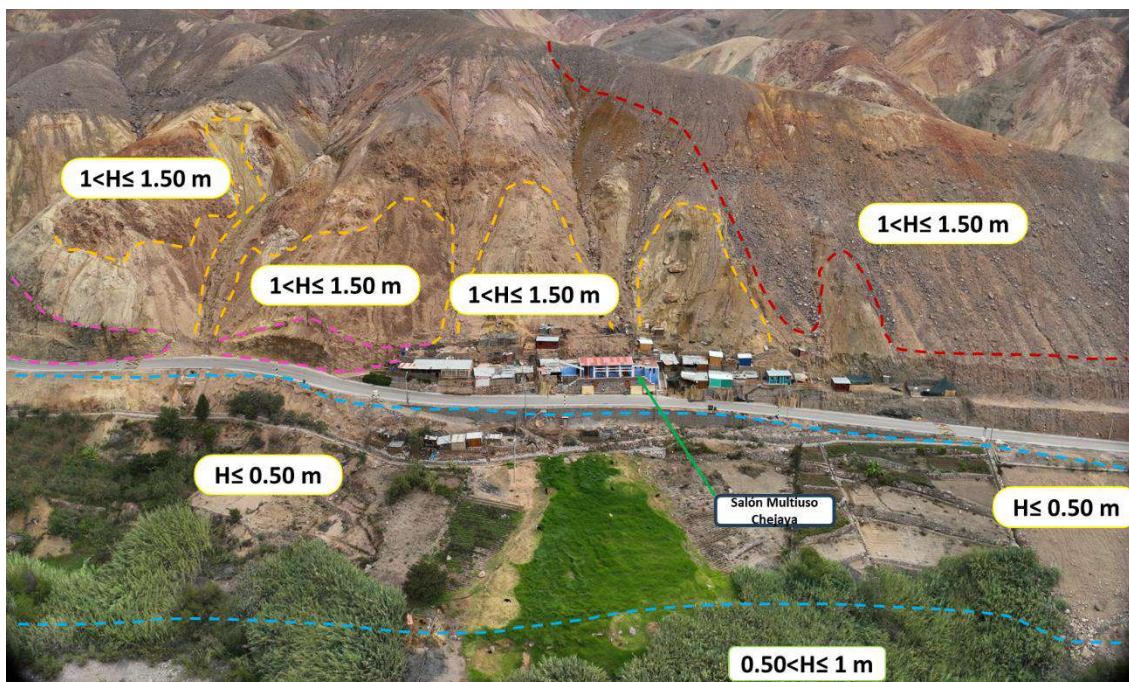
Fotografía 50 Identificación de la altura de sedimentación en los alrededores del salón multiusos
