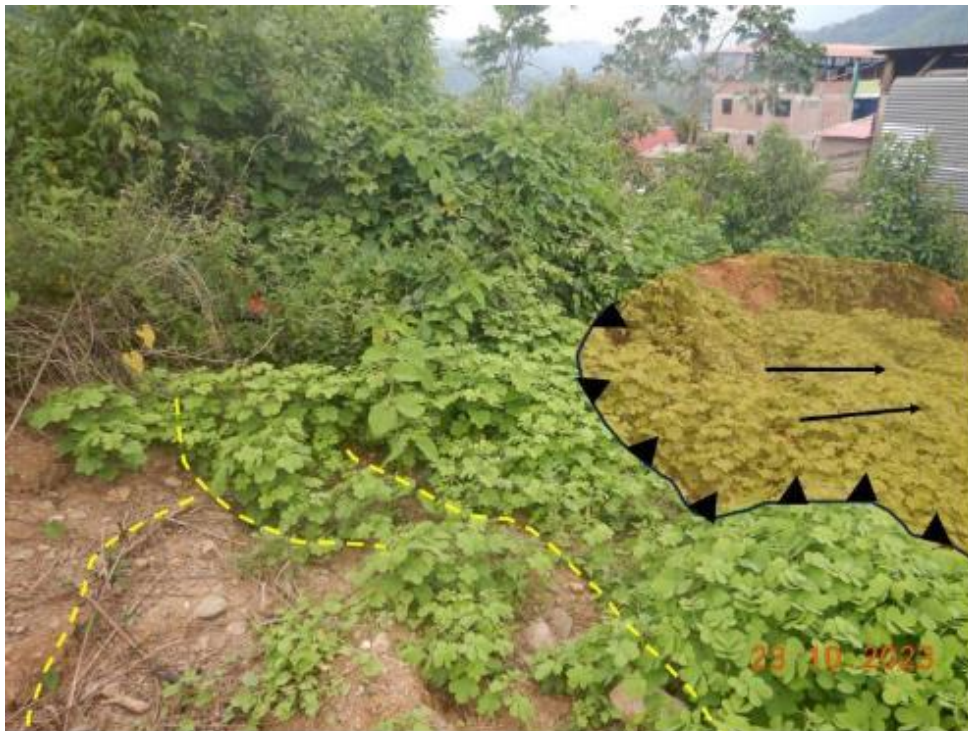
Figura 9. Se aprecia las grietas con avance retrogresivo ubicadas detrás de la escarpa principal.
