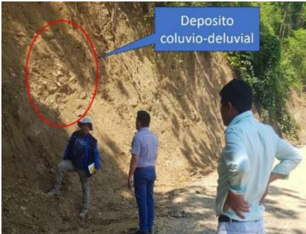
Figura 3. Vista tomada en la parte baja de la ladera, se aprecia el depósito coluvio-deluvial con bloques de hasta 12 cm de diámetro.
