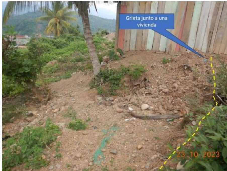
Figura 10. Se aprecia la grieta que pasa por la vivienda, este avance del deslizamiento puede afectar a la vivienda.
