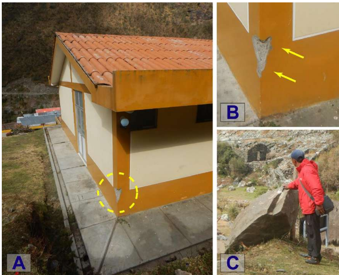
Figura 16. A. Centro de salud de Sune Grande afectado por la caída de una roca en marzo del 2021. B. Se observa el daño generado por el impacto de la roca en la columna. C. Bloque de roca emplazado a 12 m después del impacto.
