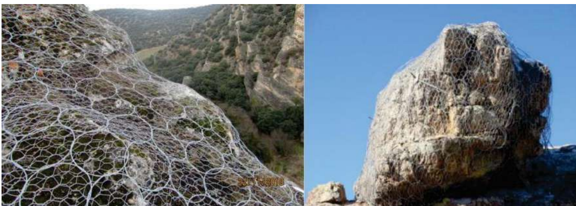
Figura 25. Ejemplos de estabilización con red de anillos
