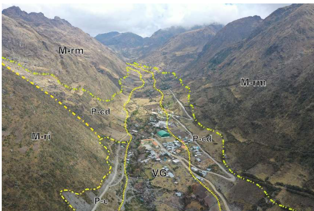
Figura 10. Vista hacia el suroeste de las distintas subunidades geomorfológicas: La subunidad de vertiente de gelifractos (VG) y sobre la cual se asienta la población de Sune Grande; la subunidad de piedemonte coluvial (P-c) y coluvio-deluvial (P-cd) conformado por material inconsolidados localizados al pie de las subunidades de montañas en rocas intrusivas (M-ri) y metamórficas (M-rm).
