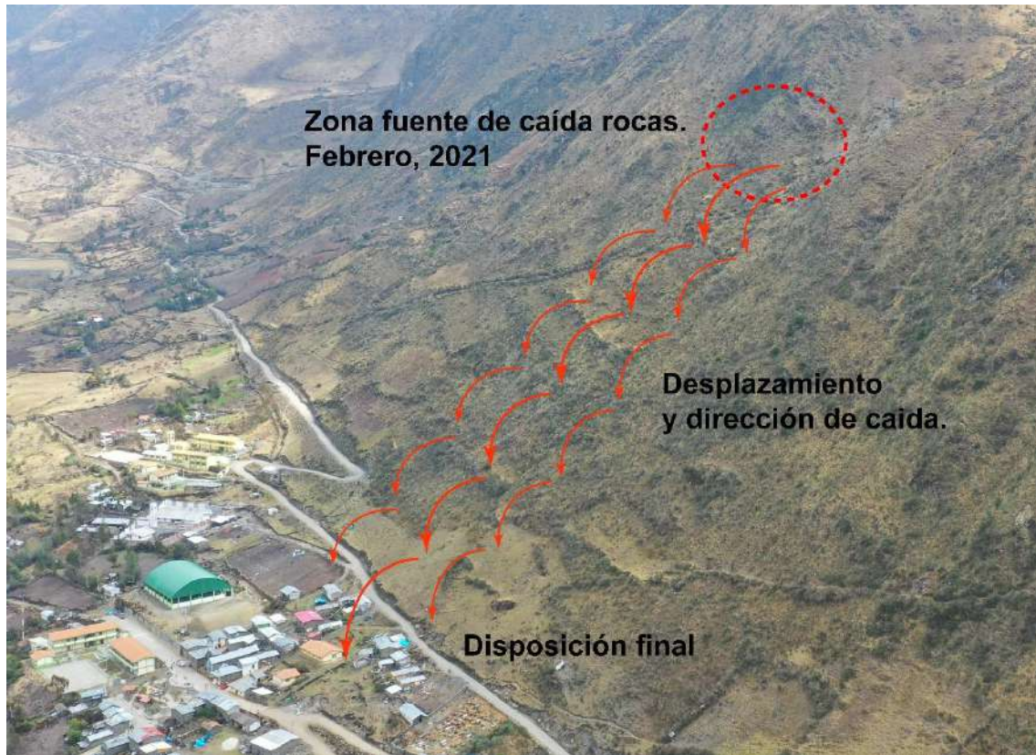
Figura 12. Representación esquemática que muestra la caída de rocas de la ladera este del cerro Llactajuruy, que se originó en febrero del 2021. Se observa la fuente y posible trayectoria de rocas que afectaron el puesto de salud del centro poblado.
