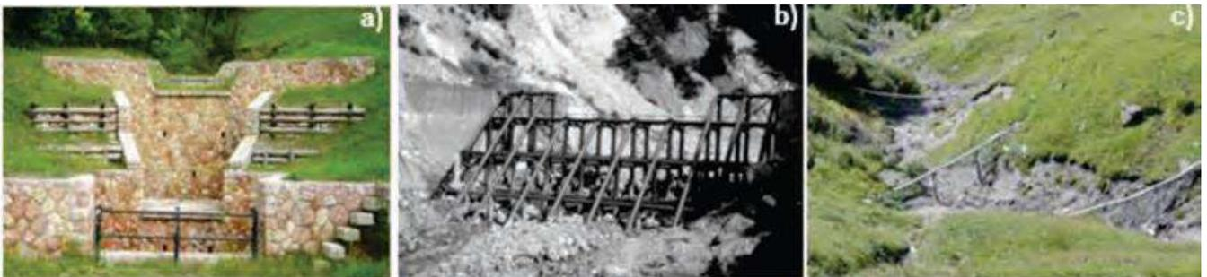
**Figura 4.** Presas tipo SABO de sedimentación escalonada para controlar la fuerza destructiva de los huaicos: A) de control; B) tipo rejilla; C) barras flexibles.
