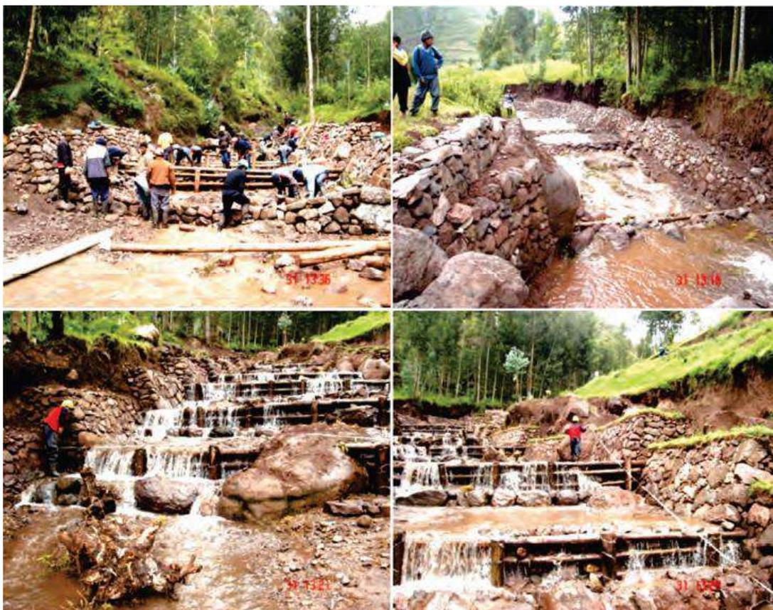
**Figura 5.** Construcción de disipadores de energía de las corrientes concentradas en el cauce de la quebrada, mediante diques transversales (enrocado y armazón de troncos) y canalización del cauce con muros laterales escalonados utilizando bloques de rocas para mitigar los efectos
