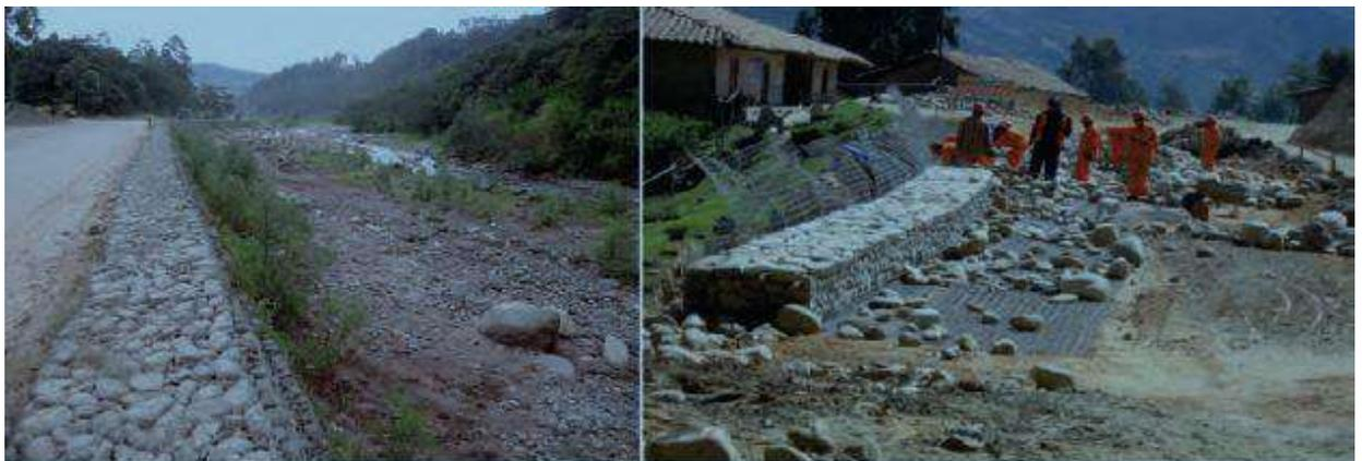
**Figura 14.** Muro de gaviones para protección de carretera.
