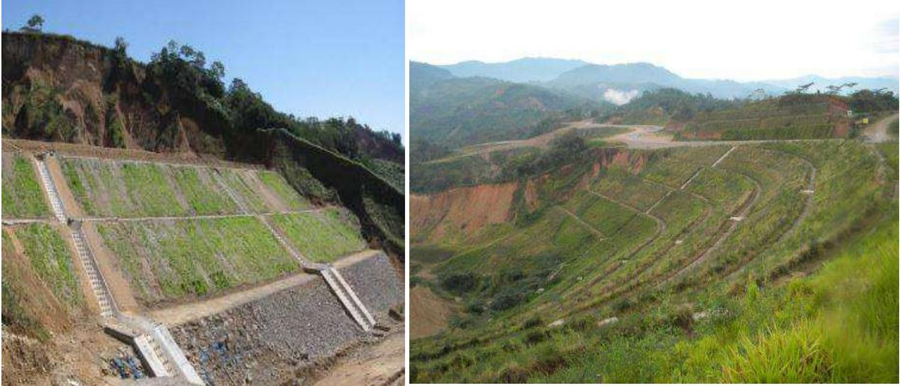
**Figura 13.** Revegetación de taludes y manejo de aguas mediante el uso de geosintéticos y la bioingeniería de suelos en el Km 22+800 al 23+900 de la Carretera Tingo María-Pucallpa - Sector Las Vegas, Huánuco
