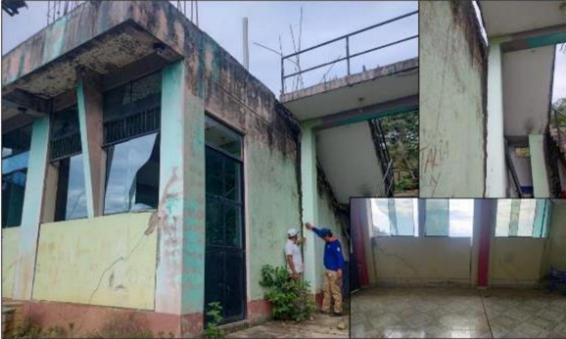
**Fotografía 11.** Se aprecia el salón comunal, las paredes están inclinadas ( $3^\circ$ ) y presenta agrietamientos con aperturas de hasta 5 cm.
