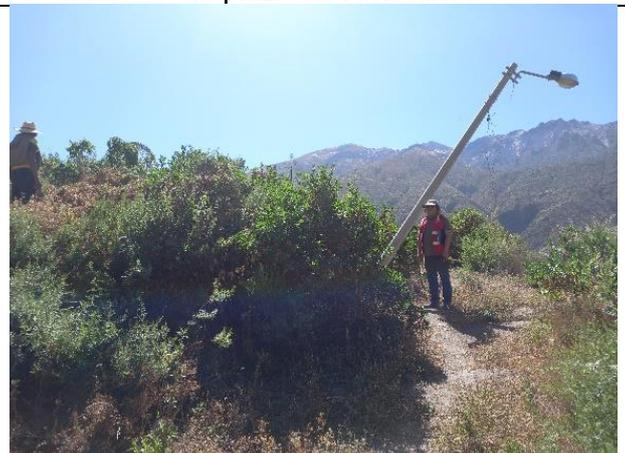
FOTO 30.- Daños severos a los servicios de alumbrado, prácticamente inutilizable.
