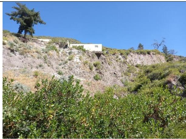
FOTO 18.- Infraestructura que se encuentra en el borde de la zona donde se suscitó el deslizamiento..
