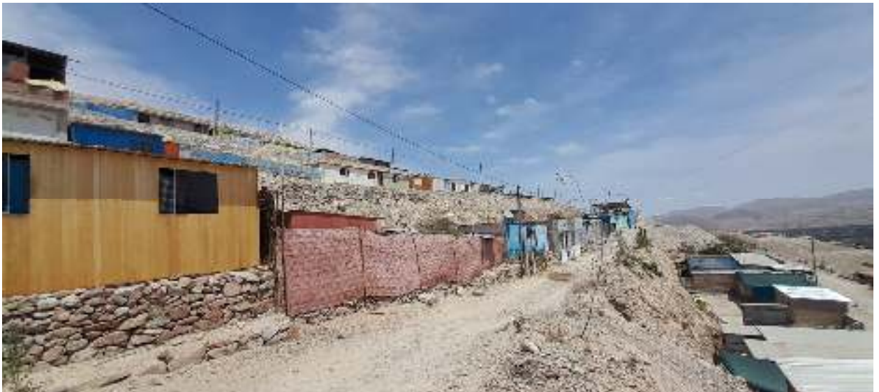
FOTO 11: Vista de las viviendas de la Asoc. Alto Solar, asentada en terrazas sin medidas de mitigación del riesgo.
