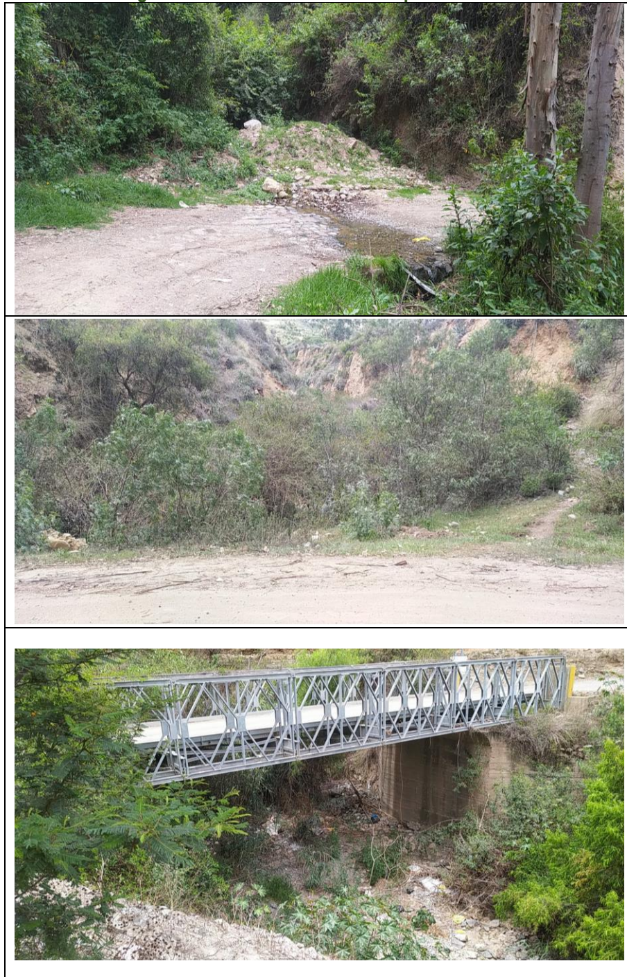
Fotografía N° 21. Visitas de campo realizadas a las zonas críticas
