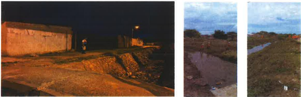
**Figura N° 14: Poza de Oxidación, colmatada**
