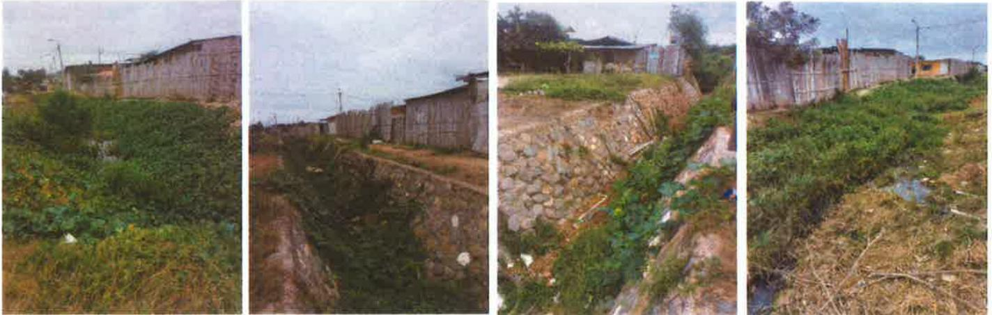
Figura N° 18: Canal Internacional, se aprecia su cauce colmatado y acumulación de residuos
