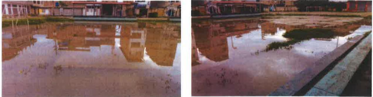
**Figura N° 13: Quebrada Marco Felipe, se aprecia su cauce colmatado y un tramo afectado por la formación de cárcavas**
