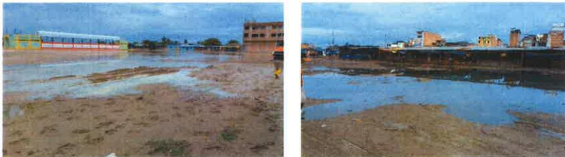
**Figura N° 11: Sector Puerto Perú, se aprecia flujo de lodo con aguas estancadas, por la falta de drenaje pluvial**
