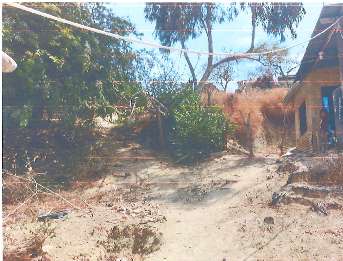
Figura N° 15. Sector La Jota, se aprecia talud inestable con material suelto
