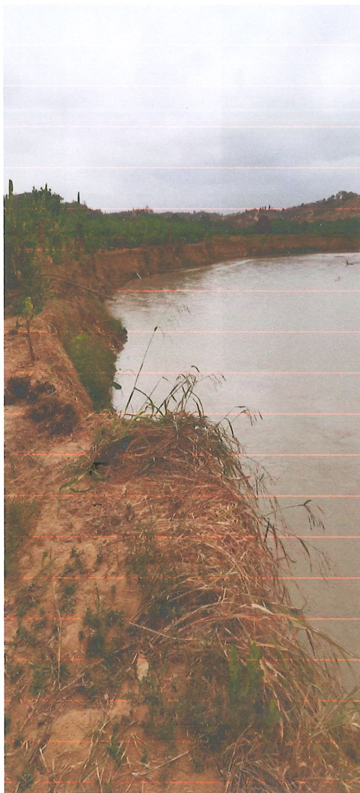
Figura N° 3. Sector Vista Hermosa, centro poblado Malval, se aprecia derrumbes del talud de tierra en la Margen Izquierda del Río Tumbes, que vienen generando pérdida de tierras agrícolas
