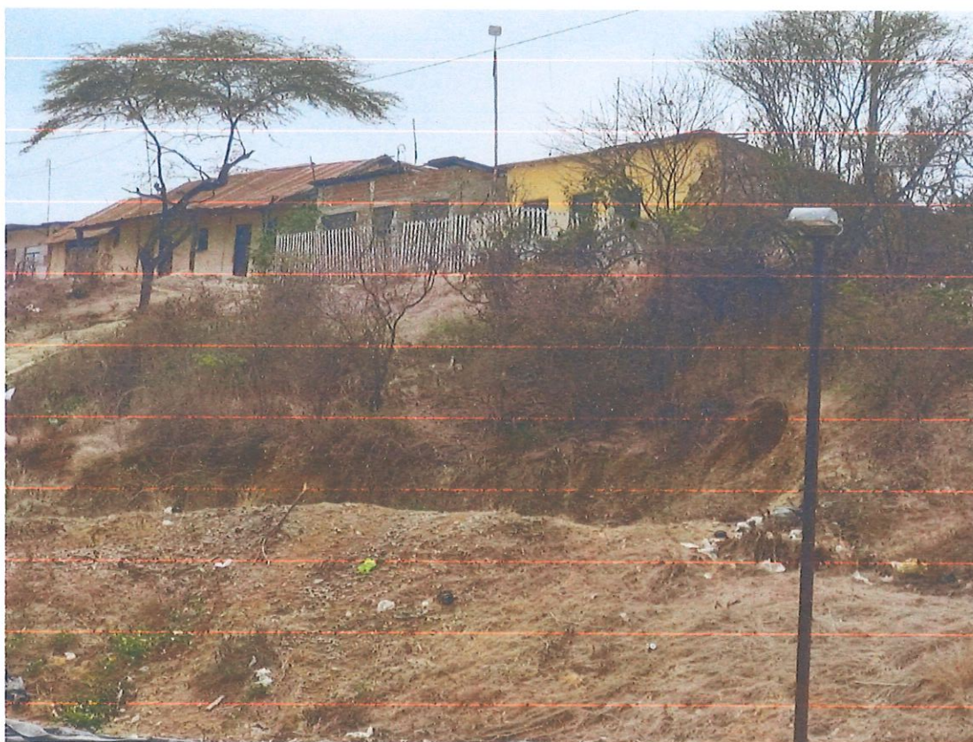
Figura N° 6. Sector San Francisco, se aprecia talud inestable con material suelto
