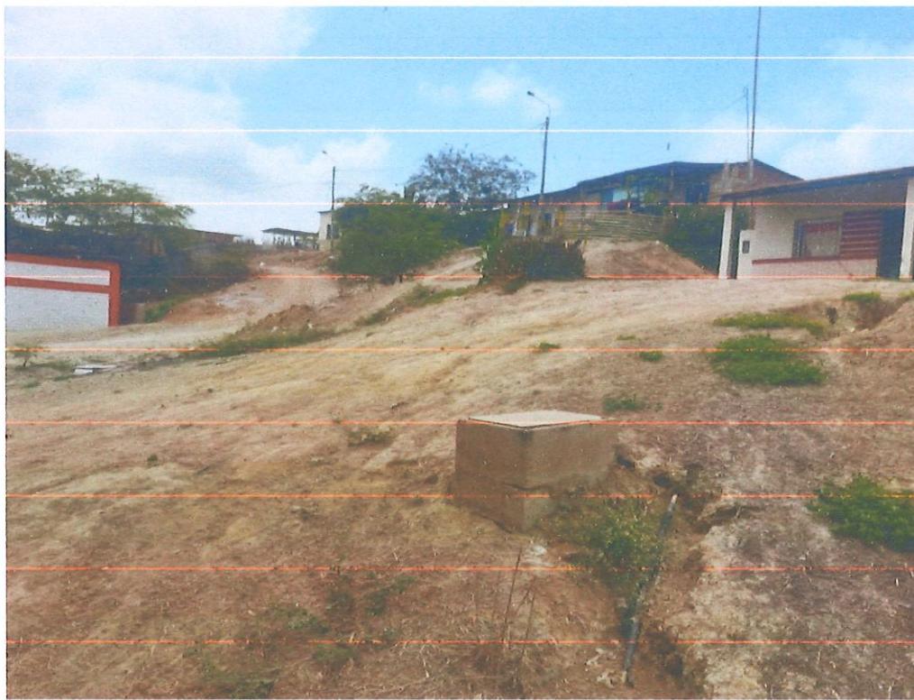
Figura N° 5. Sector El Rodeo, se aprecia talud inestable con material suelto
