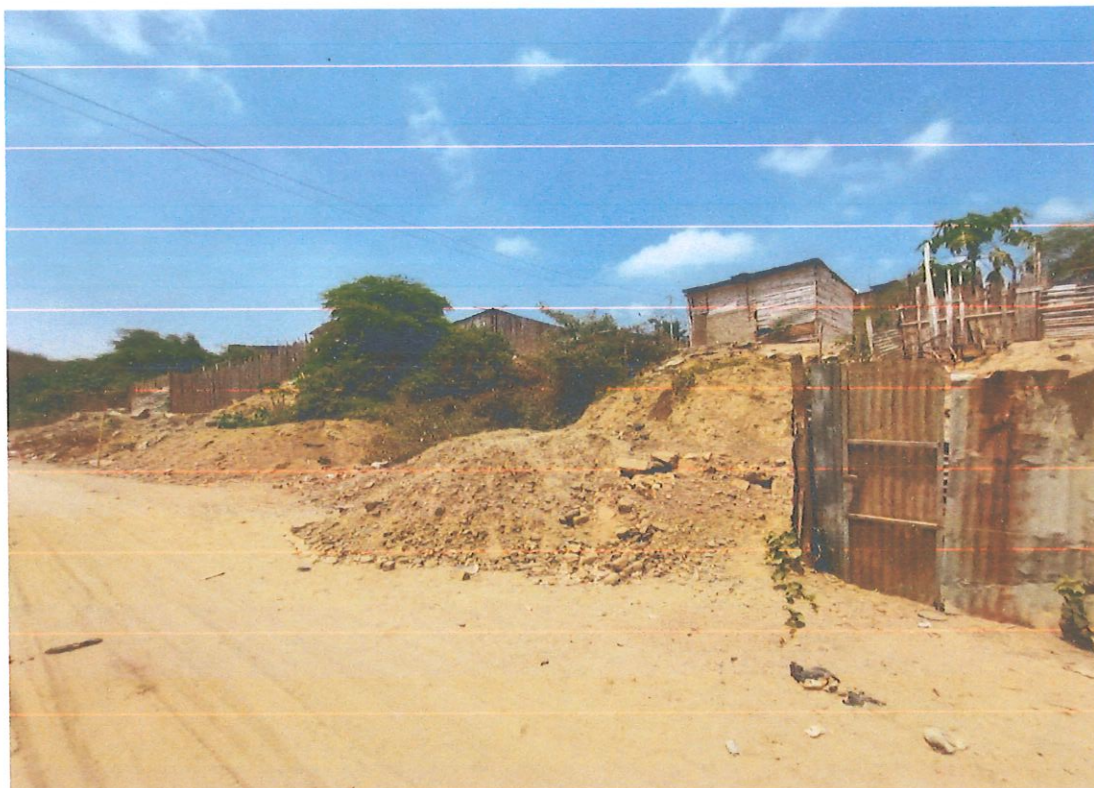
Figura N° 11. Sector Cabeza de Vaca, se aprecia una torrentera colmatada con surcos y cárcavas
